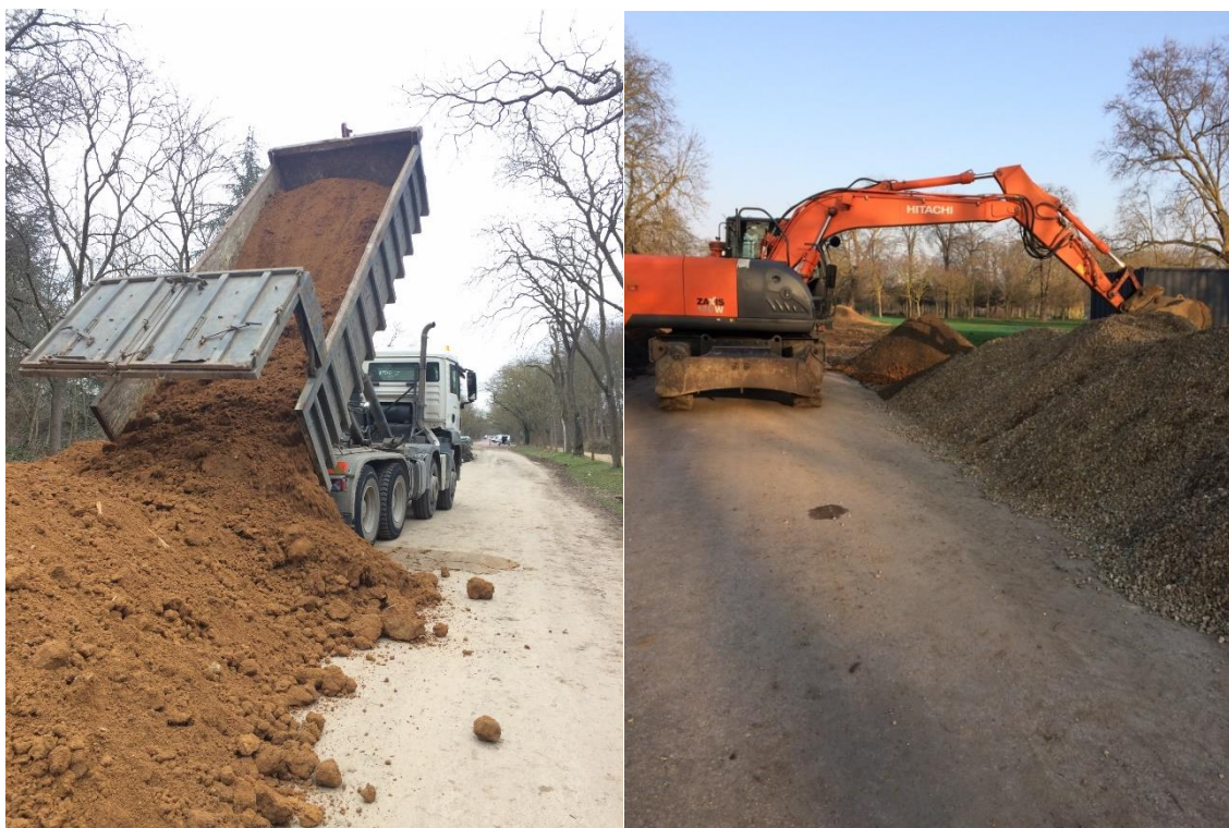
Figure A2 : Réception des terres excavées issues de chantiers (gauche) et un tractopelle mélangeant les matériaux pour les fosses d'arbre (droite)
