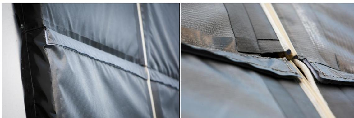
*Figure 108 : Photos de la pose in situ des panneaux, avec la méthode d'assemblage mixte rails+joncs et velcro. A gauche l'assemblage horizontal en velcro, à droite l'assemblage vertical par rail PVC.*
