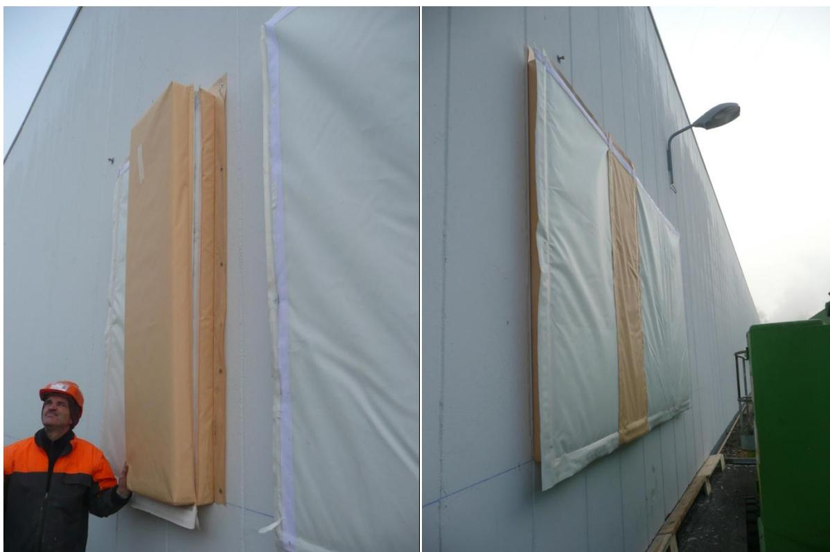
*Figure 105 : Photos du deuxième groupe de panneaux posés in situ. A gauche la pose du panneau 5, à droite le résultat final.*
