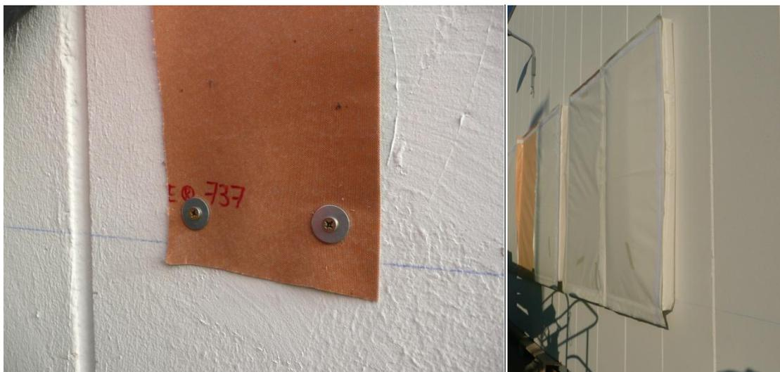
*Figure 107 : Photos de la pose in situ des panneaux fixés par bandes auto-agrippantes. A gauche la bande auto-agrippante vissé au mur, à droite les deux panneaux posés.*
