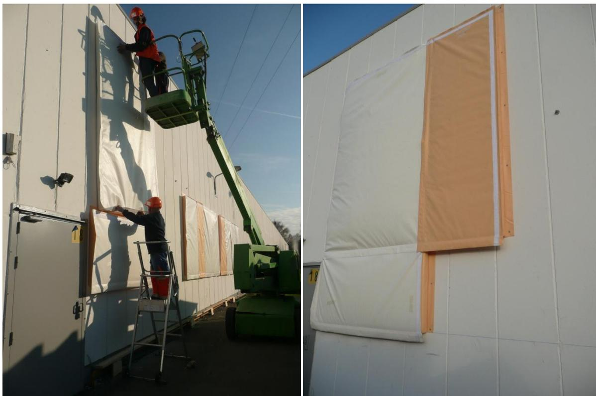
*Figure 104 : Photos de la pose du second et du troisième panneau : à gauche la pose du deuxième panneau, à droite les trois premiers panneaux posés*
