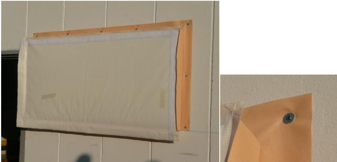
*Figure 103 : photos du panneau 1 posé : à gauche le panneau posé, à droite un zoom sur la fixation d'angle.*
