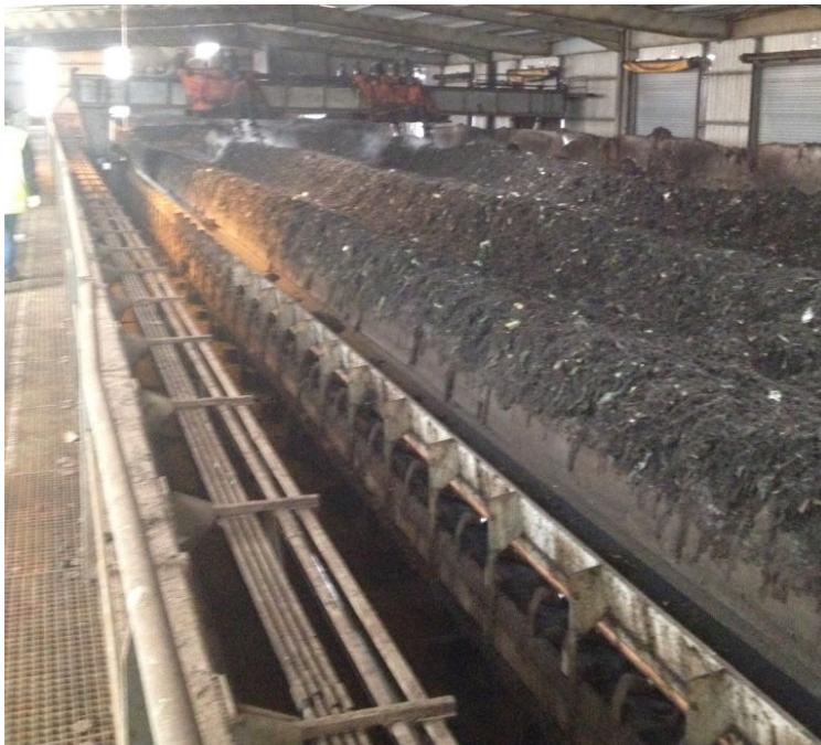
Figure 38 : Aire d'aération forcée, installation de compostage d'Aspach-le-Haut, Haut-Rhin 325 .
