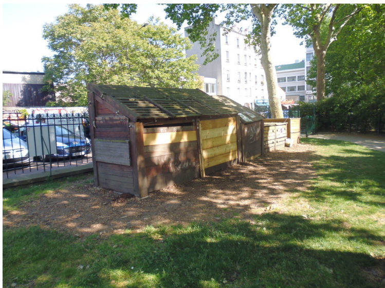
Figure 8 : Composteurs de quartier à Montreuil (93)
