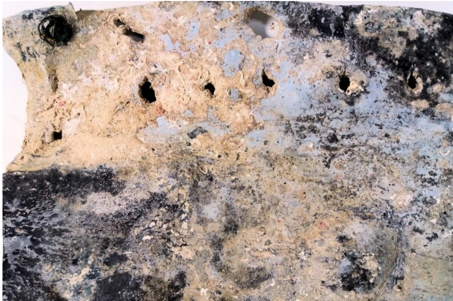
Fig. C2-021. Échantillon du doublage en plomb avec quelques clous d'origine. [ Copyright Admat 2018. ]
