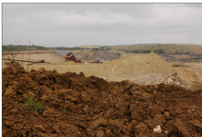
Photographie I-2 : Travaux de terrassement sur le centre d'enfouissement de déchets au Plessis-Gassot, en Plaine de France (F. Roussel, 2015).
