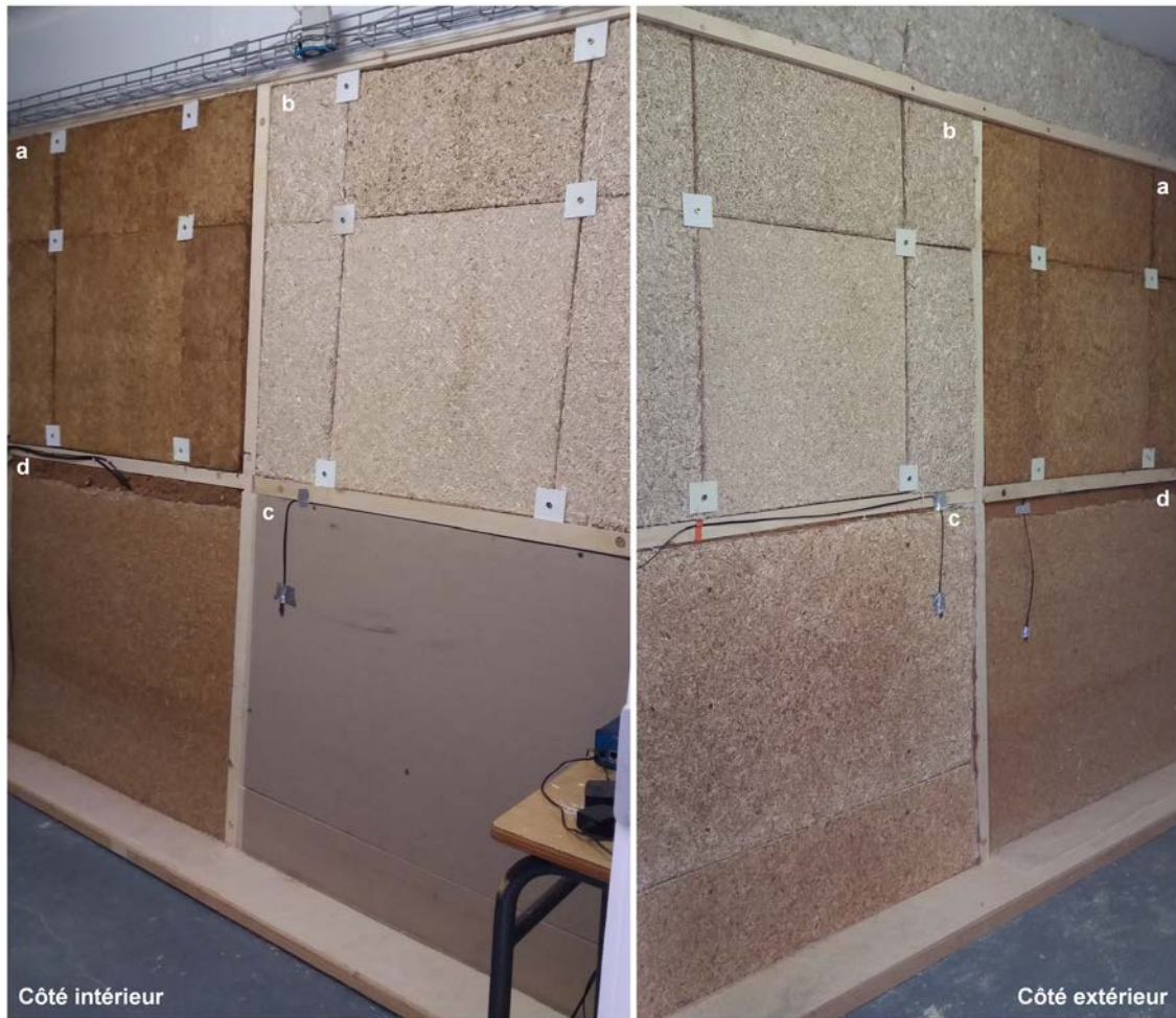
FIGURE 6.13 – Photographies intérieur et extérieur de la paroi montée dans la chambre bi-climatique : (a) panneau de paille de colza traitée, (b) panneau bi-couche, (c) solution retenue par le projet ISOBIO et (d) béton terre-chanvre (MAZHOU 2017 )), avant l'application des enduits et l'ajout de la couche de rafles de maïs pour la cellule (b).
