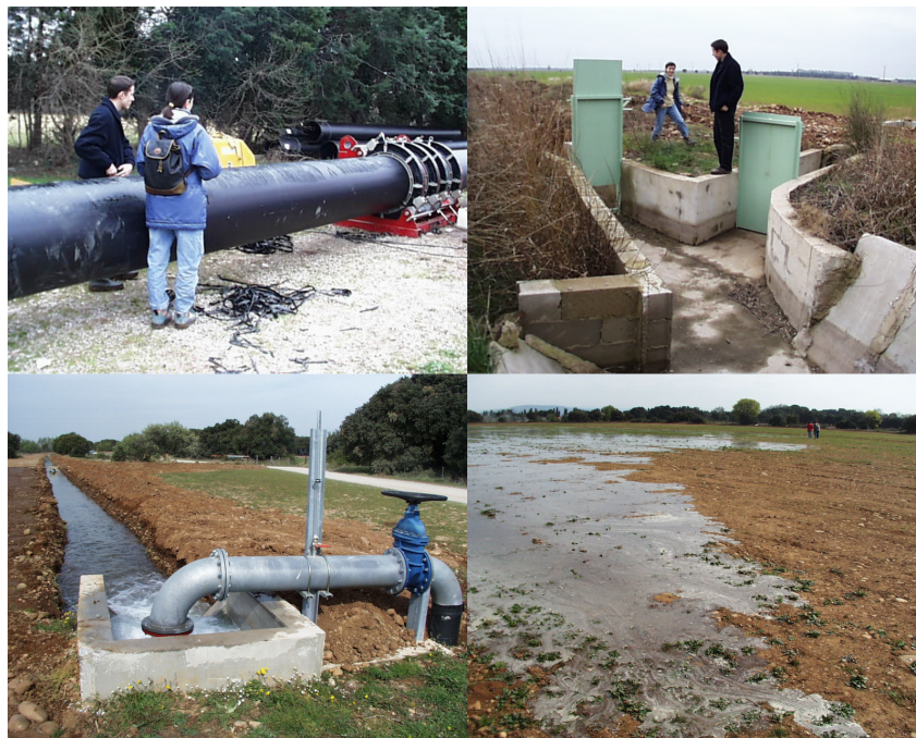
FIGURE 5.13 – . De droite à gauche et de haut en bas : « Tubes de 700 mm », « Partiteur », « Vanne 120 l/s » et « Avancement d'une irrigation au calan 70 [qui a été nivelé pour rectifier la pente] » Sources : http://www.canari.free.fr/photos/ph_merl.htm consulté le 05/09/16. Auteur : Gilles Belaud (professeur hydraulique SupAgro)
