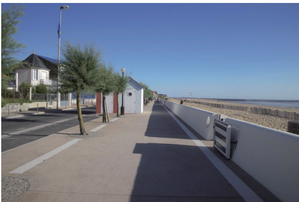
Figure 1.10 : Vue vers le sud du front de mer depuis la digue du front de mer de Châtelaiillon-Plage. On remarque la présence de batardeaux (petites portes fermées en cas de submersions marines et permettant ensuite l'évacuation de l'eau en cas de submersion) qui jalonnent l'ouvrage. Les habitations à gauche sont situées en zones fortement exposées aux submersions marines selon le scénario de référence du PPRL (ARTELIA pour la DDTM 17, 2017). Source : M. Coquet, 2015.
