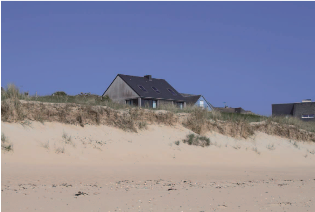
Figure 1.2 : Photographie prise depuis le front de mer de Barneville-Plage. Comme une majorité des habitations du quartier de Barneville-Plage, celle-ci a directement été construite sur le cordon dunaire. Source : M. Coquet, 2015.
