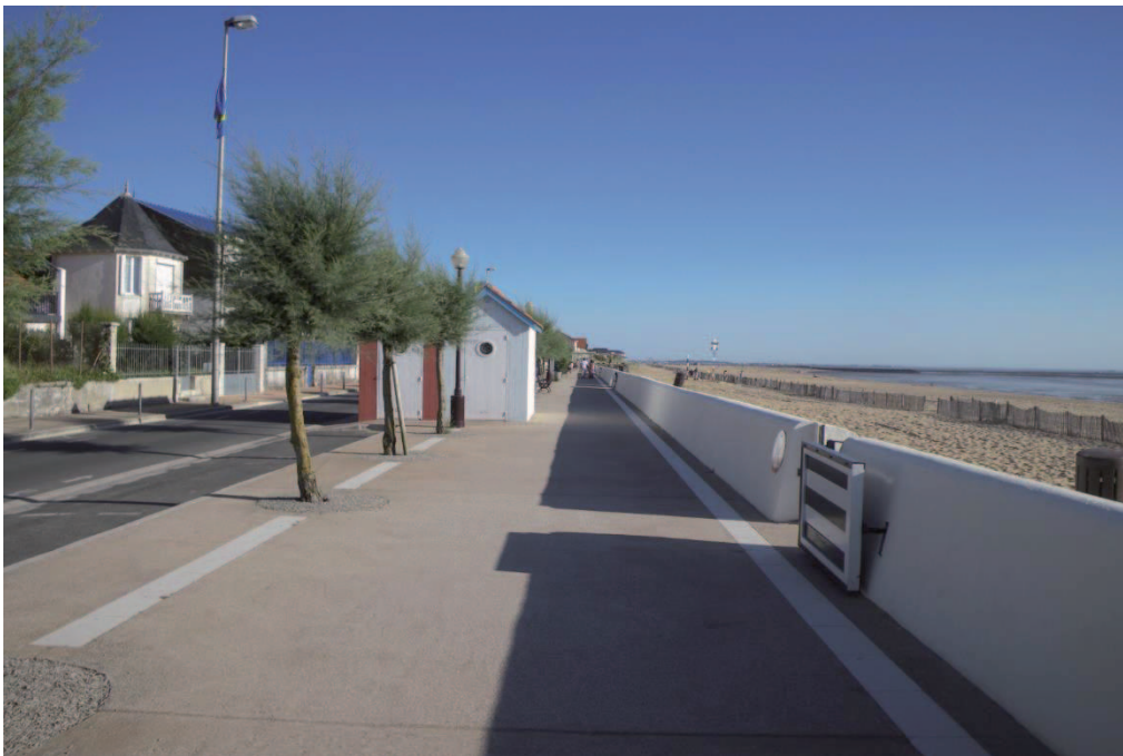
Figure 1.10 : Vue vers le sud du front de mer depuis la digue du front de mer de Châtelaiillon-Plage. On remarque la présence de batardeaux (petites portes fermées en cas de submersions marines et permettant ensuite l'évacuation de l'eau en cas de submersion) qui jalonnent l'ouvrage. Les habitations à gauche sont situées en zones fortement exposées aux submersions marines selon le scénario de référence du PPRL (ARTELIA pour la DDTM 17, 2017). Source : M. Coquet, 2015.
