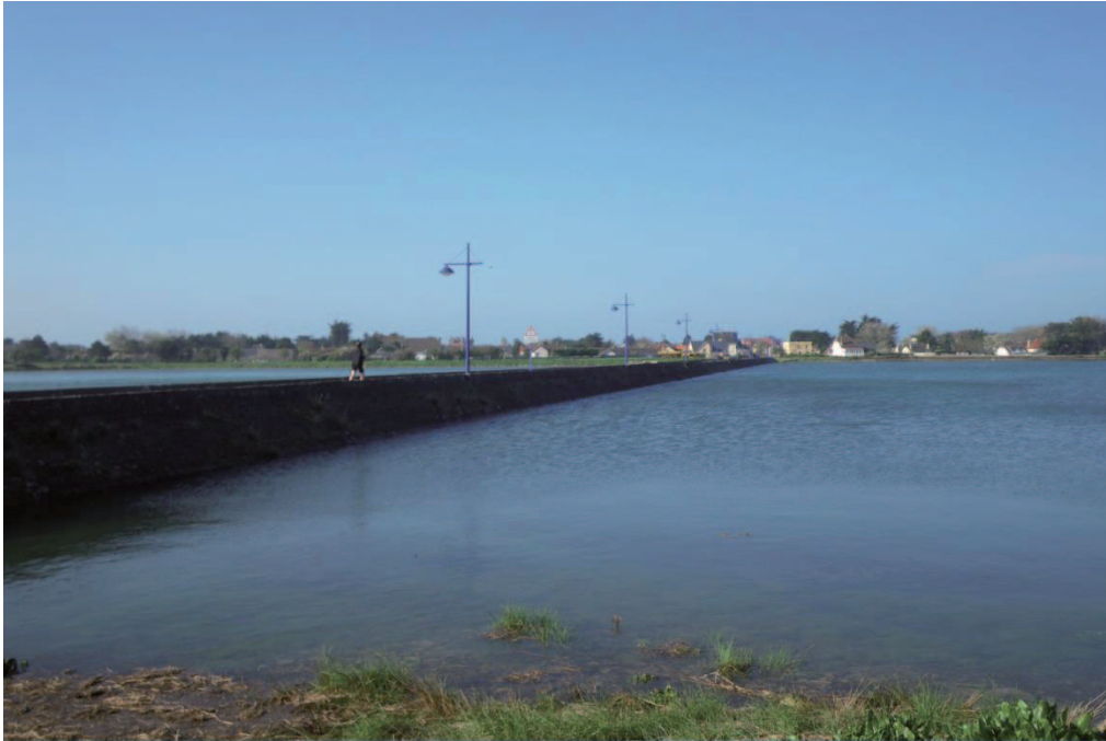
Figure 1.3 : Vue vers le nord du pont reliant le quartier de Barneville-Plage au reste de la commune le 20 avril 2015 par pleine mer de coefficient 110. Les habitations en arrière-plan sont localisées en zone submersible selon les cartes d'aléa actuel présentes dans le PPRL. Source : M.Coquet, 2015
