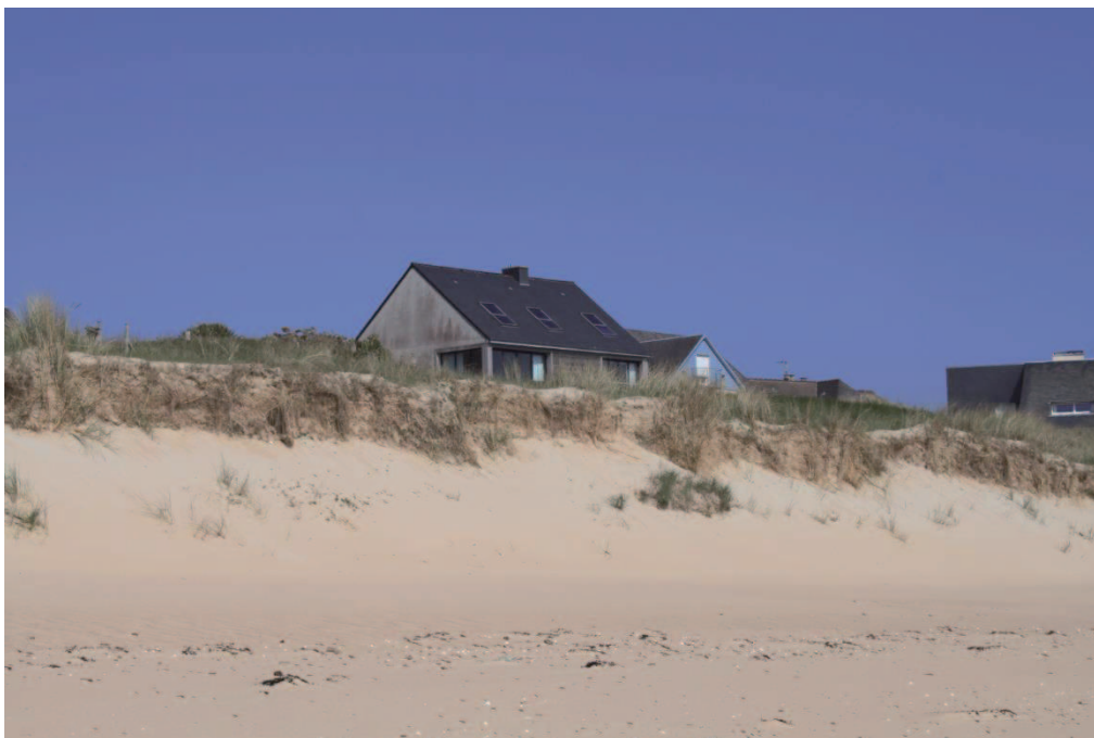
Figure 1.2 : Photographie prise depuis le front de mer de Barneville-Plage. Comme une majorité des habitations du quartier de Barneville-Plage, celle-ci a directement été construite sur le cordon dunaire. Source : M. Coquet, 2015.
