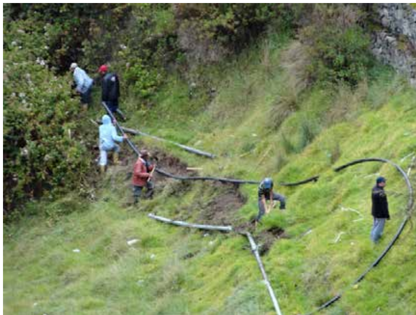
Photo 65 - Maintenance des infrastructures d'irrigation (Misintá, Août 2013).
