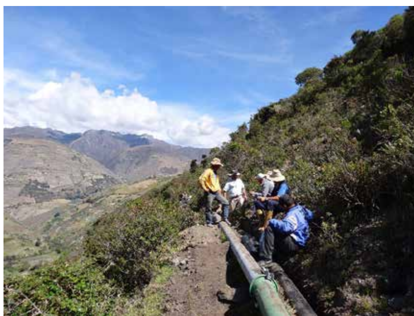
Photo 96 - Remplacement des tuyaux en acier à Mocoa (vallée du Haut Chama, décembre 2013).
