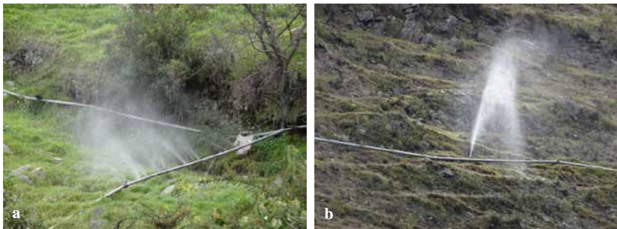
Photo 82 - Fuites d'eau liées à la vétusté des tuyaux. a : Mixteque (septembre 2016); b : Misintá (juillet 2013).
