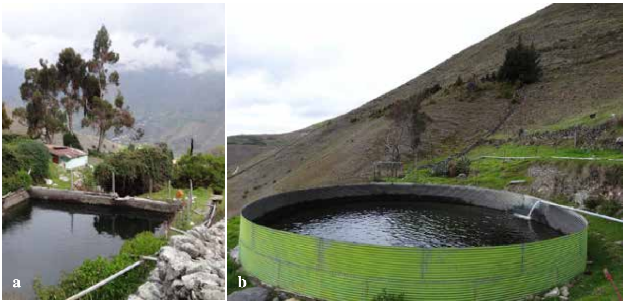
Photo 66 - Réservoirs d'irrigation de Misintá. a : réservoir en béton « el Chical » ; b : réservoir « Nato » (2013).
