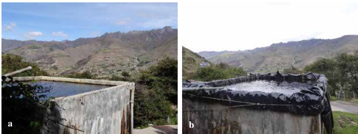
Photo 84 - Dans un contexte de crise, les agriculteurs réparent les infrastructures comme ils le peuvent. a : le réservoir de Mixteque en 2013 ; b : mise en place d'une bâche en 2016.
