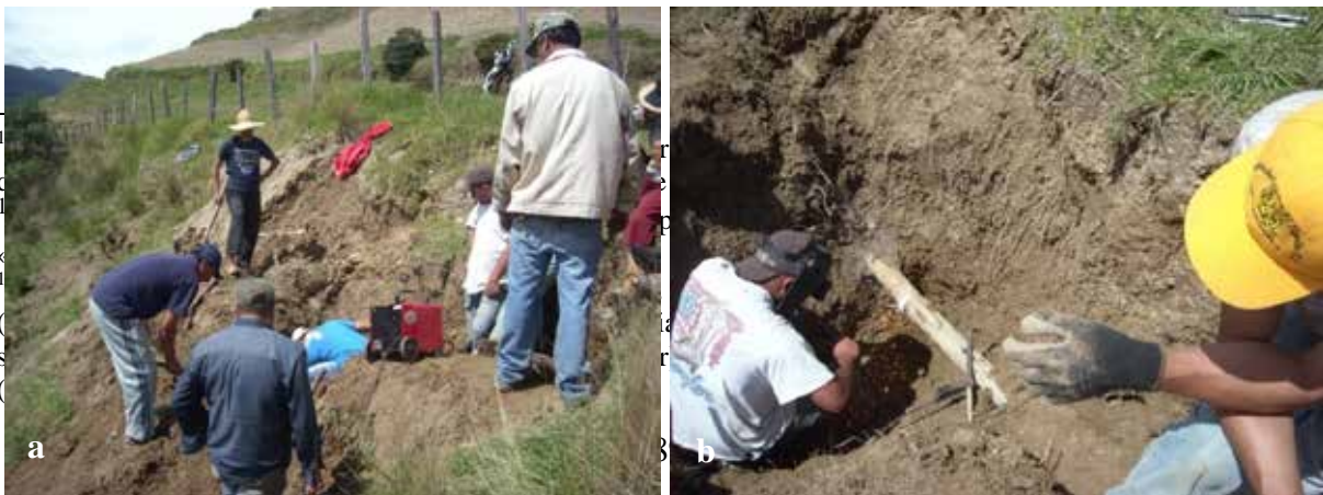
Photo 94 - Entretien des infrastructures d'irrigation. Les agriculteurs d'un même secteur se réunissent pour souder un tuyau (Misintá, 2011).
