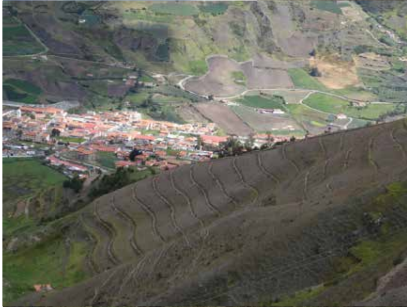
Photo 34 - Seuils mis en place dans le cadre du Programa Subsidio Conservacionista (Misintá, octobre 2013).
