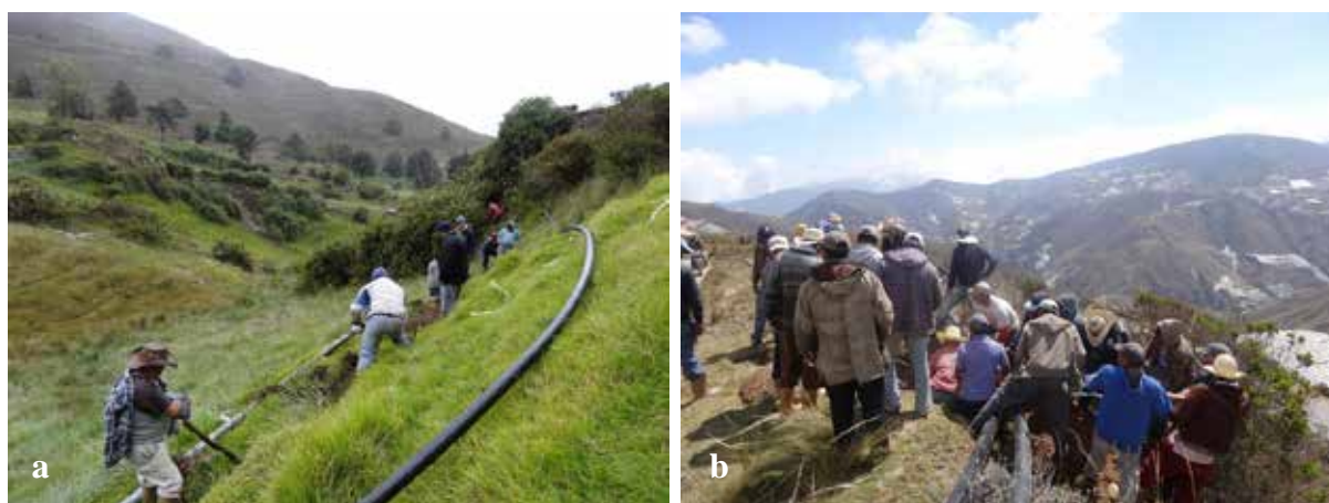
Photo 95 - Remplacement des tuyaux en acier par des tuyaux en polyéthylène à Misintá (a) et Cabimbú (b), (juillet 2013 et mars 2015).
