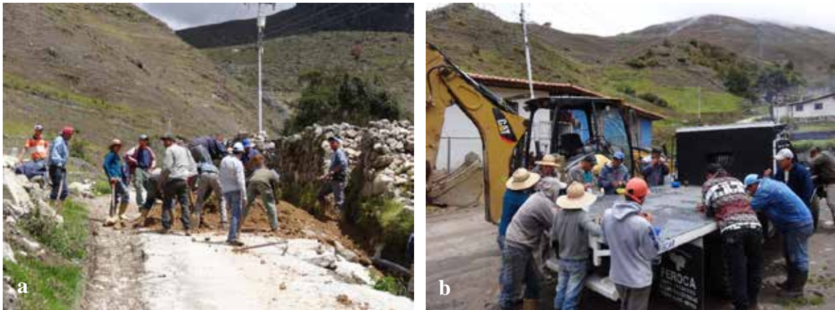
Photo 93 - Lors de l'amélioration de la route, c'est toute la communauté qui participe (Misintá, Août 2013).
