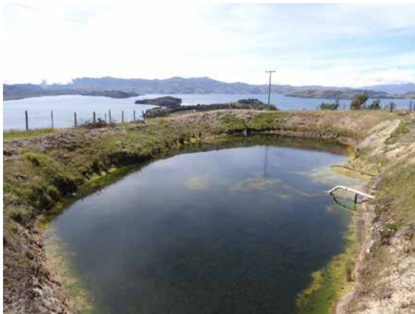
Photo 101 - Bassin de rétention d'Asomoan (Décembre 2014).
