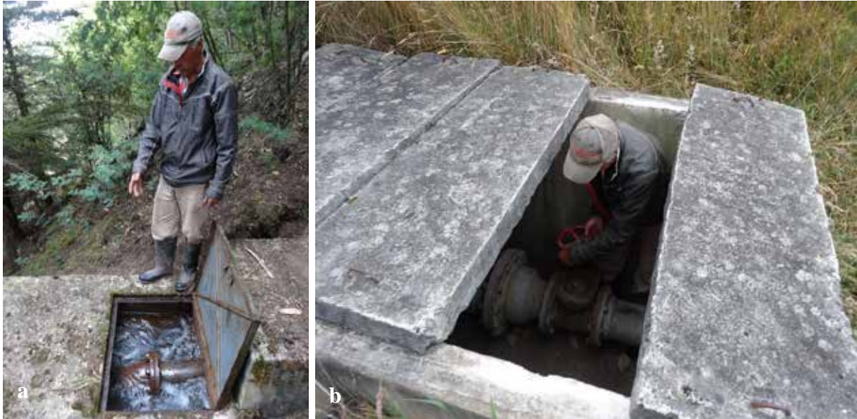
Photo 85 - L'aiguadier d'Hato Laguna en train d'ouvrir les vannes (Janvier 2014).
