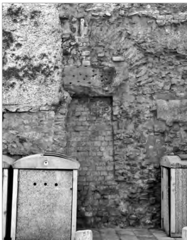
Fig.28 Niche du parement oriental de la paroi occidentale du forum d'Orange (mur de la rue Pontillac), état actuel. Mignon et Paillet 2012, p. 173, fig. 20.
