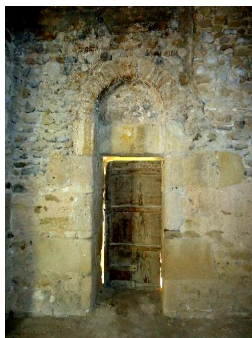
Figure 589 Porte sud, intérieur (côté château)
