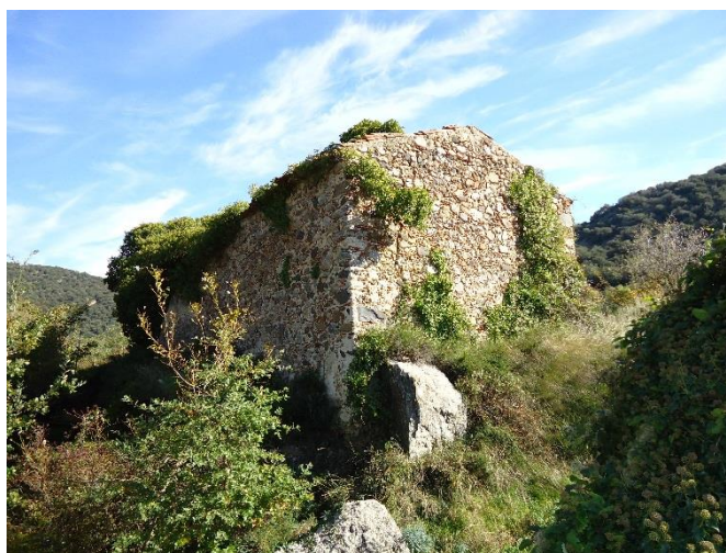
Figure 39 Vue extérieure des vestiges
