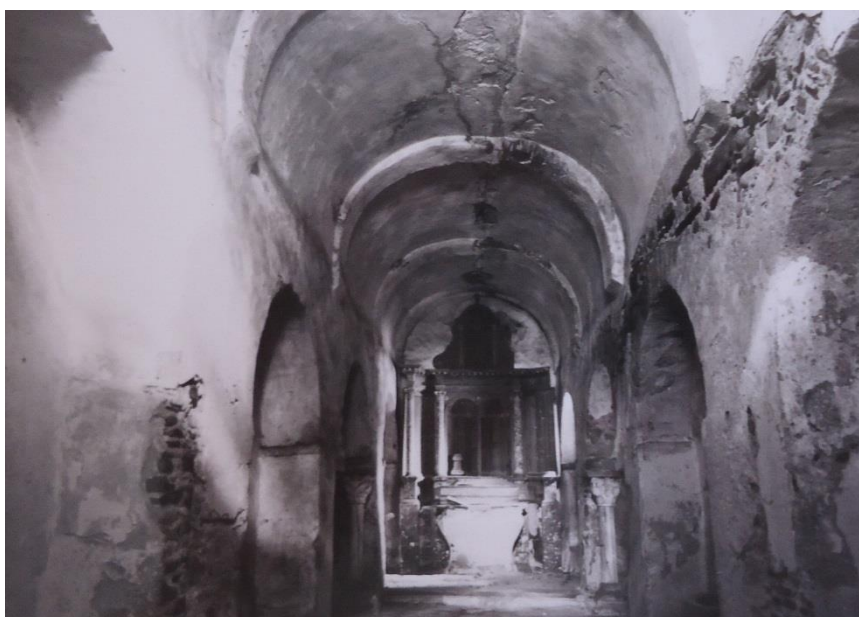
Figure 666- 667 Deux photos d' André Signol de 1983, avant la restauration, DRAC Montpellier
