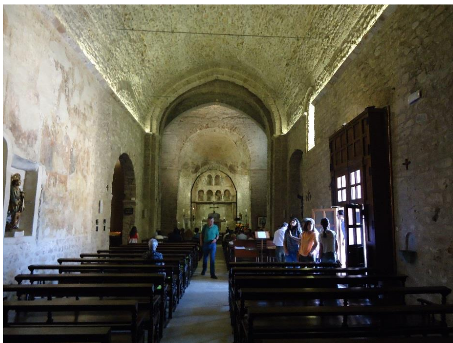
Figure 784 Arc brisé outrepassé de la nef de Sant Père
