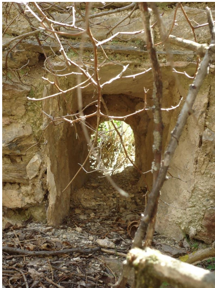
Figure 623 Baie dans le mur sud du chevet
