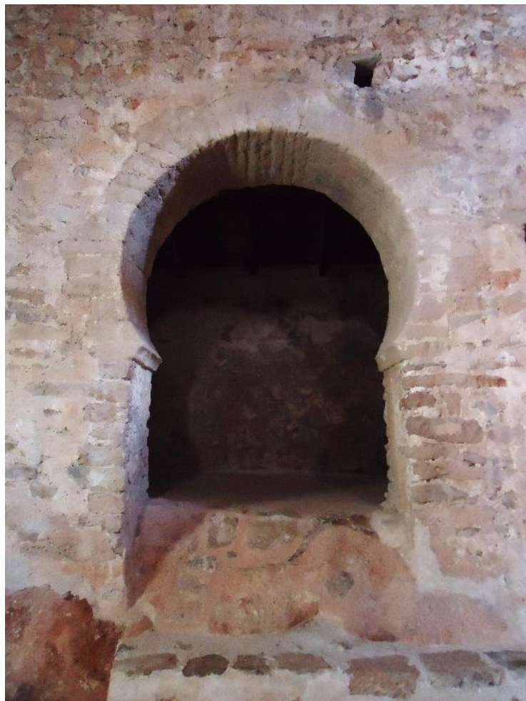
Figure 202 Arcade nord, première travée occidentale
