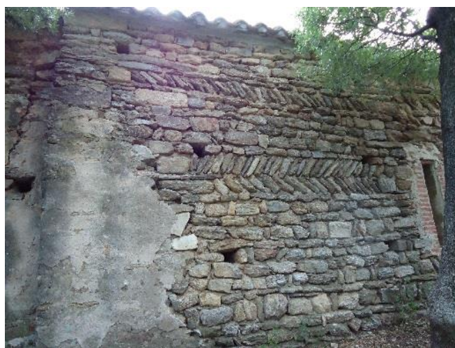
Figure 44 Détail du mur nord
