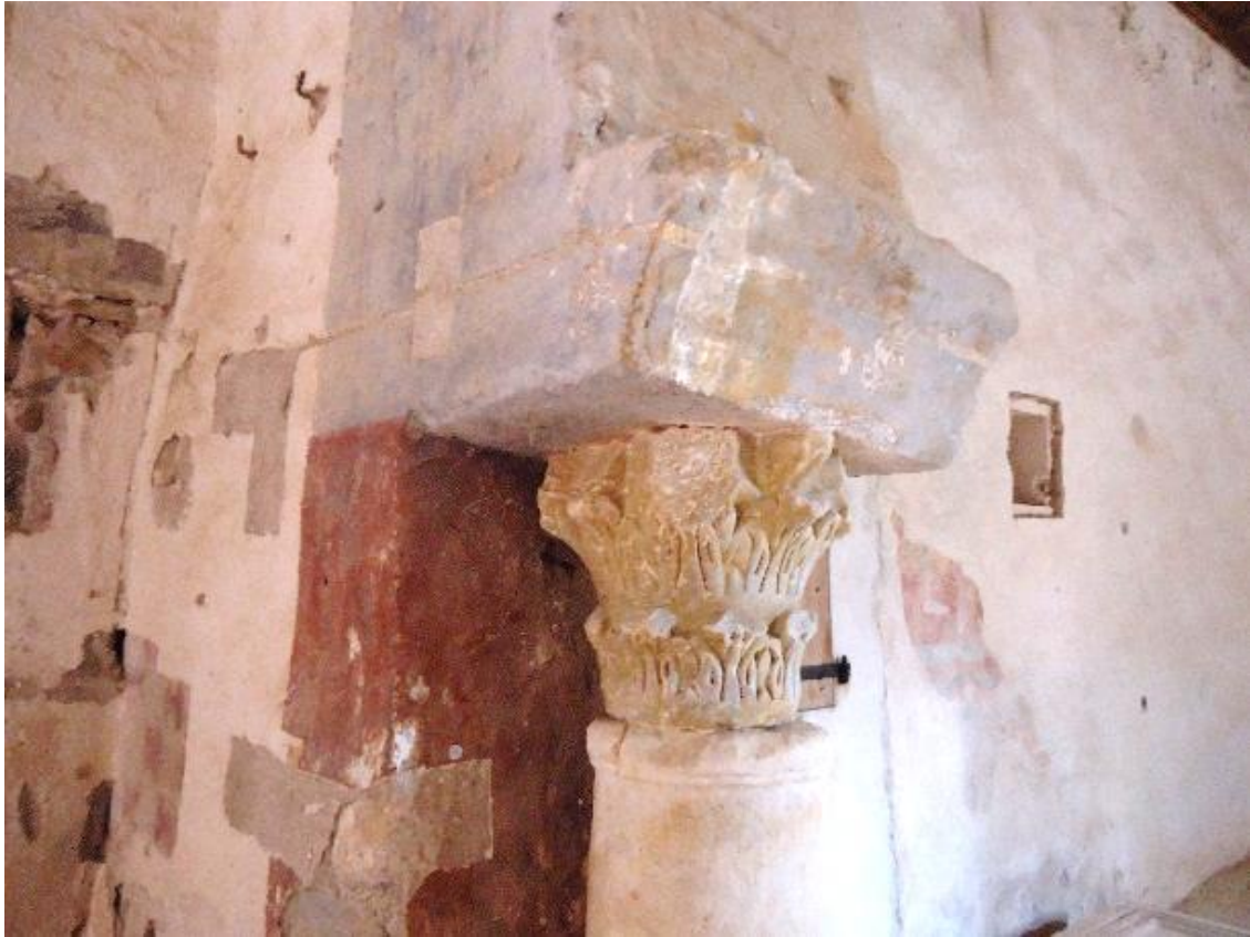
Figure 695 Imposte et chapiteau nord de l'arc triomphal
