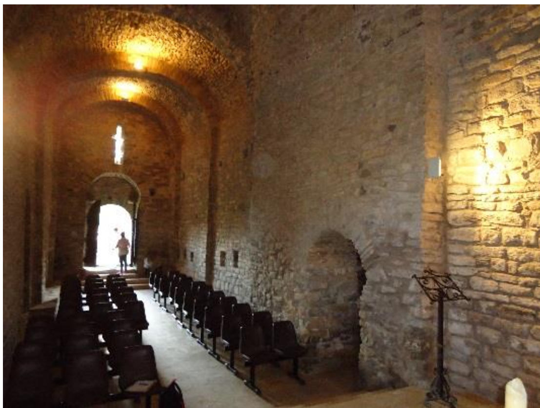
Figure 272 Vue de la nef avec la saillie de la tour dans le mur nord
