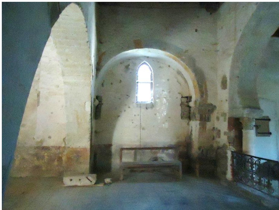
Figure 697 L'arc nord muré
