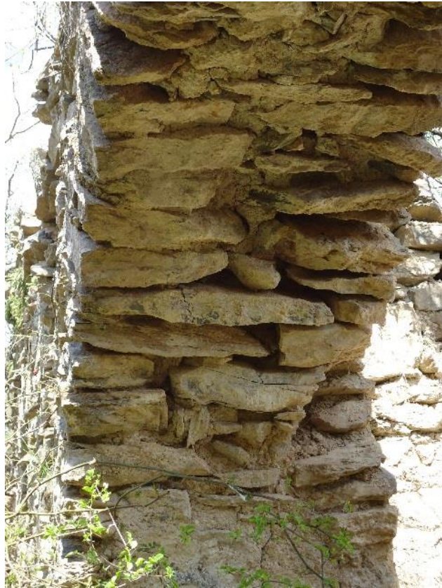
Figure 622 Détail de l'intrados de l'arc triomphal
