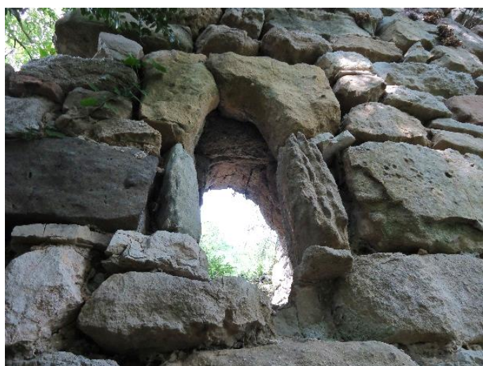
Figure 452 Fenêtre méridionale du chevet, extérieur
