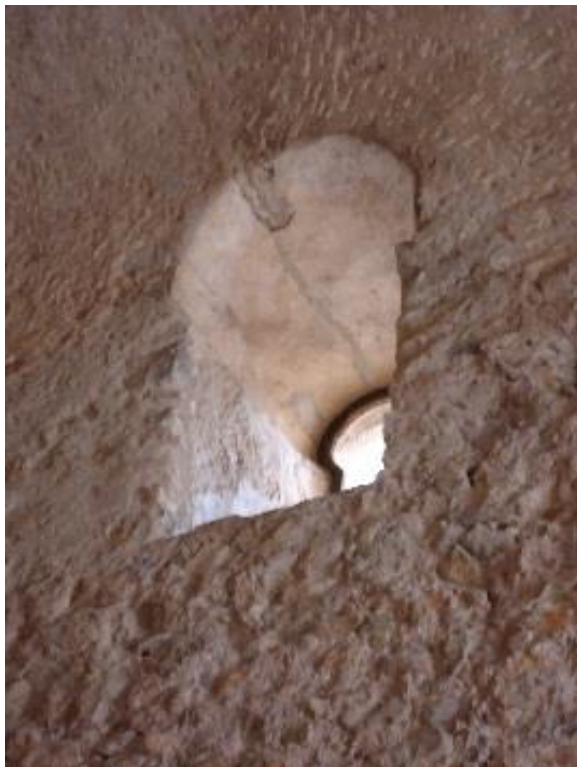
Figure 110 Fenêtre sud, nef centrale
