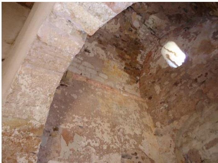
Figure 217 Voûte du chevet
