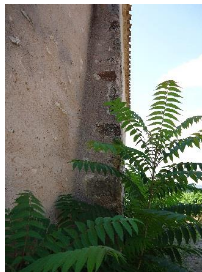
Figure 211 Angle nord-est de la nef illustrant l'amincissement de la paroi de la nef
