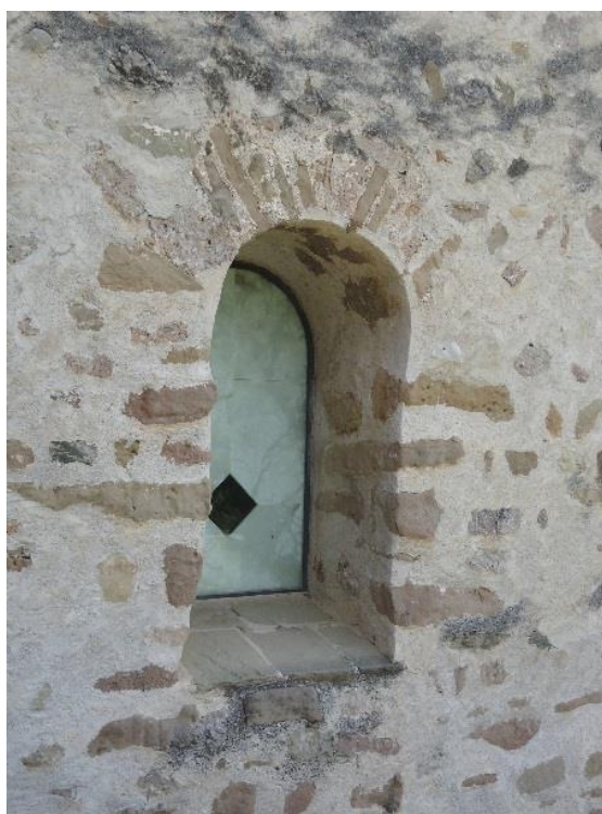
Figure 205 La même ouverture dans la façade occidentale après la restaration
