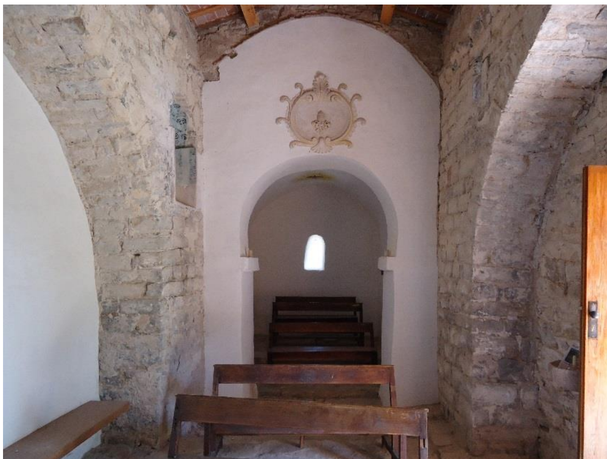
Figure 26 Vue de l'arc triomphal après la restauration
