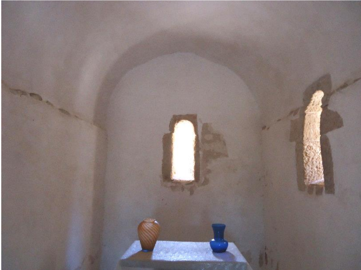
Figure 556 Voûte du chevet
