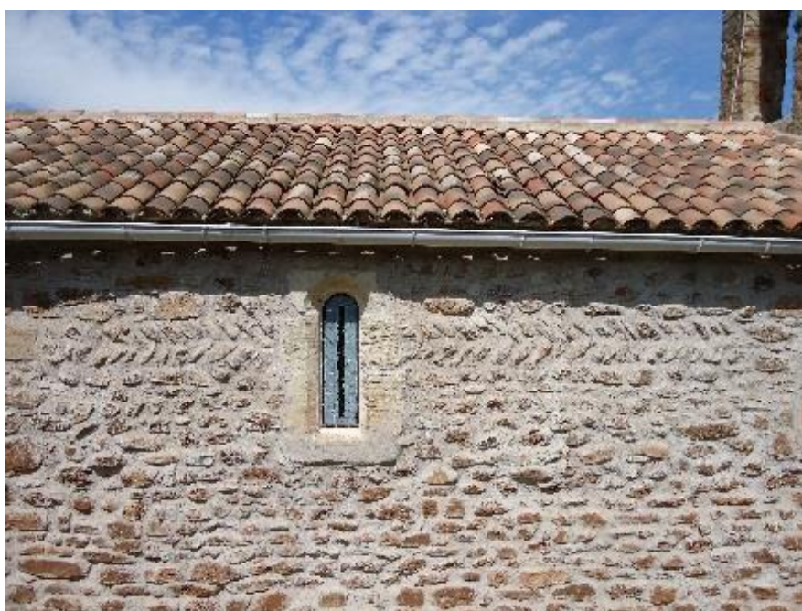
Figure 439 Détail du mur méridional
