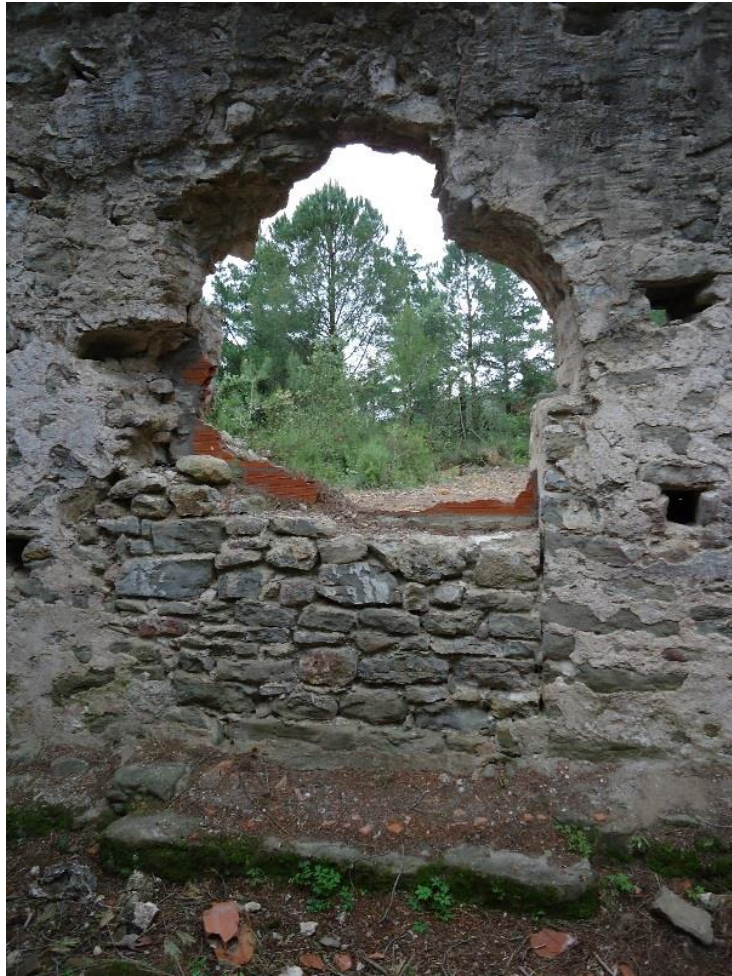
Figure 370 Vue intérieure de la porte méridionale
