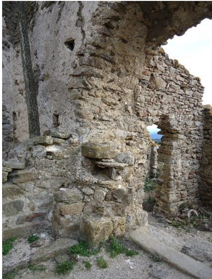
Figure 95 Pilier détruit de l'arc triomphal, côté sud
