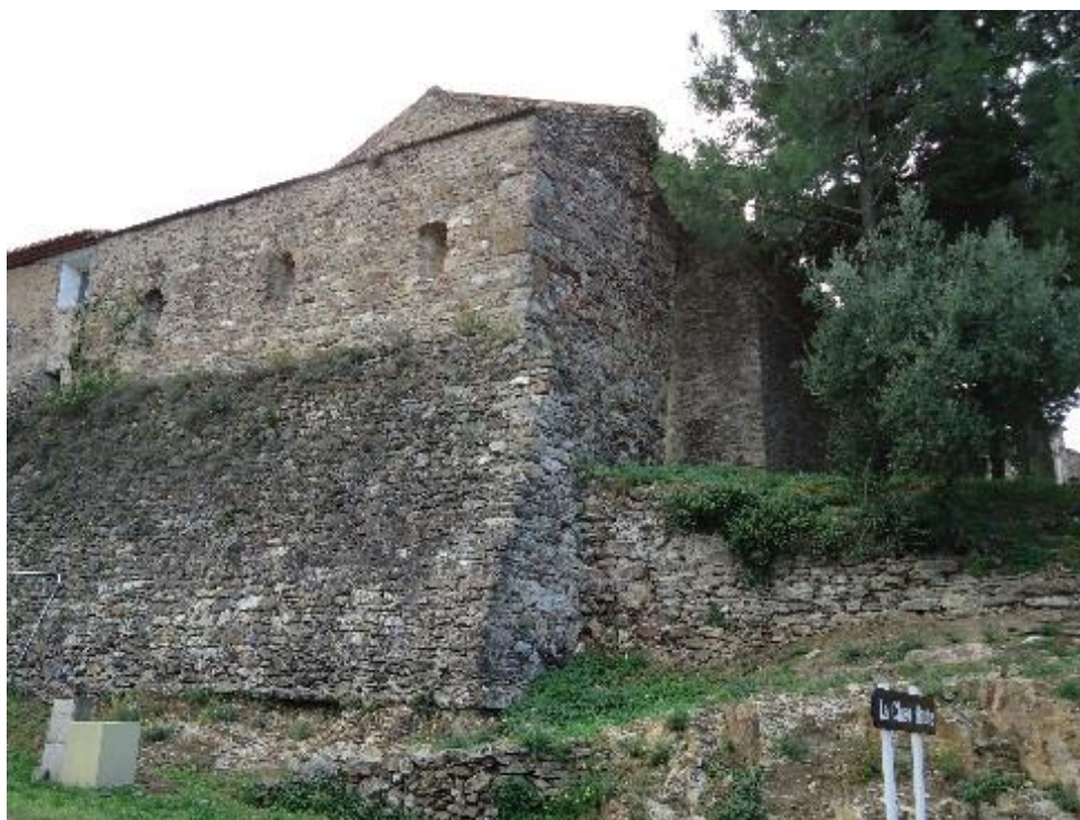
Figure 407 Vue extérieure du chevet
