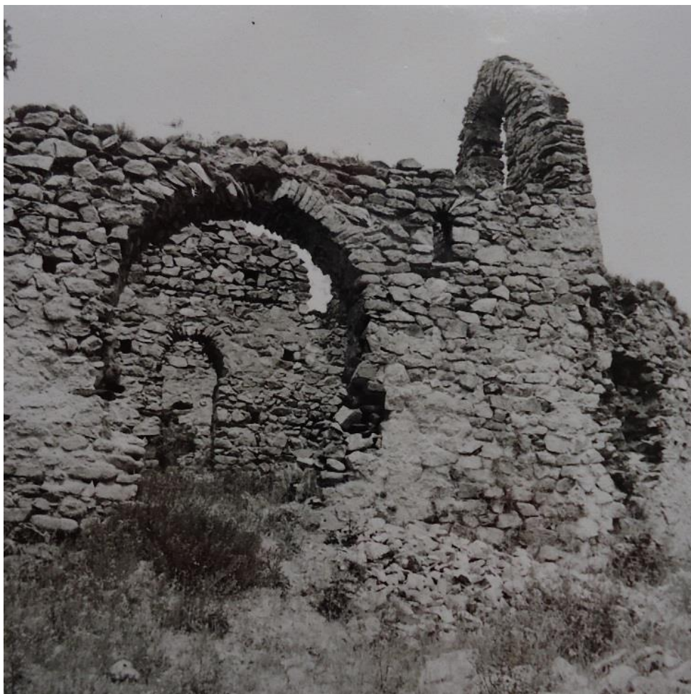
Figure 755 Porte sud du vaisseau sud, en arrière-plan la porte en champignon entre les deux vaisseaux, SDAP Perpignan
