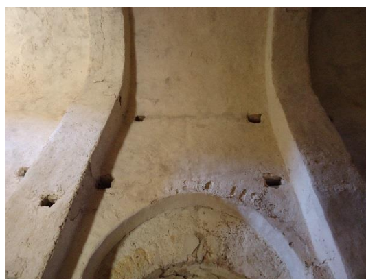
Figure 143 Voûte de la nef sur banquette
