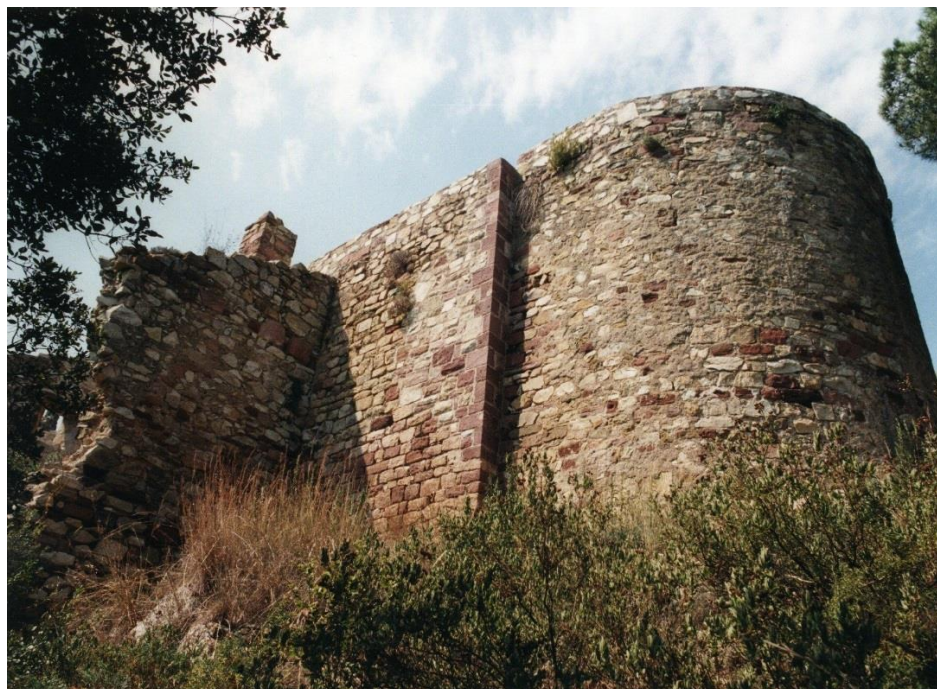
Figure 126 Vue extérieure de l'abside
