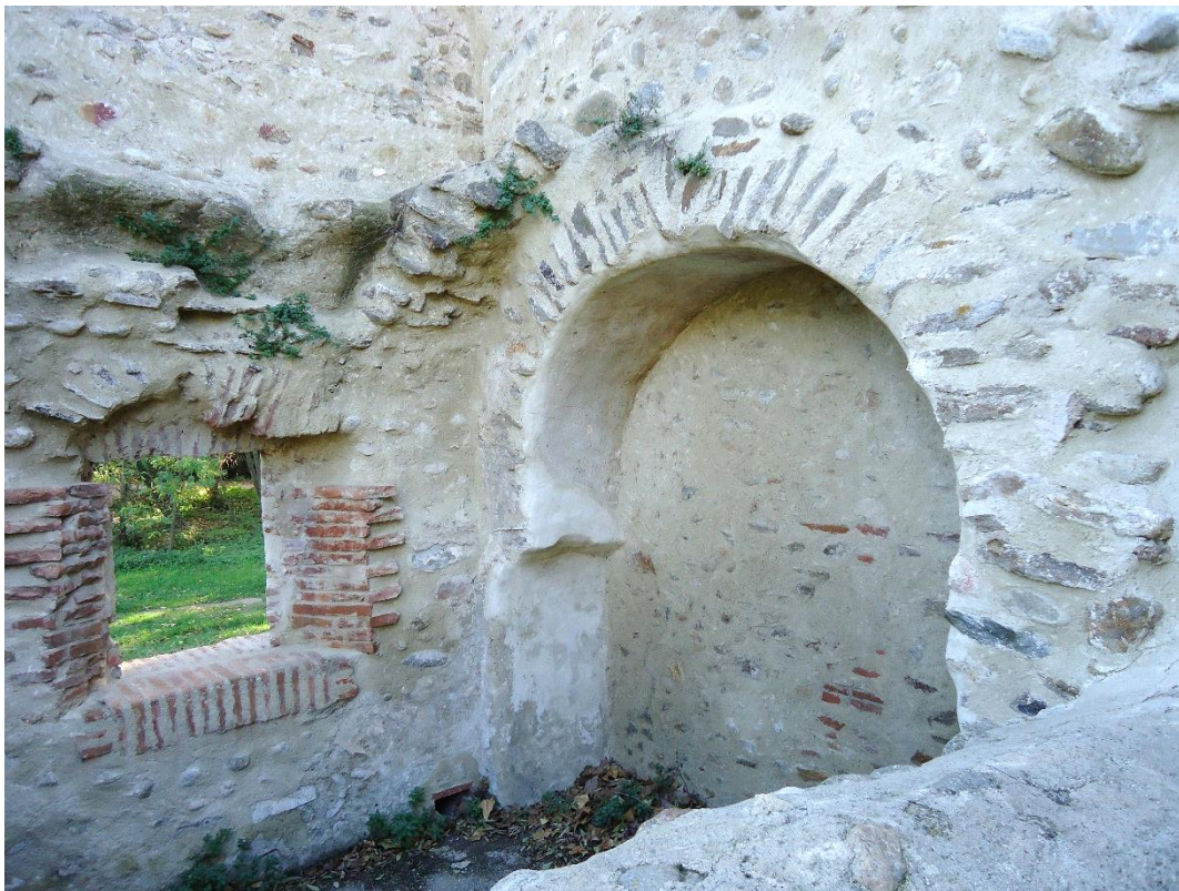
Figure 664 L'emplacement de l'ancien chevet avec son arc triomphal muré
