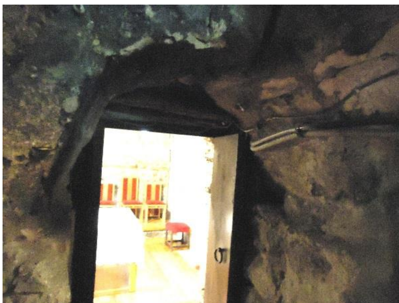
Figure 710 Côté intérieur de la porte donnant accès à la tour
