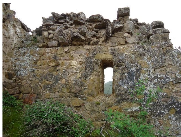
Figure 166 Mur sud avec sa fenêtre, côté intérieur
