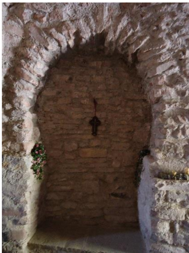
Figure 340 L'arc latéral sud précédant le chevet
