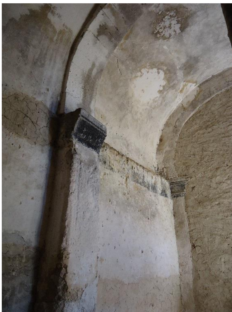
Figure 292 Les piliers nord
