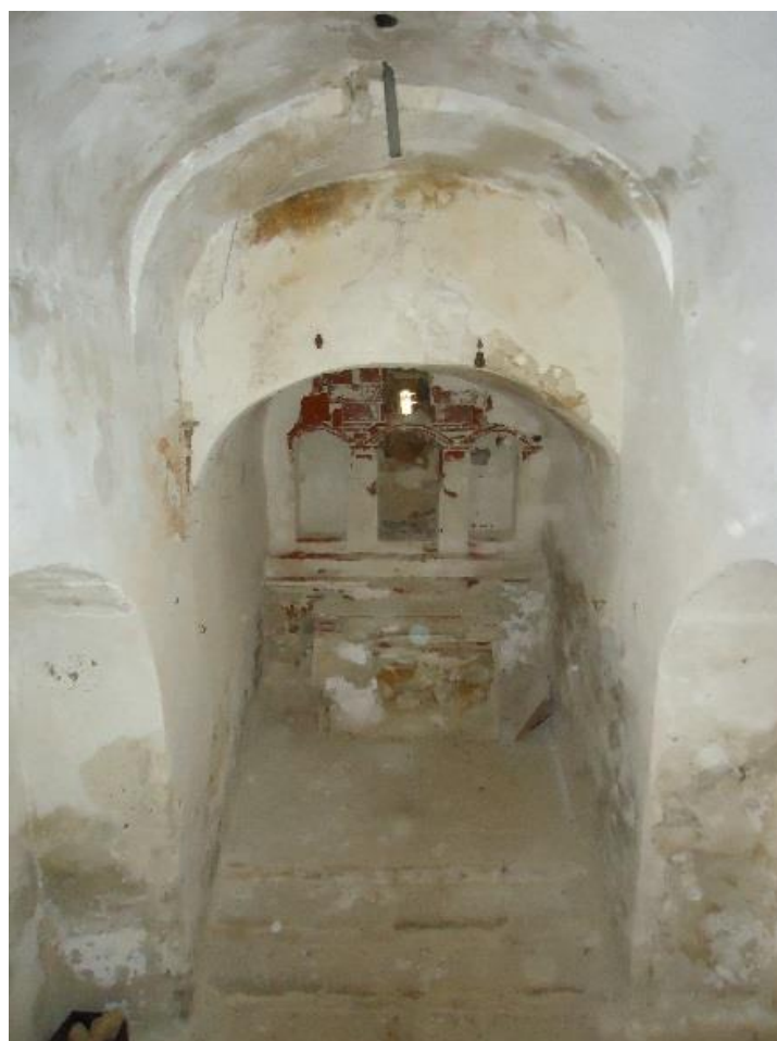
Figure 60 Vue de la tribune occidentale
