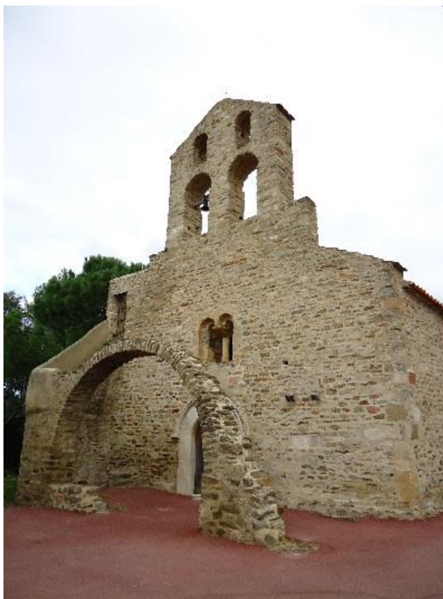
Figure 406 Vue de la façade occidentale
