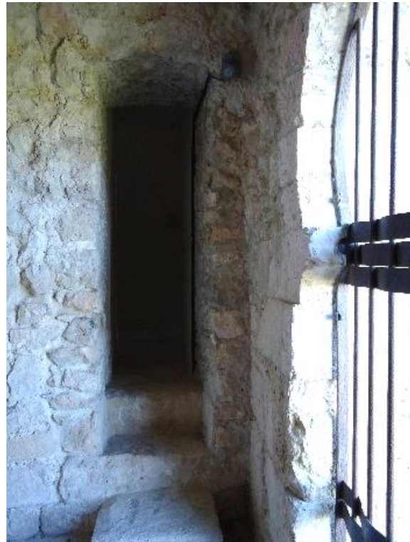
Figure 577 Le passage entre l'église Sant Miquel et le chevet ancien
