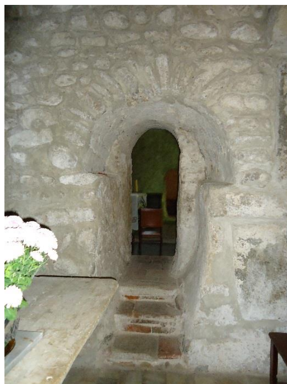
Figure 658 Porte de passage entre l'abidiole nord et l'abside centrale
