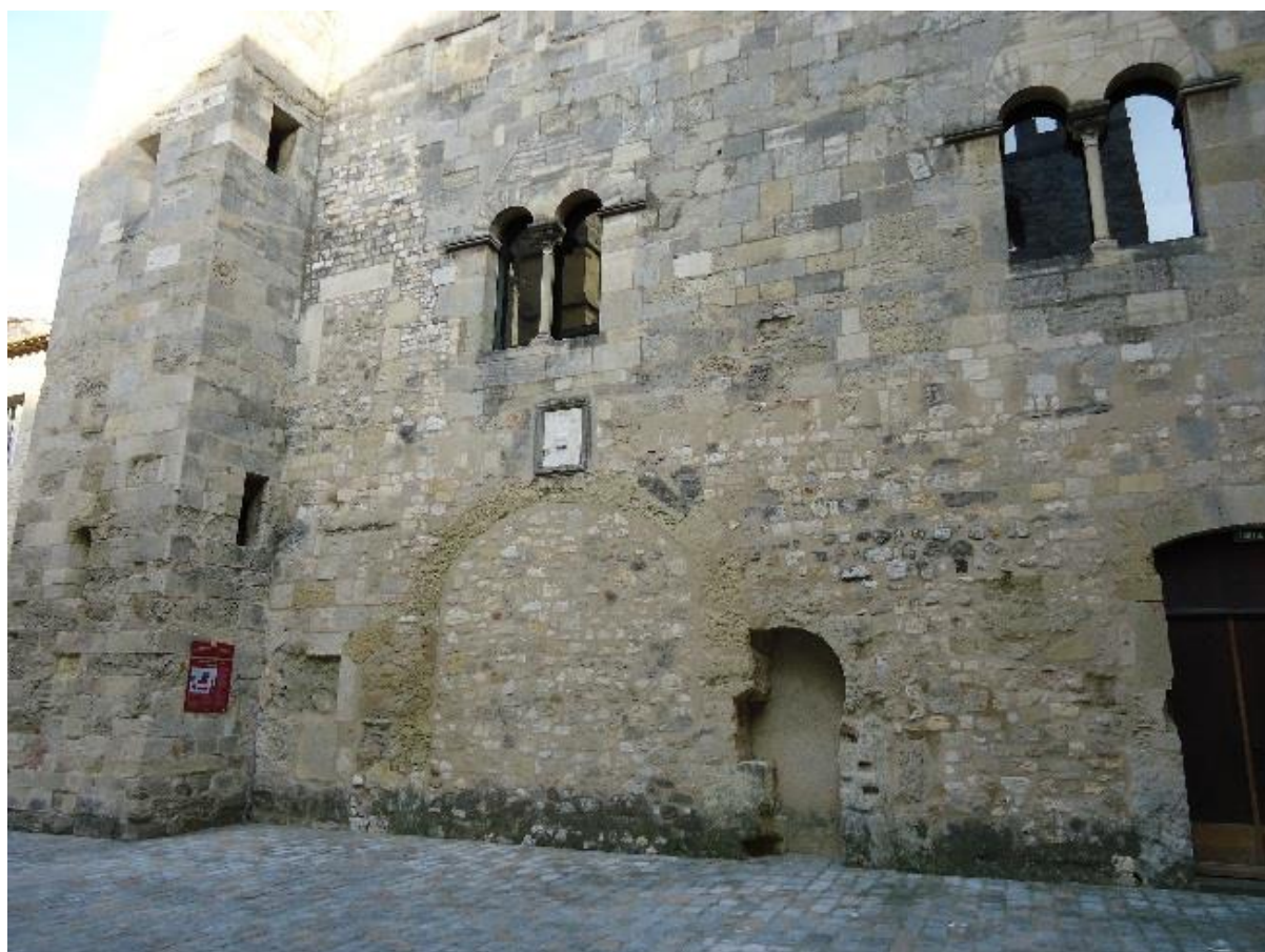
Figure 561 L'ouverture dégagée dans la cour de la Madeleine
