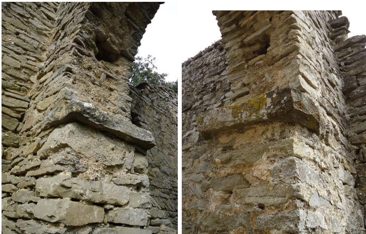
Figure 815- 816 Les impostes (sud et nord) de l'arc triomphal
