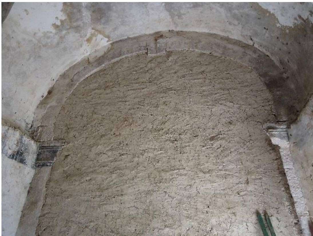
Figure 293 Arc doubleau de la deuxième travée depuis l'ouest
