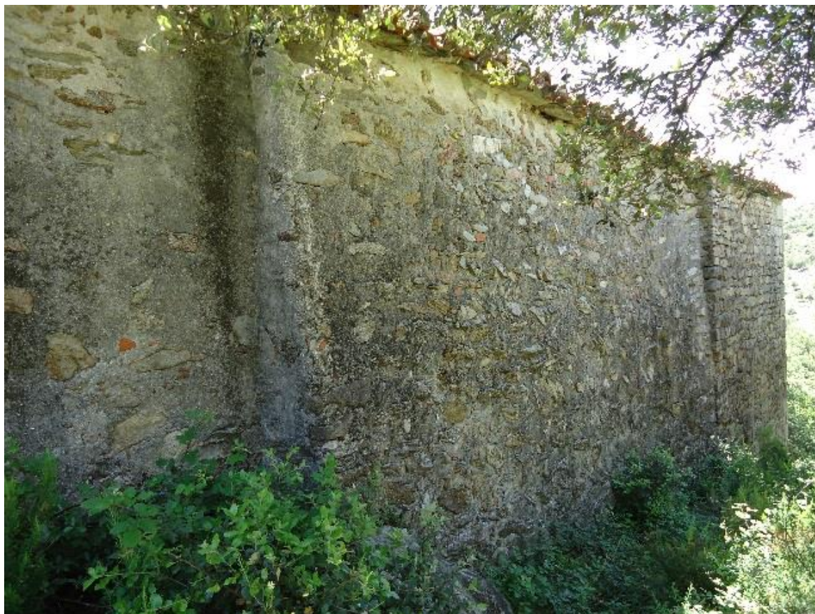
Figure 726 Mur nord, écart entre la construction d'origine et la partie romane ajoutée à l'ouest
