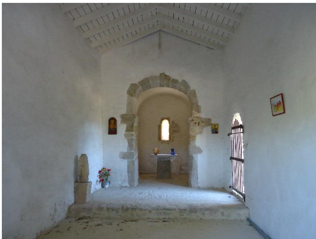
Figure 551 Vue d'ouest en est, état après la restauration
