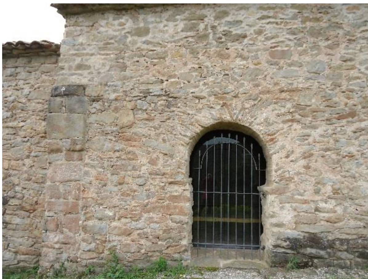
Figure 236 Porte dans le mur nord, extérieur
