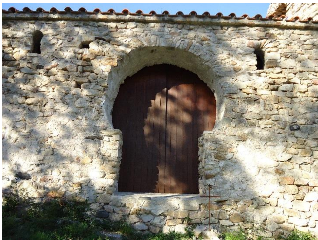
Figure 756 Porte sud du vaisseau sud après la restauration
