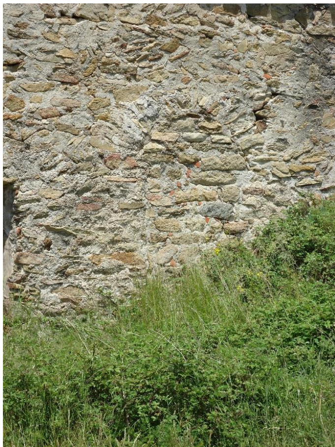
Figure 725 Porte murée dans la façade méridionale
