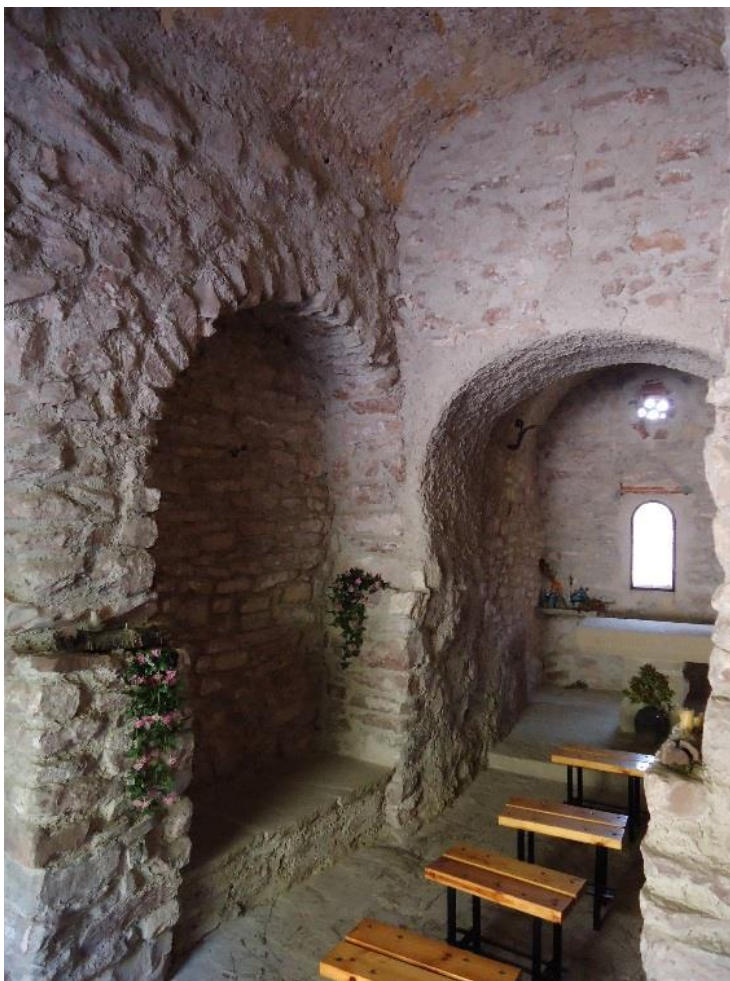
Figure 339 Vue du chevet avec sa voûte, du piédroit nord de l'arc triomphal et la jonction de celui-ci avec l'arc latéral nord
