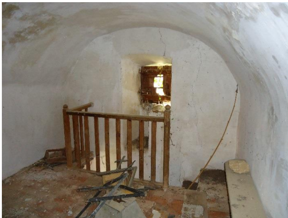
Figure 61 Vue de la voûte vers l'ouest sur la tribune
