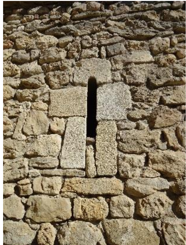
Figure 558 Fenêtre sud du chevet
