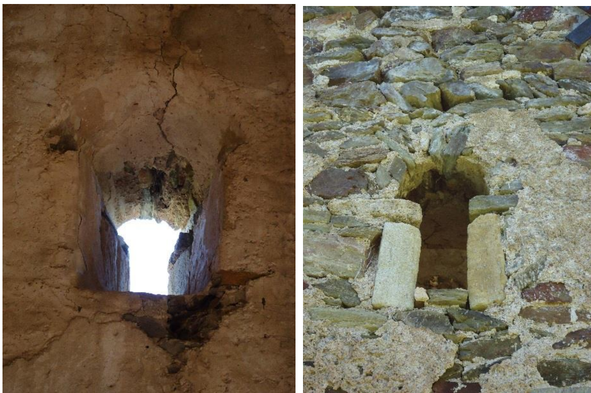
Figure 393 Fenêtre sud du transept
