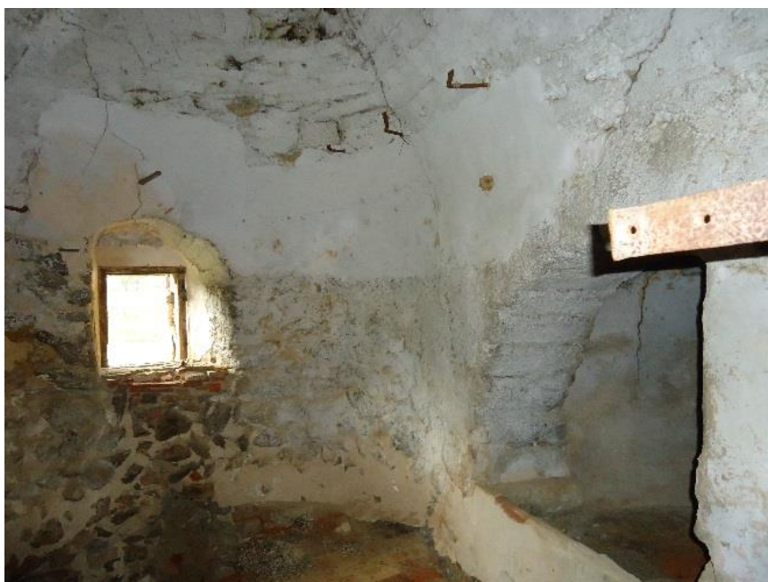
Figure 430 Vue du chevet, absides est et sud, partie haute, incorporées à l'étage du mas
