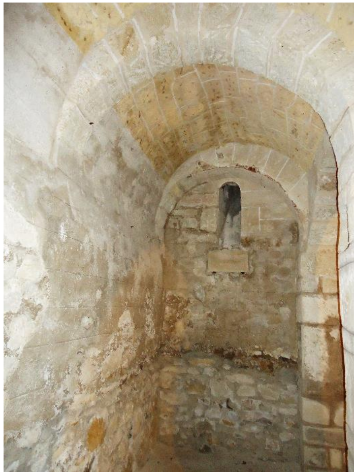
Figure 481 Voûte du bas-côté nord, première travée orientale
