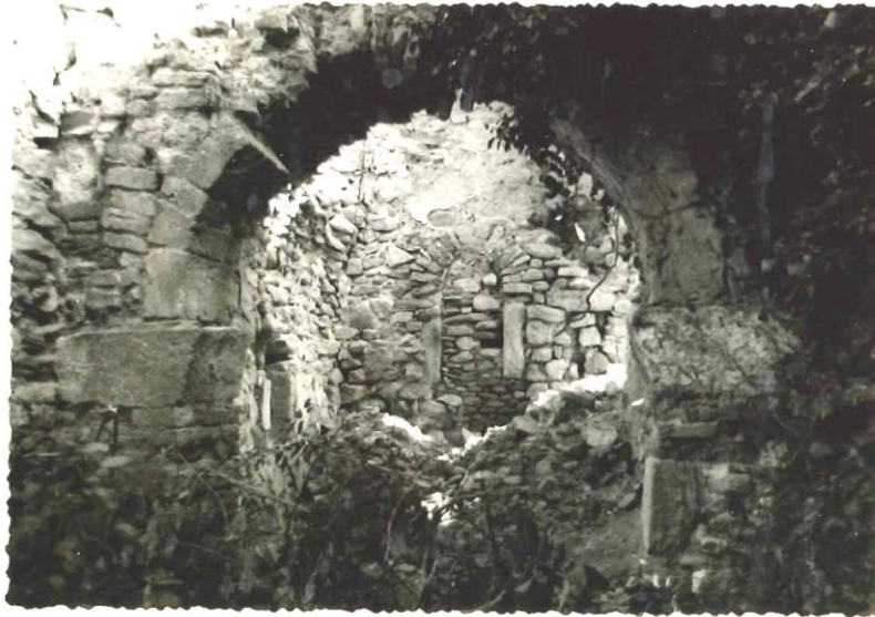
Figure 172 L'arc triomphal avant sa restauration, DRAC Montpellier
