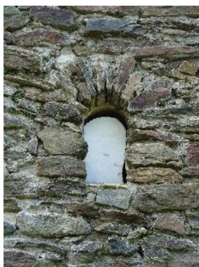
Figure 351 Baie sud, nef
