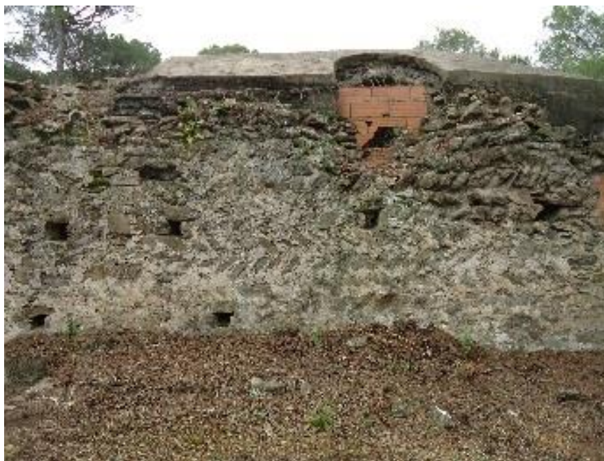
Figure 375 Mur nord de la nef
