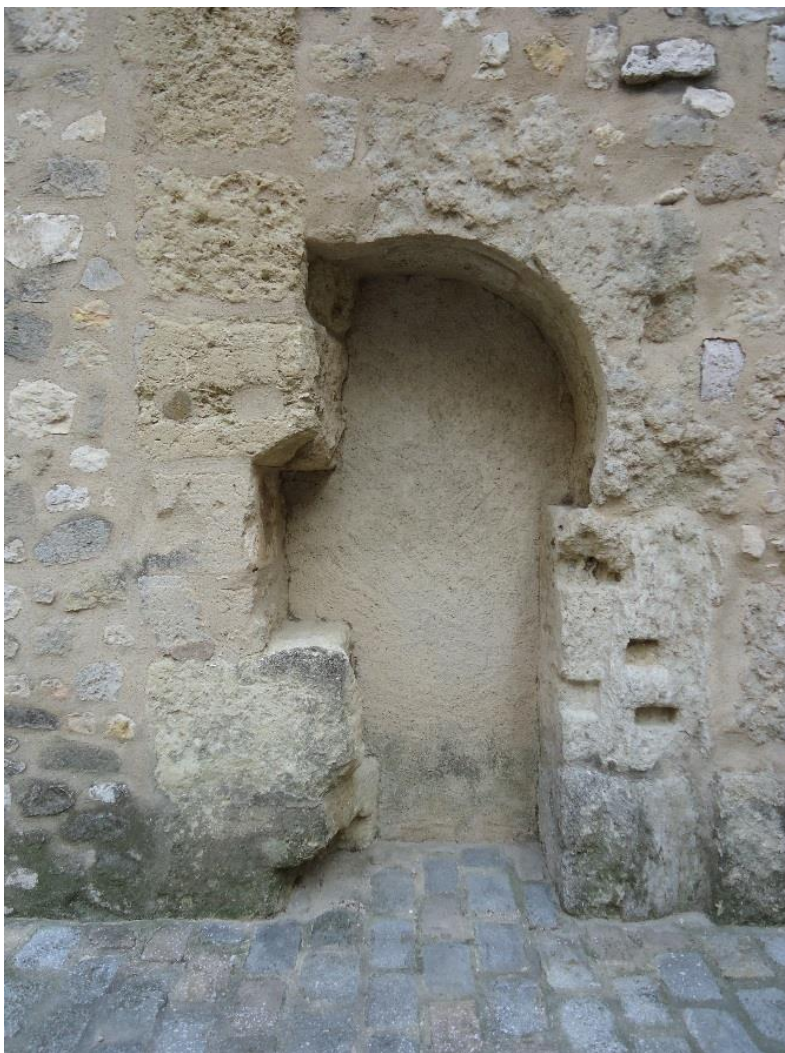
Figure 562 Porte à l'arc outrepassé
