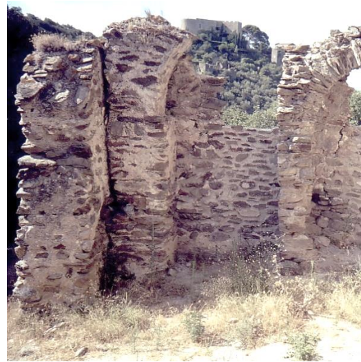
Figure 280 État avant la restauration
