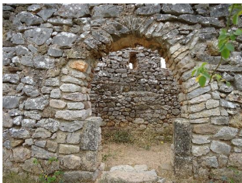
Figure 184 Porte nord, extérieur
