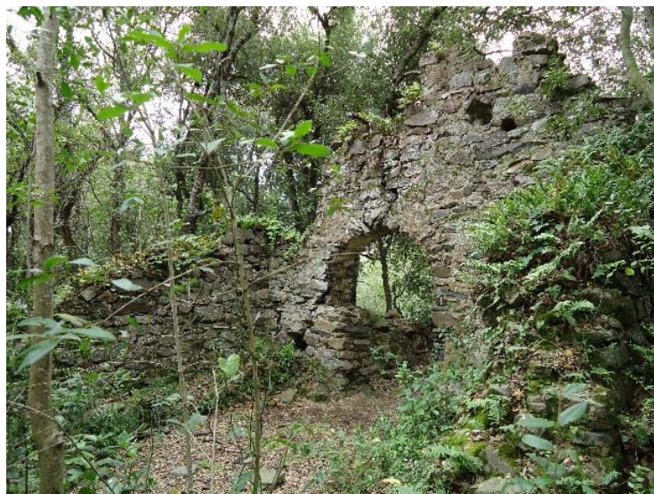
Figure 149 Vue sud des ruines
