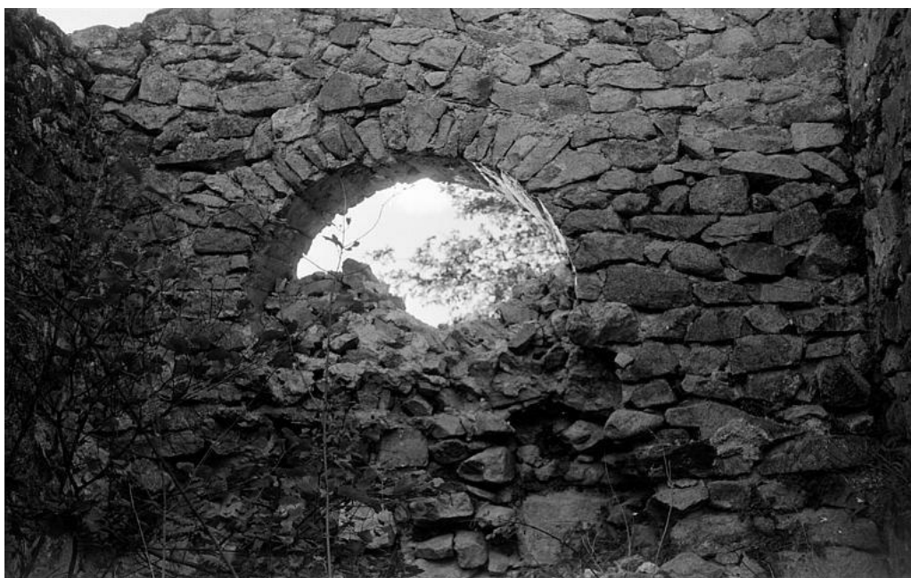
Figure 759 Porte occidentale du vaisseau sud, côté intérieur, Inventaire, R. Hyvert
