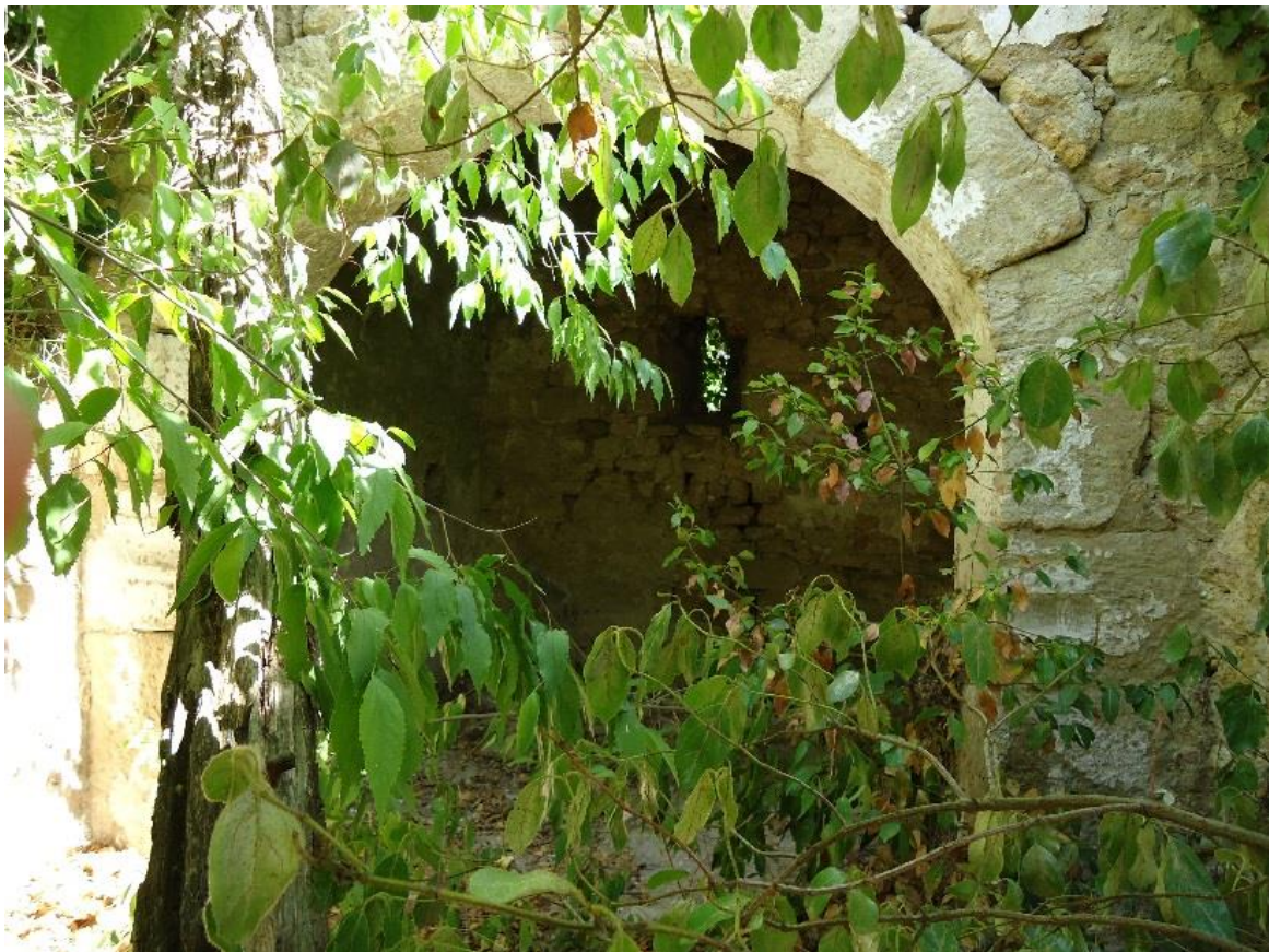
Figure 118 Vue de l'arc triomphal depuis la nef
