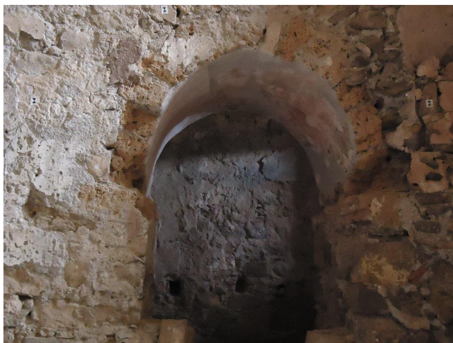
Figure 416 L'arc en champignon de la porte au rez-de-chaussée de la tour
