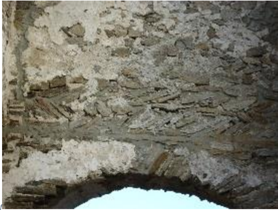
Figure 94 Détail de l'arc triomphal,, côté nef
