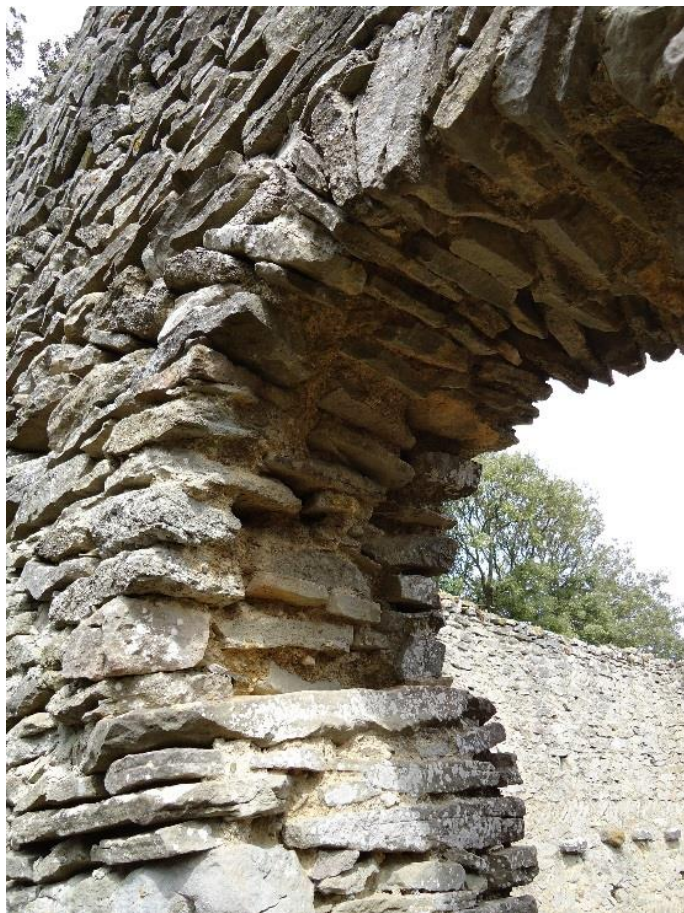
Figure 812 L'intrados de la porte occidentale
