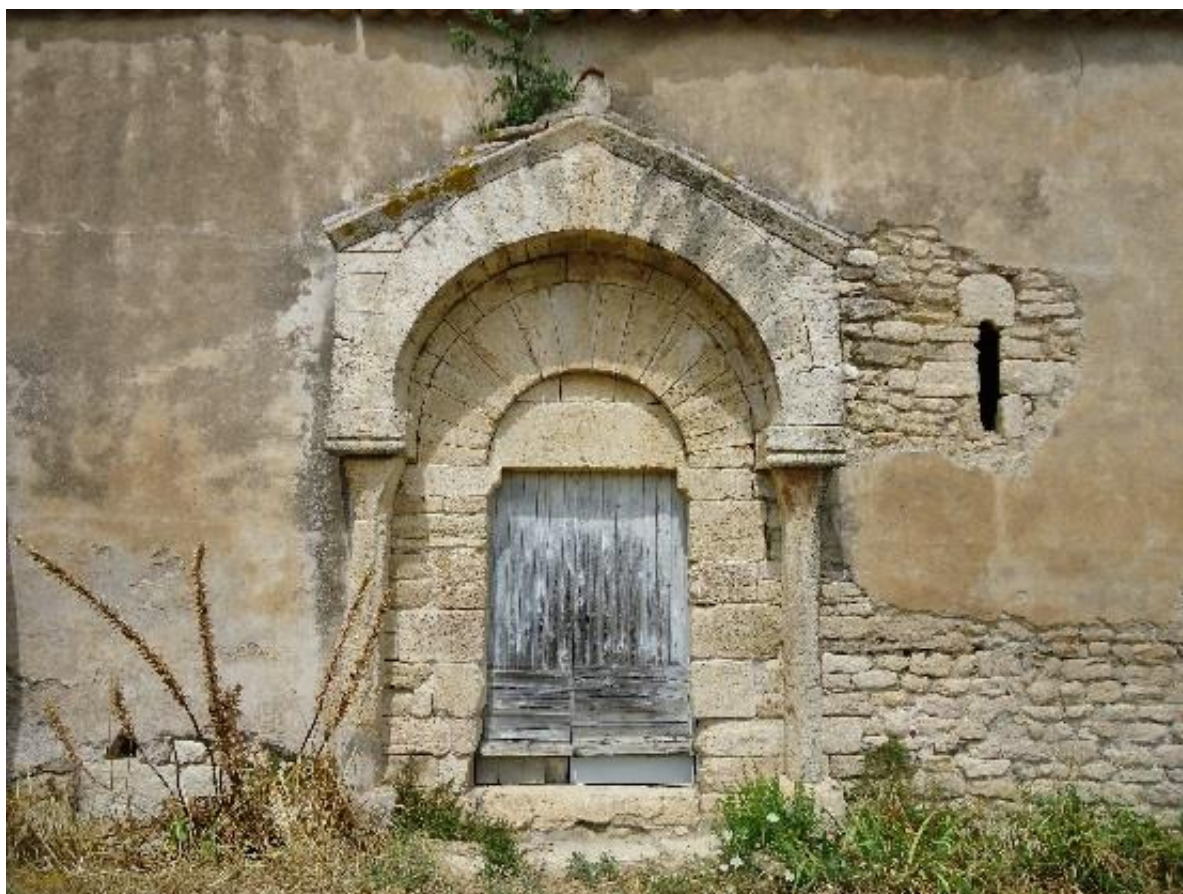
Figure 652 Porte méridionale de la nef avec sa baie
