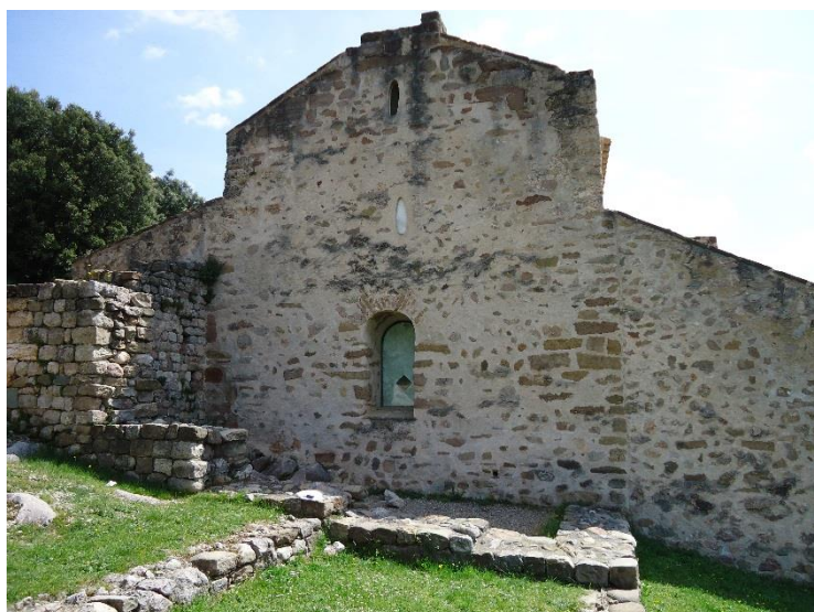
Figure 196 Vue de la façade occidentale
