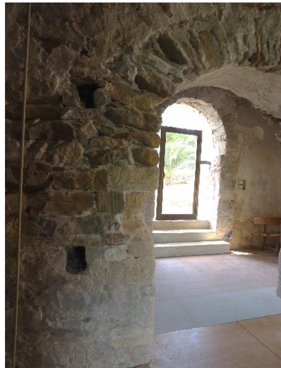
Figure 108 Porte sud, intérieur
