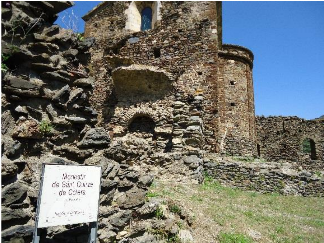
Figure 636 Vue sud des vestiges
