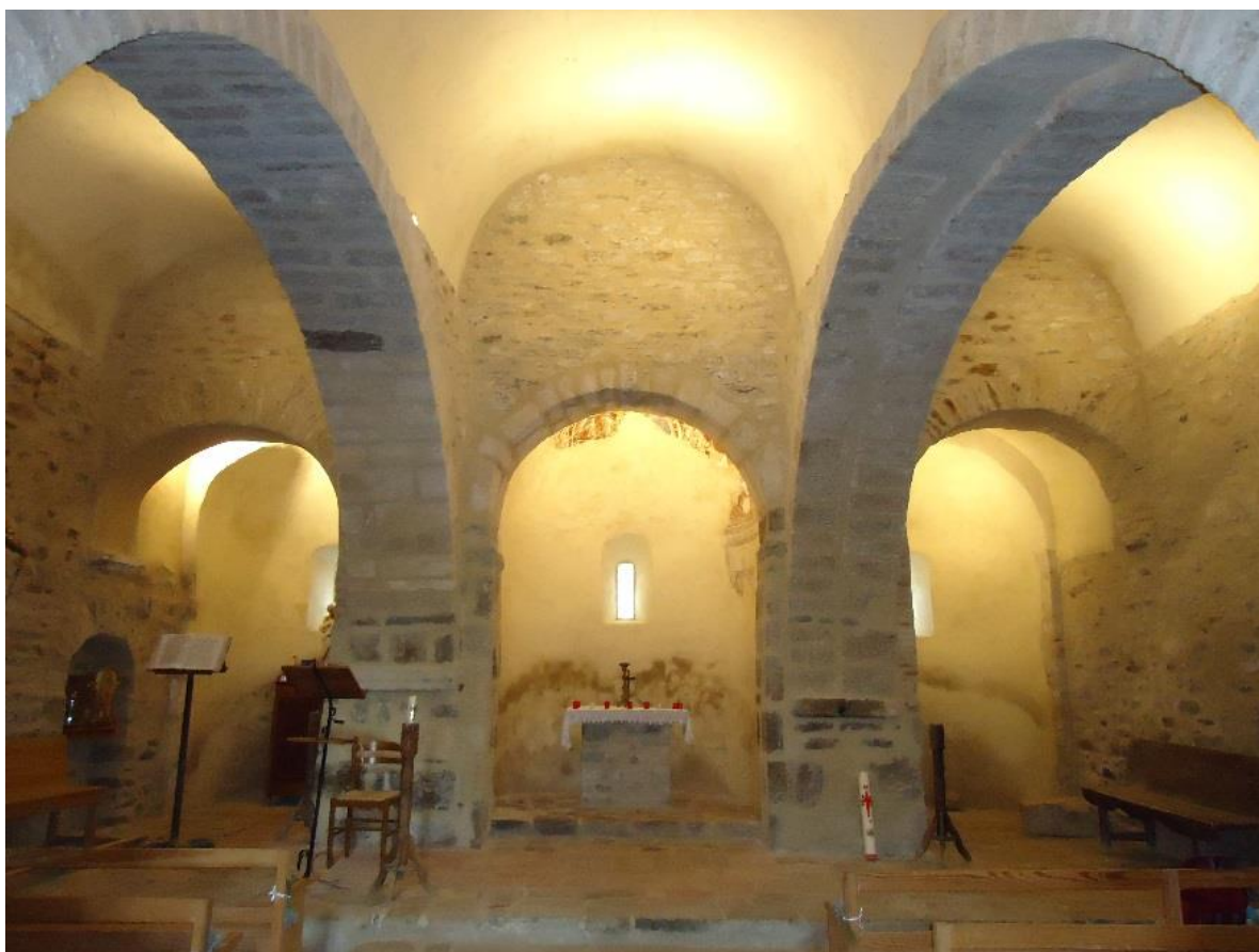
Figure 408 Vue intérieure des trois absides
