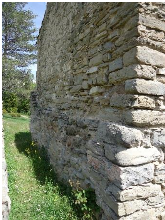
Figure 23 Vue de la façade occidentale
