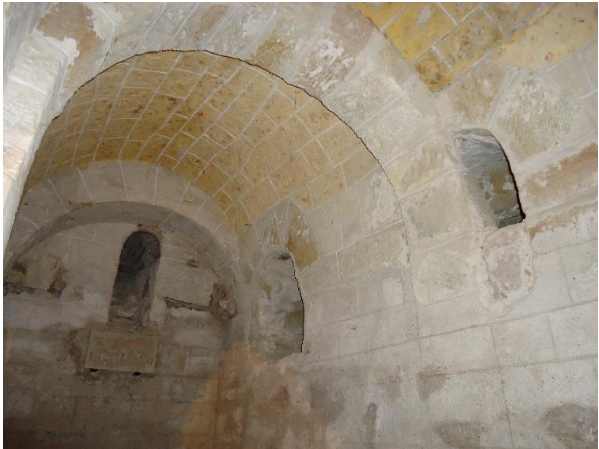
Figure 482 Bas-côté sud, première travée, arc doubleau partiellement masquant la baie
