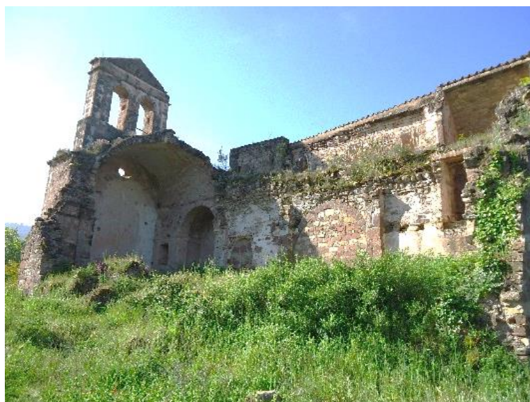
Figure 640 Vestiges de l'église romane disparue au nord
