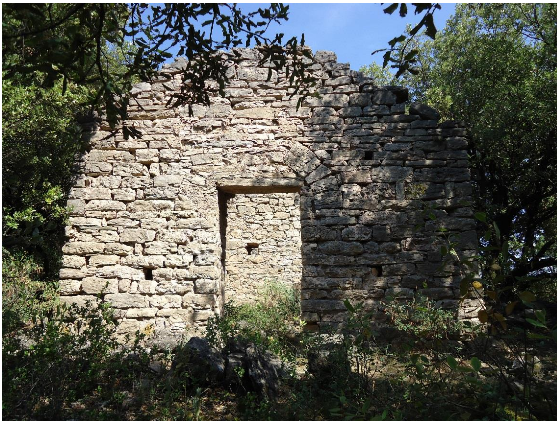
Figure 799 Façade occidentale avec sa porte
