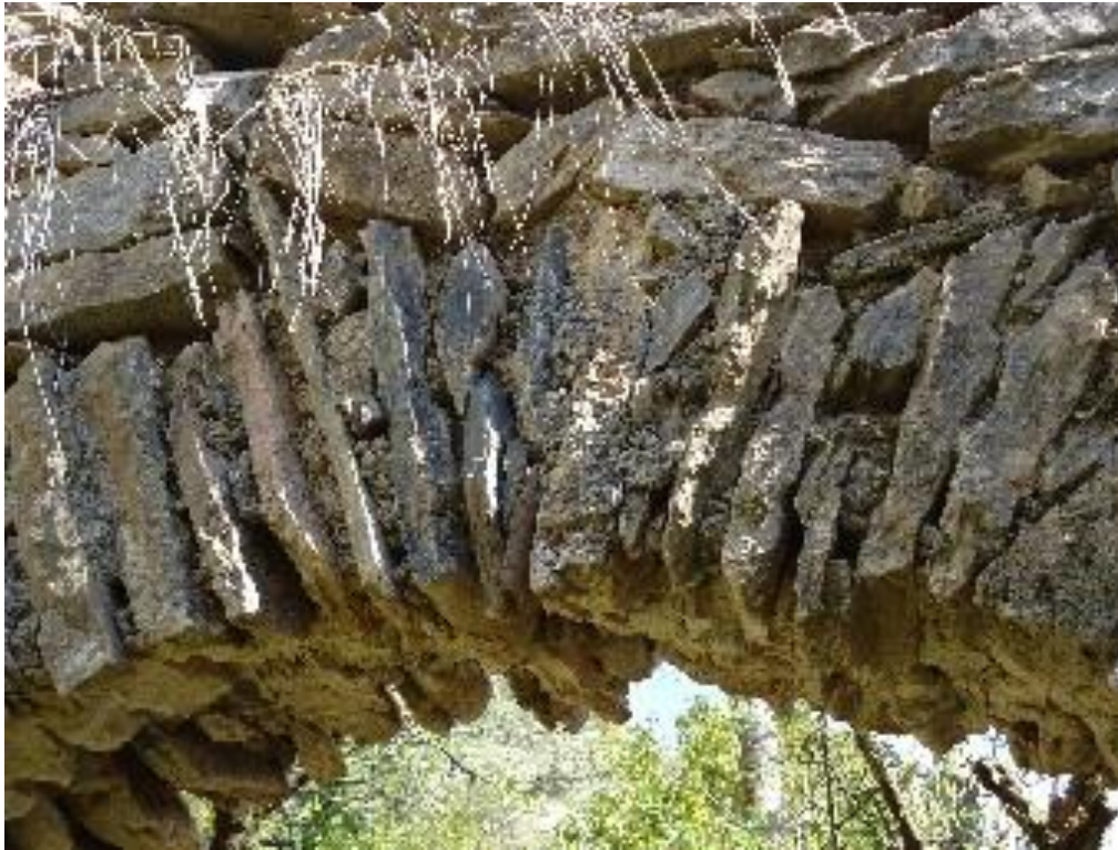
Figure 620 Détail de l'arc triomphal, côté nef
