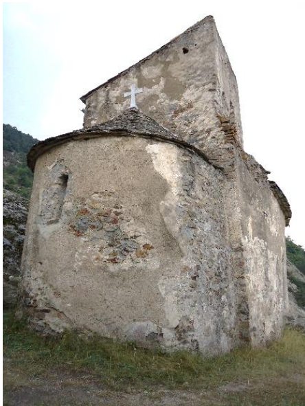
Figure 223 Vue extérieure nord-est
