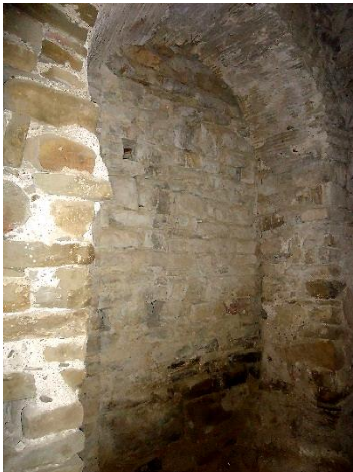
Figure 311 L'arc muré entre le bras nord du transept et le vaisseau nord disparu
