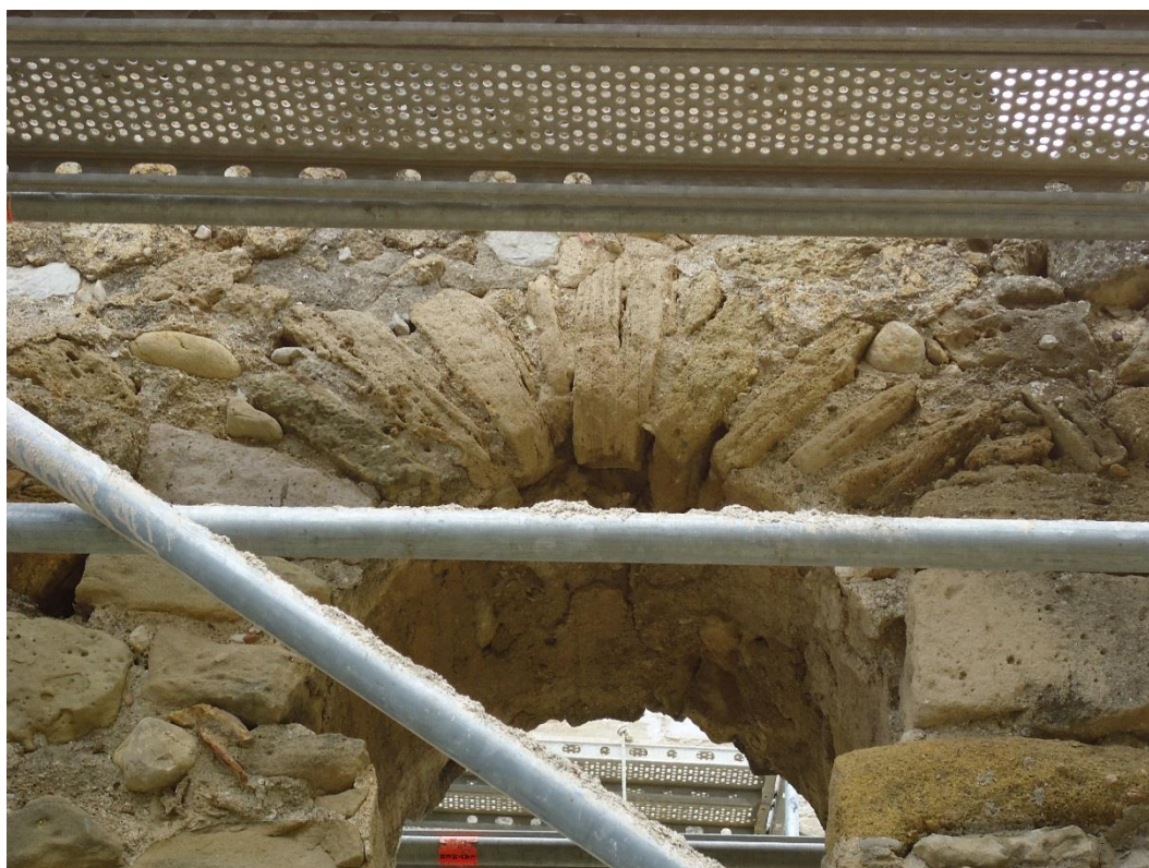
Figure 807 Vue extérieure de la porte méridionale
