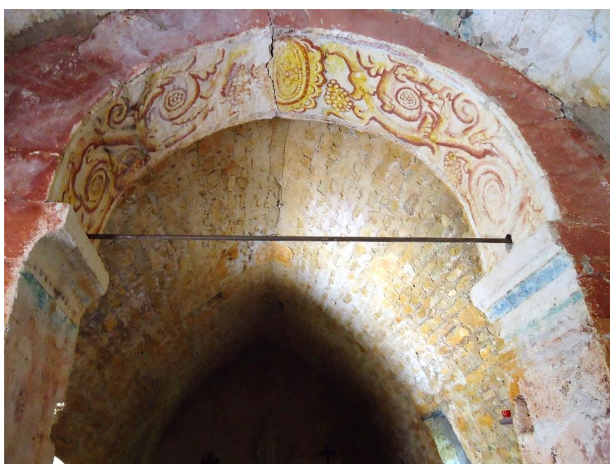
Figure 461 L'arc triomphal avec ses impostes, vue depuis le chevet
