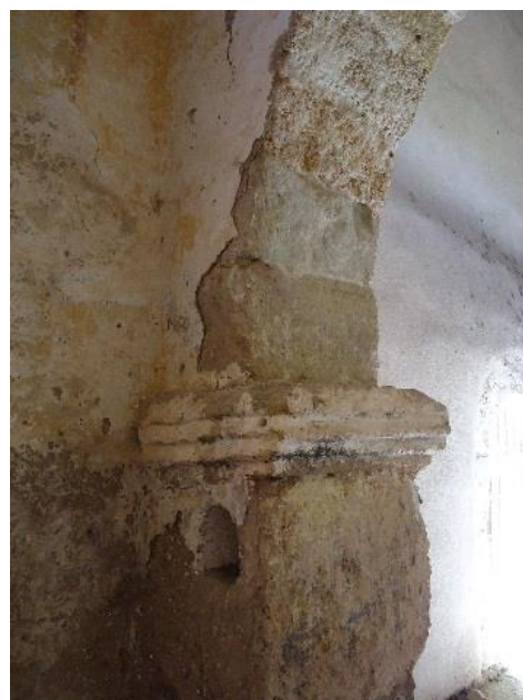
Figure 216 Piédroit sud de l'arc triomphal avec imposte moulurée
