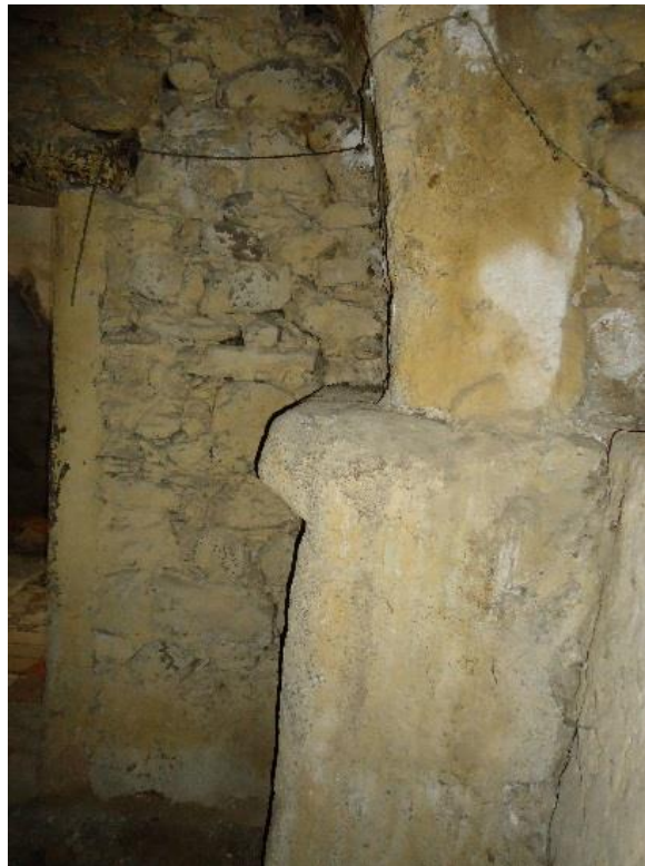
Figure 428 Imposte et retombée sud de l'arc triomphal
