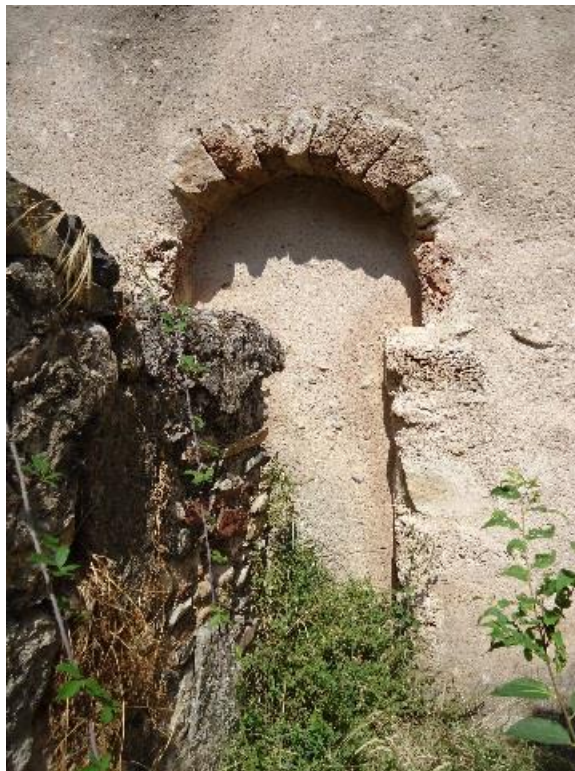
Figure 220 Vue de la même porte, extérieur
