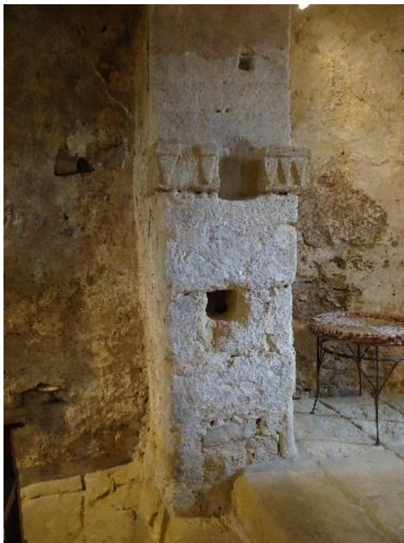
Figure 605- 606 Piédroit nord de l'arc triomphal avec son imposte
