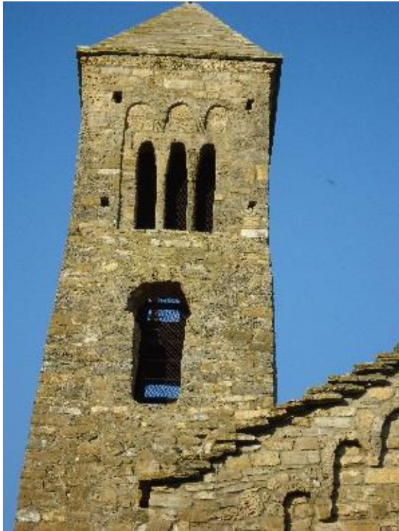
Figure 267 Paroi occidentale du clocher-tour
