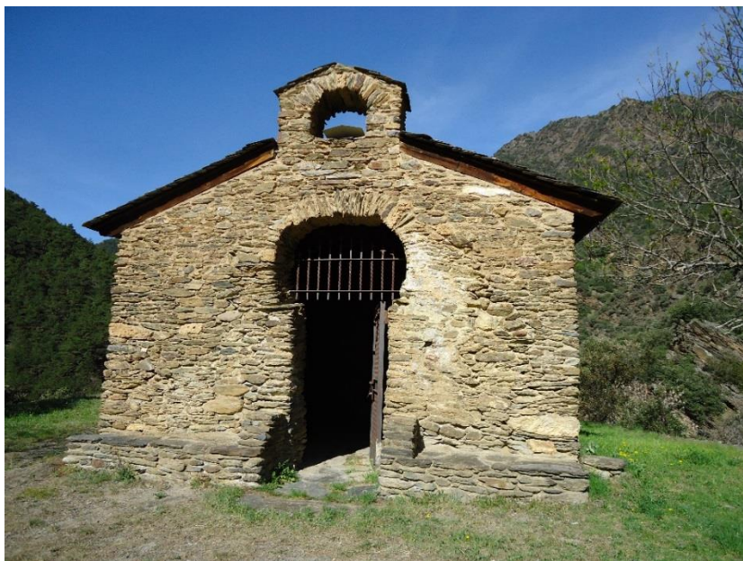
Figure 9 Vue extérieure après la reconstruction
