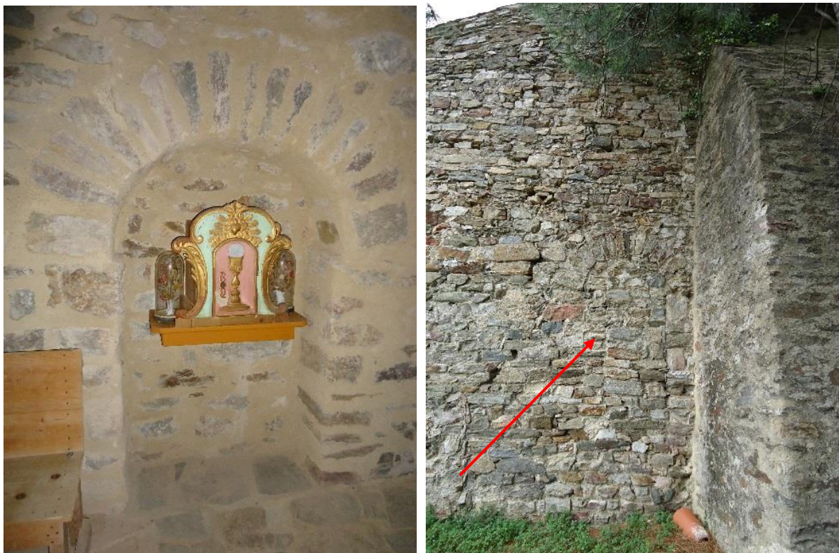
Figure 411 Petite porte nord bouchée, intérieure et extérieure
