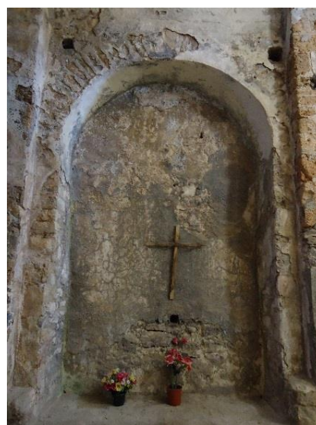
Figure 145 Arc latéral, troisième travée devant le chevet
