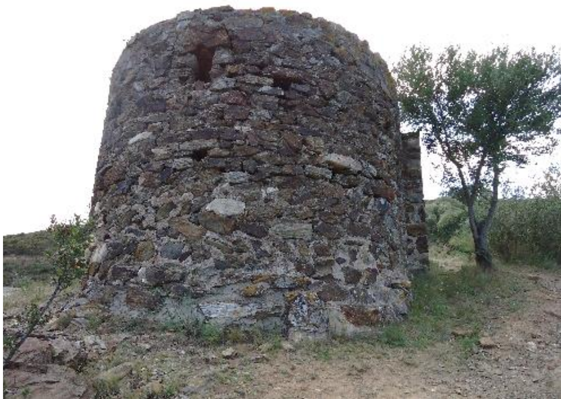
Figure 466 Vue extérieure de l'abside
