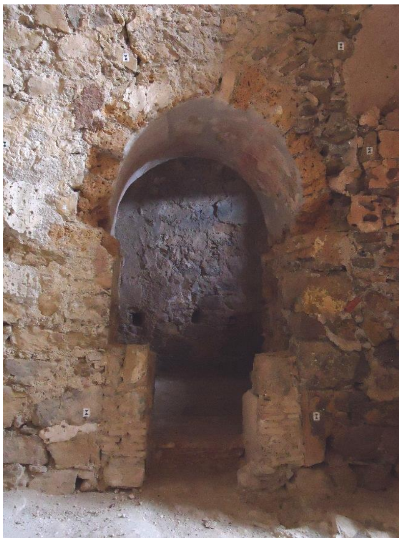
Figure 415 Porte au rez-de-chaussée de la tour
