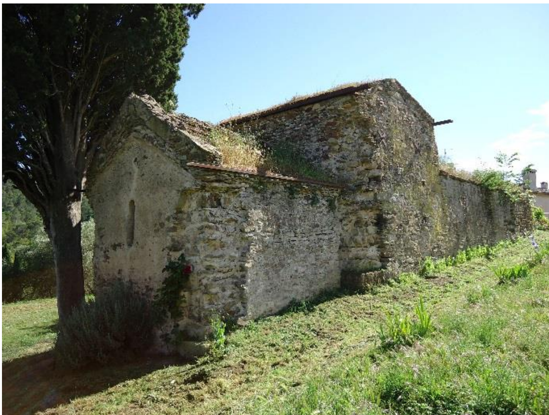
Figure 388 Vue nord-est avec l'arrachage des pierres d'angle
