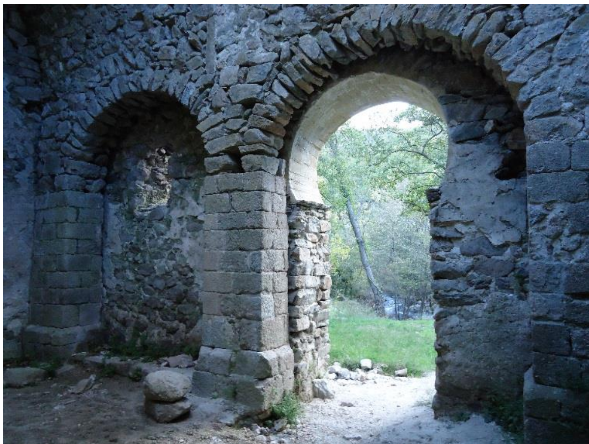
Figure 768 Les arcs latéraux sud de la nef
