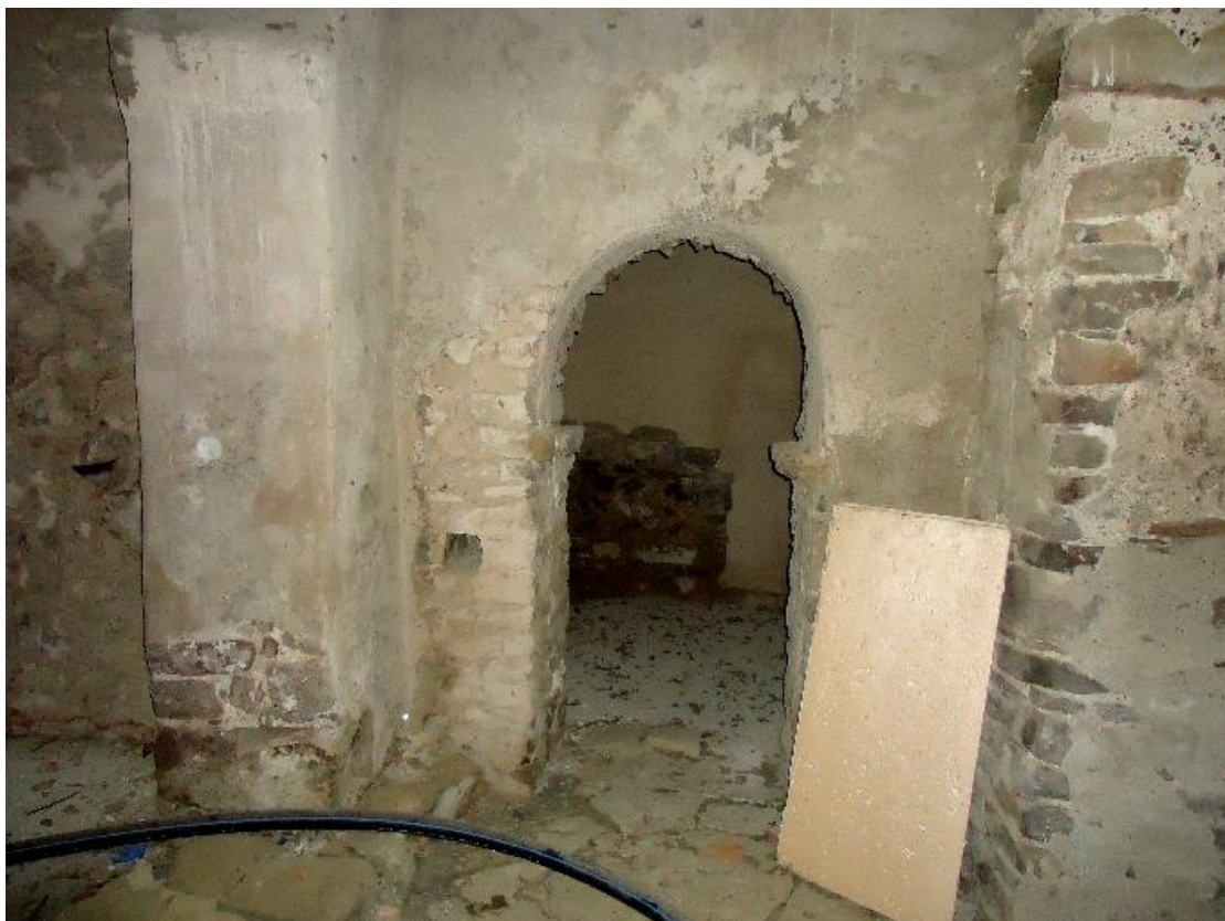
Figure 309 Ouverture du bras sud disparu du transept
