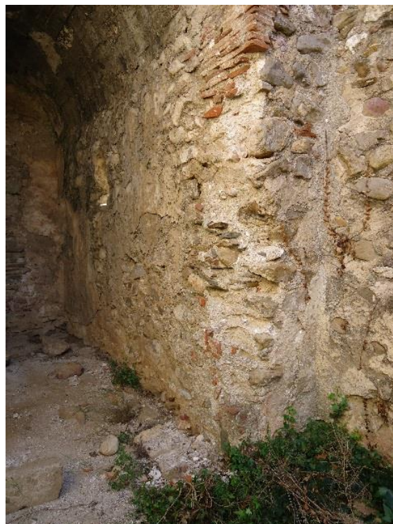
Figure 402 Base supposée du piédroit sud
