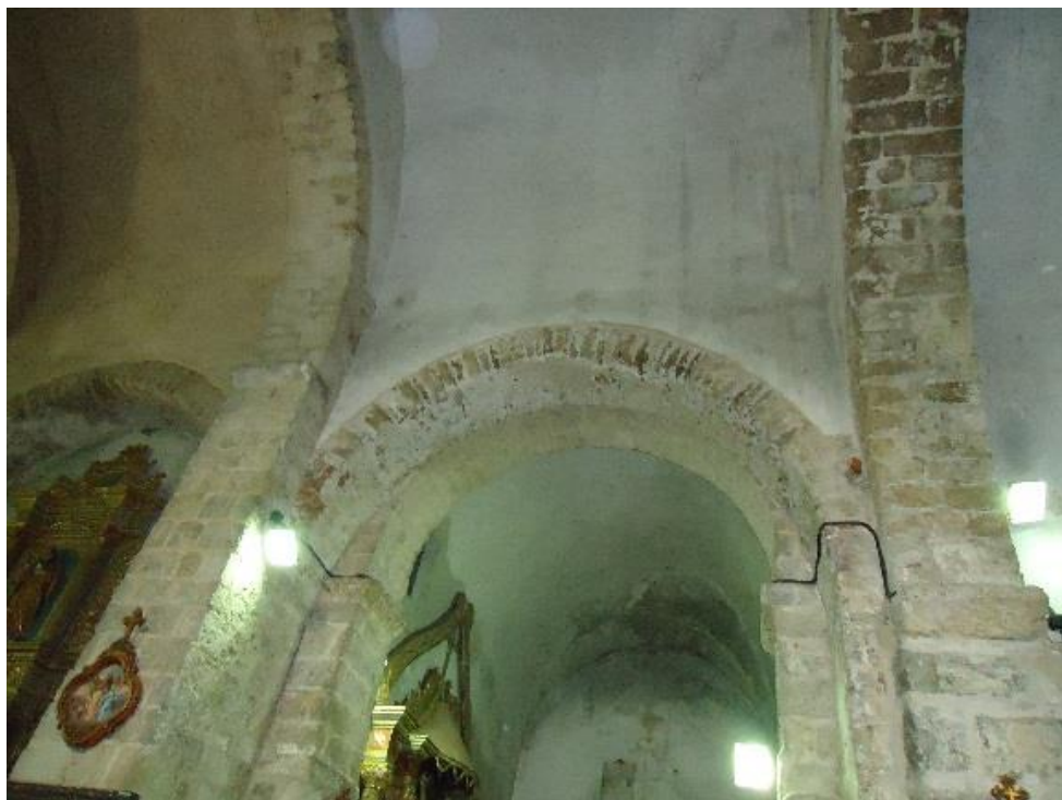
Figure 659 Rencontre de la voûte du bras nord du transept et celle de la nef
