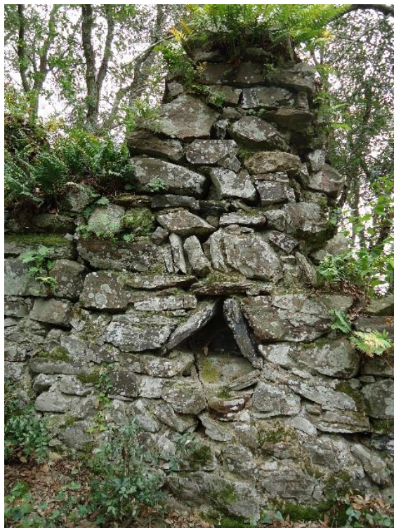
Figure 153 Détail du mur occidental, intérieur
