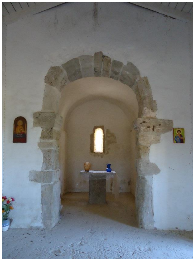
Figure 552 Le mur diaphragme avec l'arc triomphal à deux rouleaux avant la restauration
