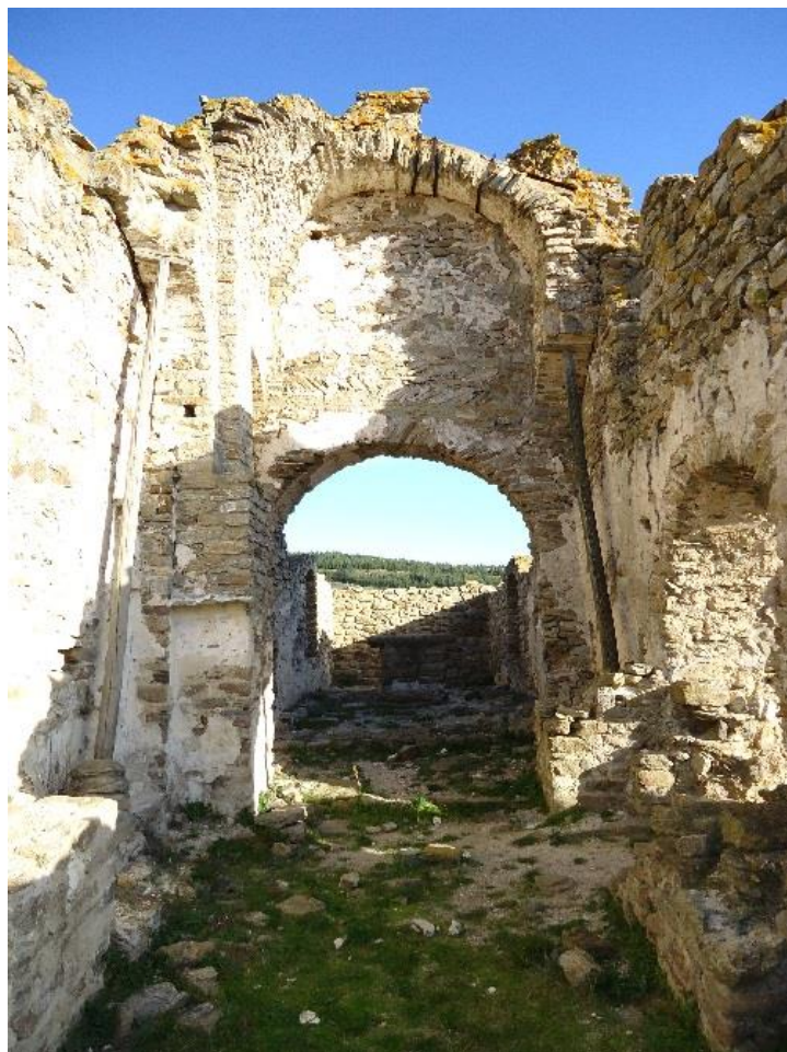
Figure 93 Vue de l'arc triomphal depuis la nef
