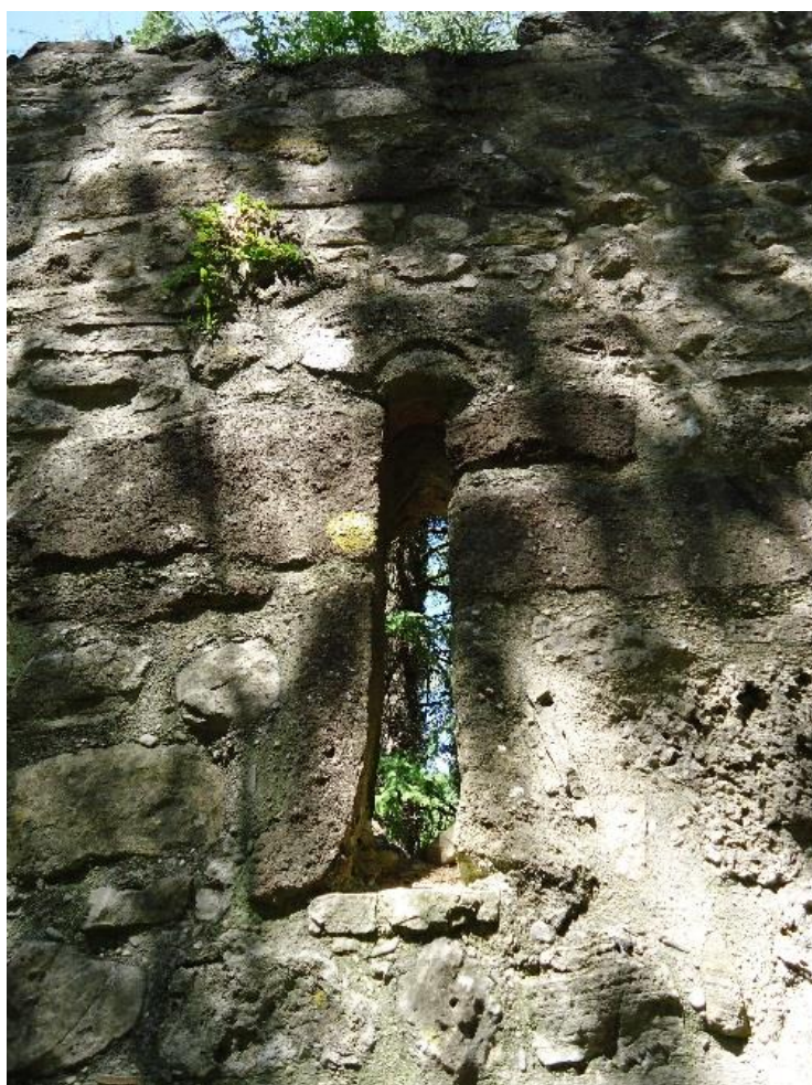
Figure 493 Fenêtre sud du chevet
