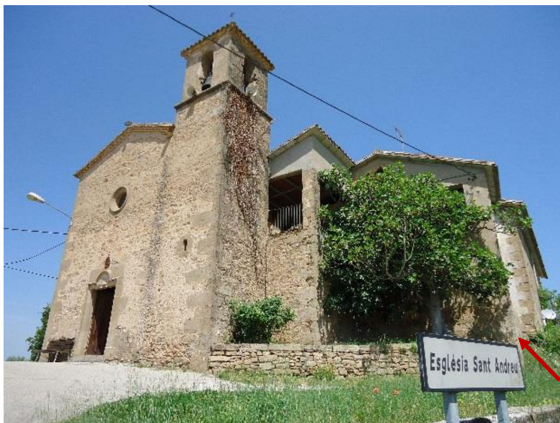
Figure 534 Vue extérieure, la flèche indique l'emplacement du chevet de l'ancienne église
