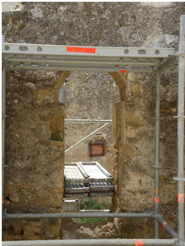
Figure 806 Vue intérieure de la porte méridionale
