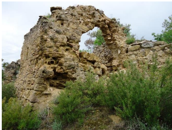
161 Vue sud-est depuis le chevet disparu avec l'angle taluté de la nef
