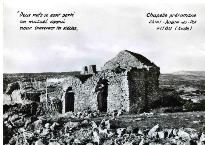
Figure 355 Etat avant la reconstruction, DRAC Montpellier
