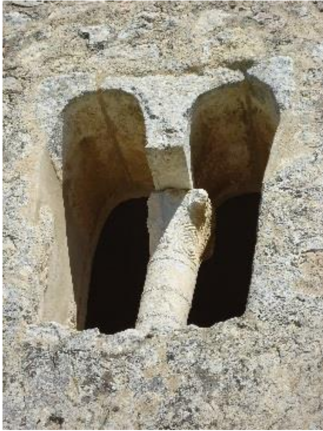
Figure 579 Baie géminée de la façade occidentale
