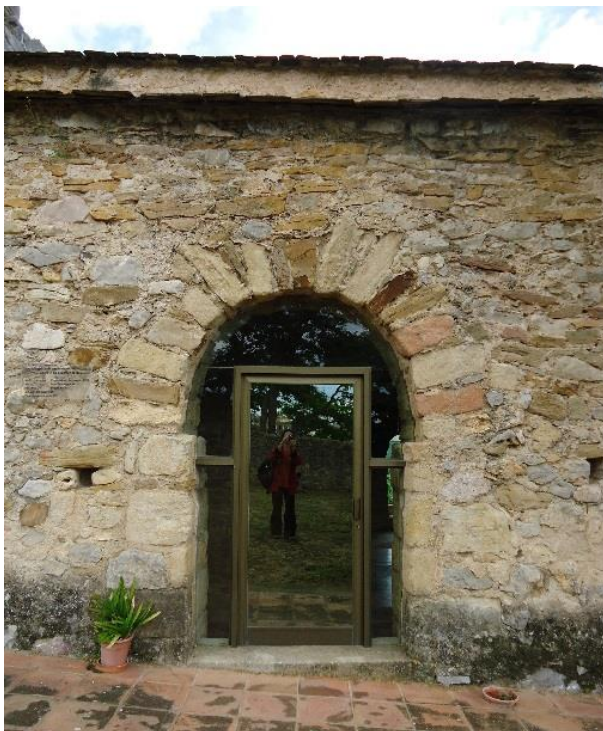
Figure 107 Porte sud, extérieur
