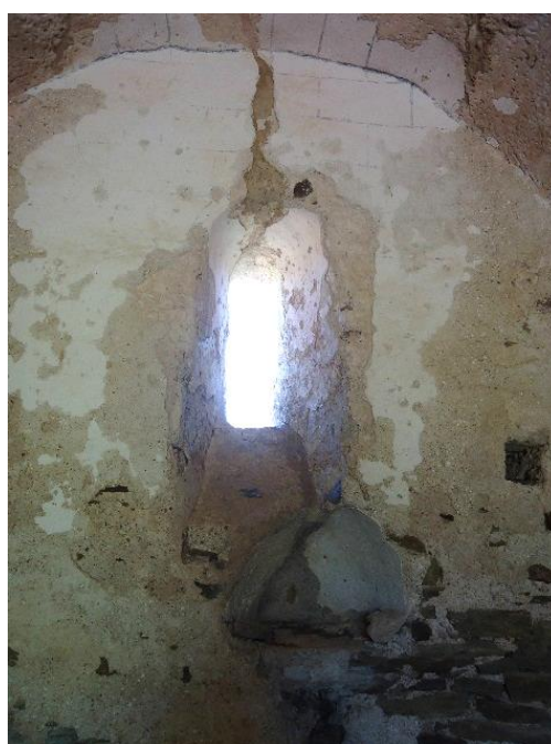
Figure 395 Ébrasement asymétrique de la fenêtre d'axe du chevet
