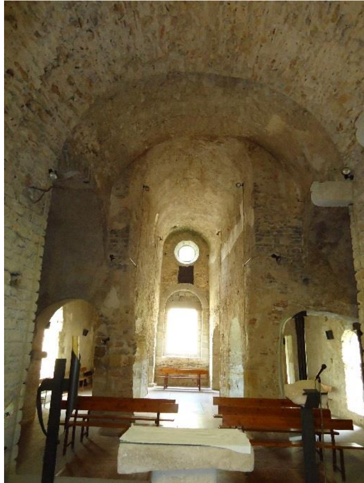
Figure 101 Vue du transept et de la nef depuis le chœur
