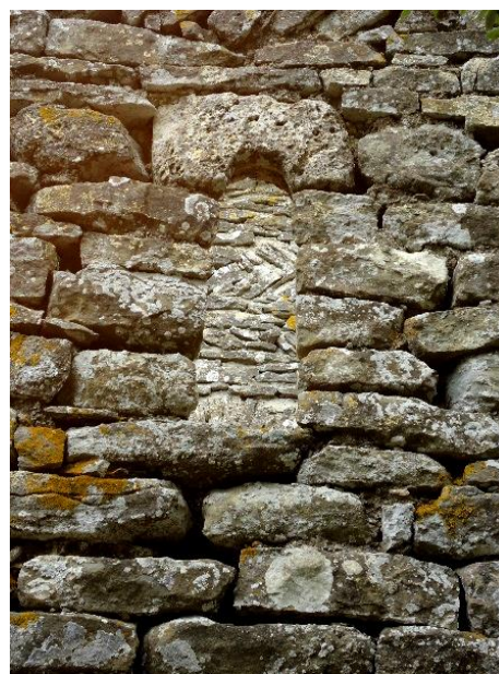
Figure 819- 820 Fenêtres sud et est du chevet
