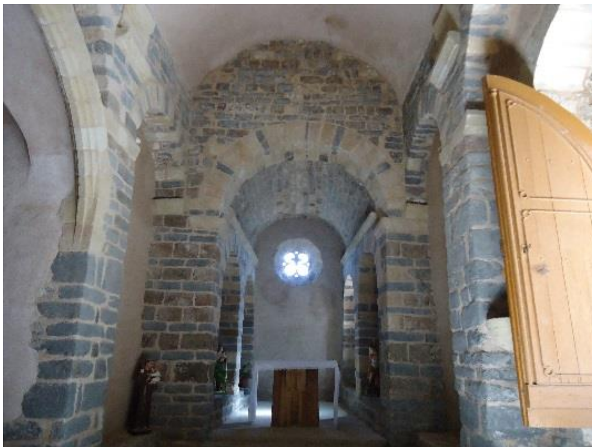
Figure 527 Vue intérieure d'ouest en est
