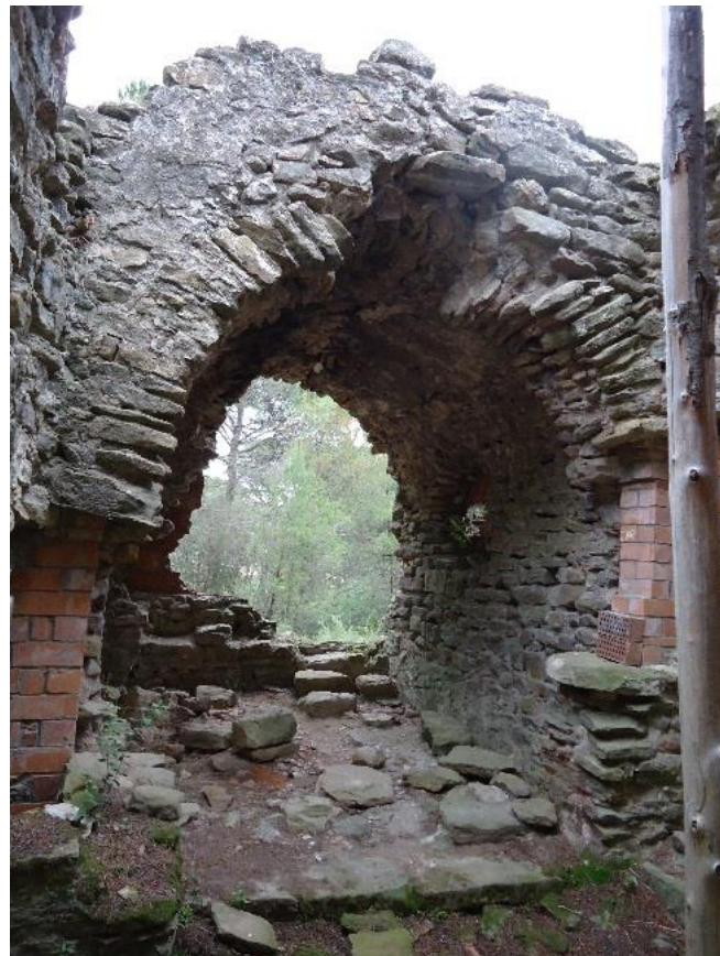
Figure 369 Vue de l'arc triomphal et de la voûte du chevet
