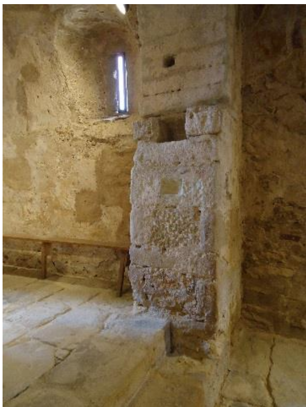
Figure 607- 608 Piédroit sud de l'arc triomphal avec son imposte, en arrière-plan la voûte sur banquette du chevet
