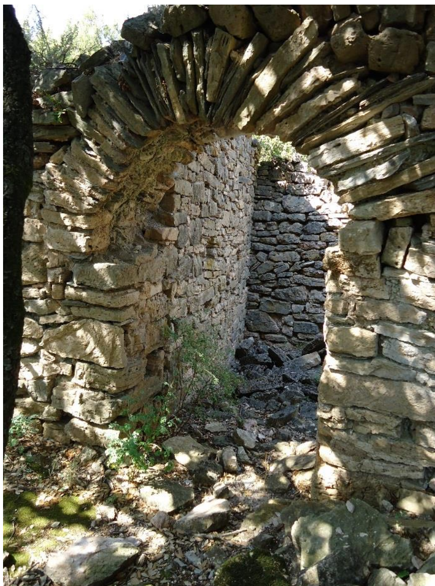
Figure 796 Vue extérieure de la porte méridionale
