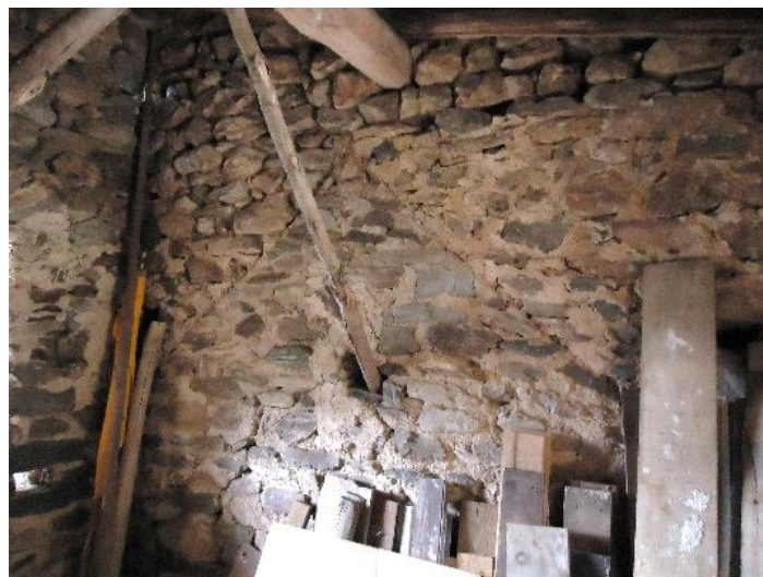
Figure 225 Trace de l'ancienne toiture en bâtière sous les combles
