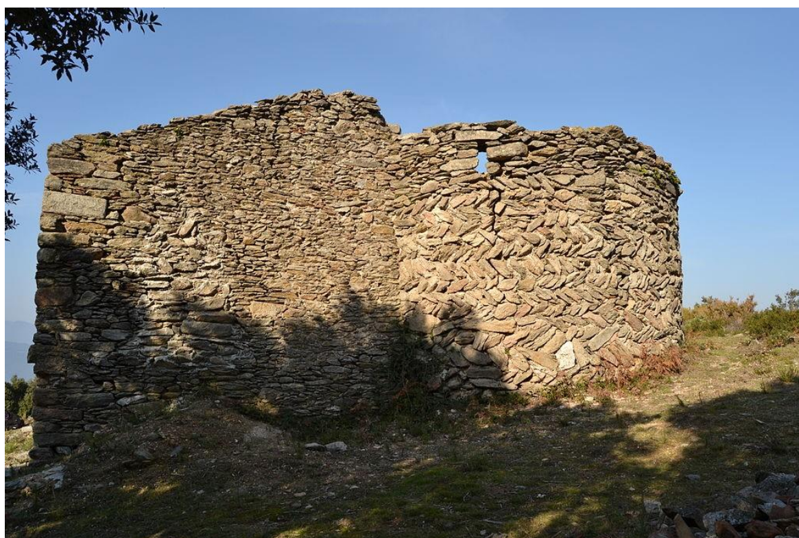
Figure 435 Vue est de l'abside et du mas adossé au sud, Inventari
