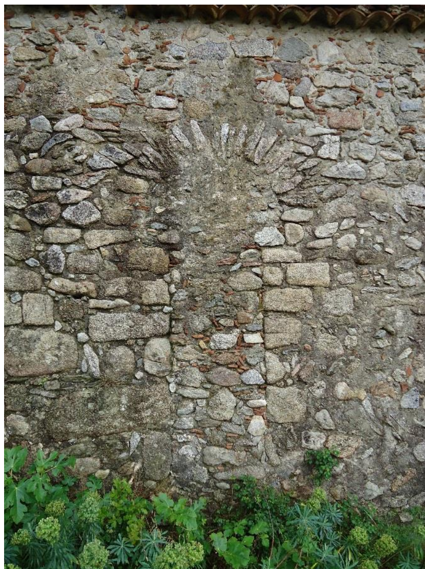
Figure 431 Porte nord bouchée, en champignon
