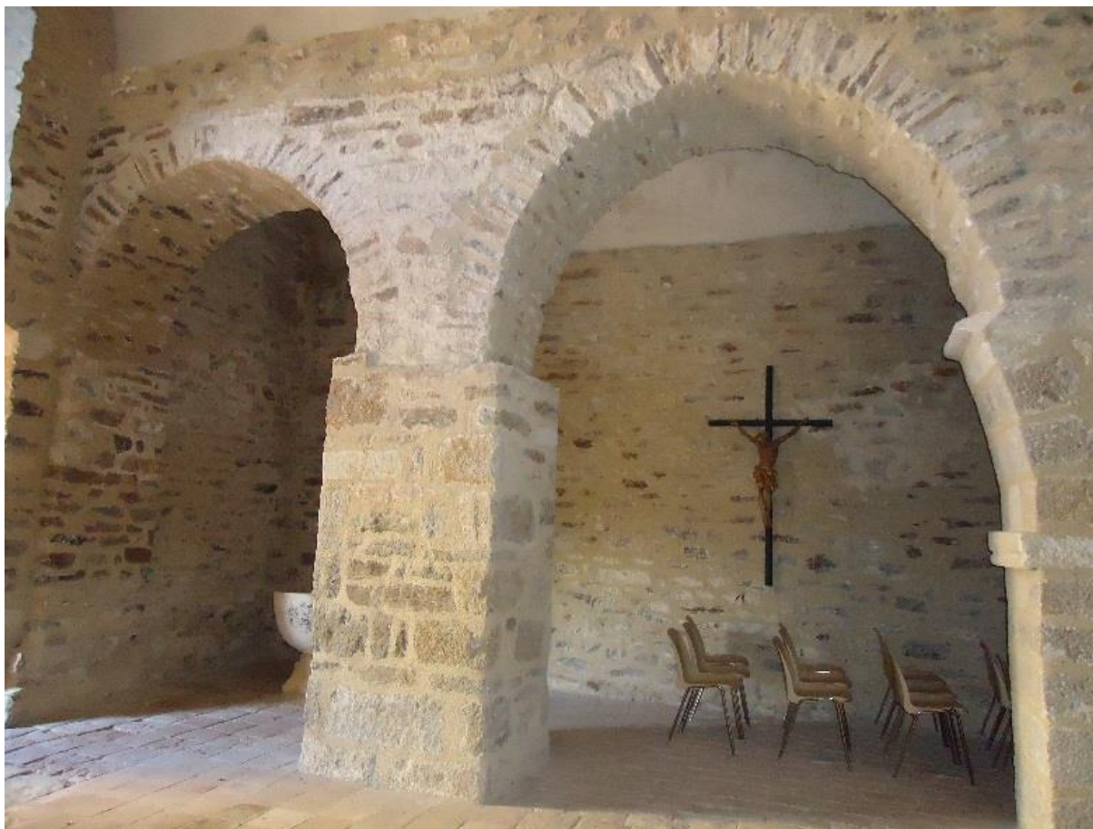
Figure 410 Arcade nord entre la première et la deuxième travées occidentales
