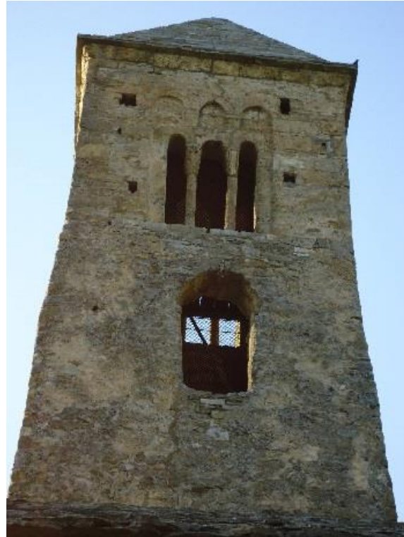
Figure 270 Paroi sud du clocher-tour
