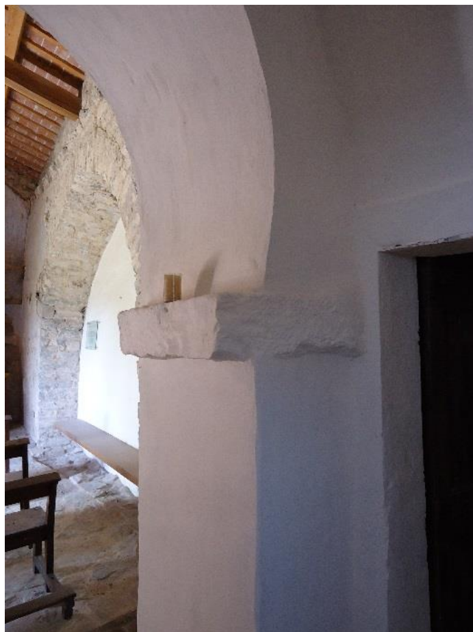
Figure 27 Vue de l'arc triomphal avec son imposte nord
