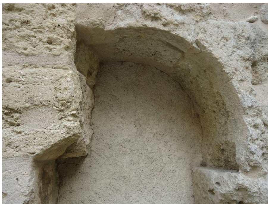
Figure 563 Détail de l'arc outrepassé
