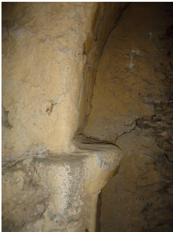
Figure 427 Imposte et retombée nord de l'arc triomphal
