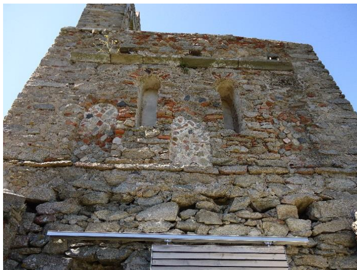
Figure 331 Façade méridionale de la tour avec ses niches en opus reticulatum et ses baies en champignon
