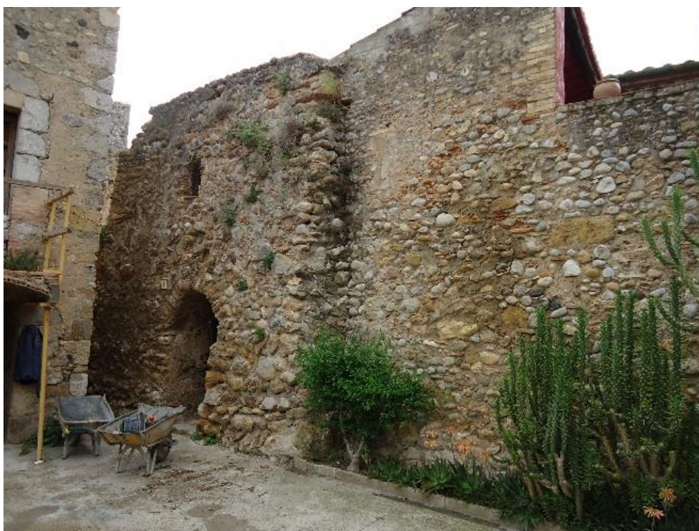
Figure 789 Vue extérieure occidentale
