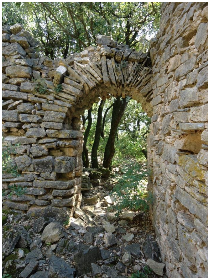
Figure 797 Vue intérieure de la porte méridionale
