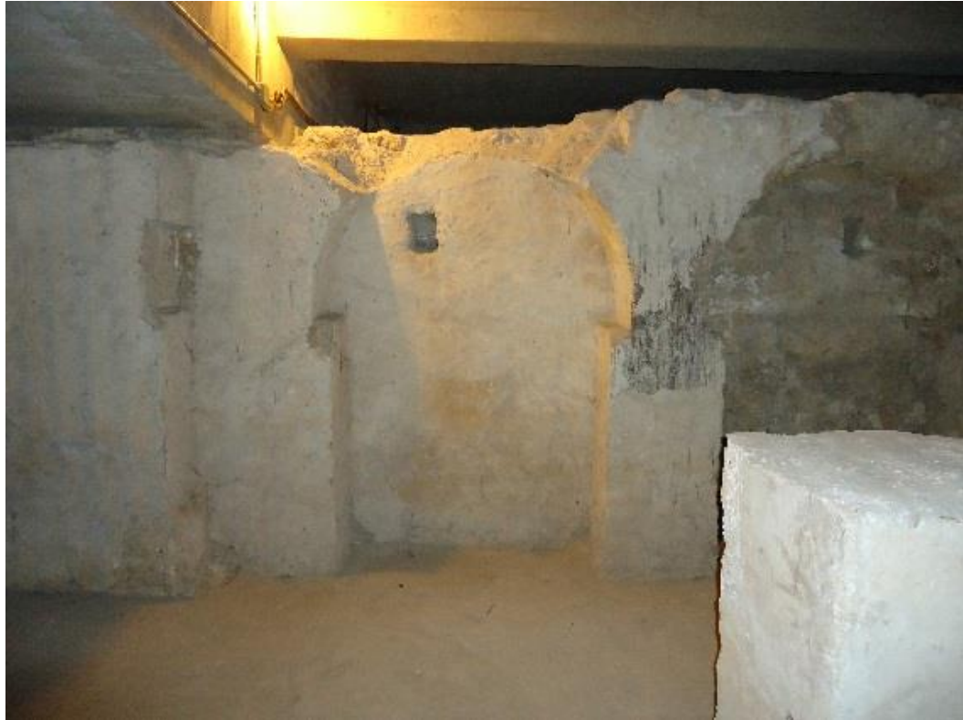
Figure 678 Première travée occidentale, côté nord
