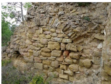
Figure 167 Arcade latéral; mur nord de la nef
