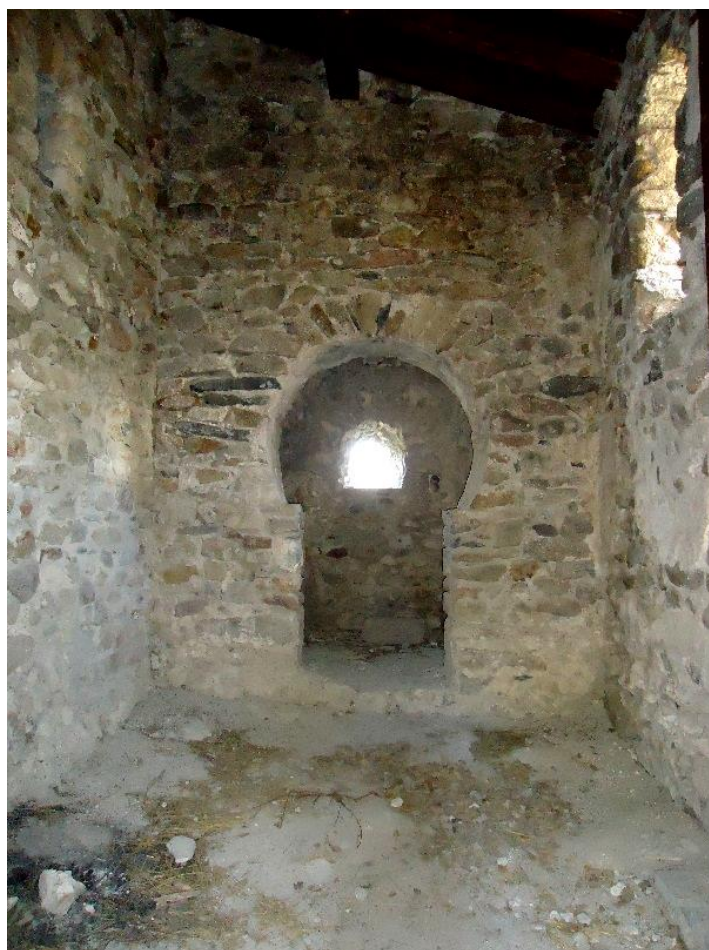
Figure 758 L'arc triomphal du vaisseau sud après la restauration
