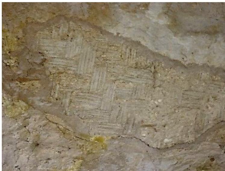
Figure 609 Traces du coffrage sur la voûte
