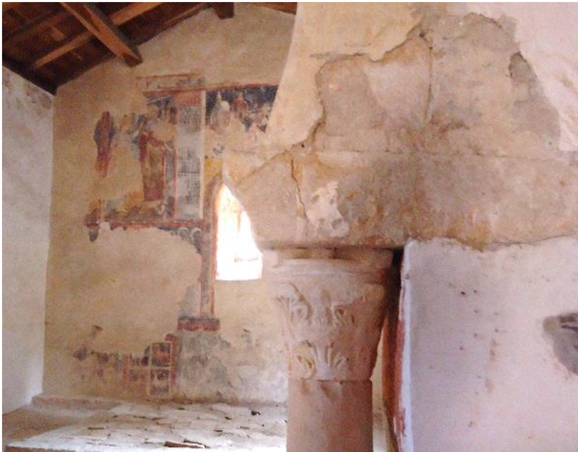
Figure 696 Imposte et chapiteau sud de l'arc triomphal
