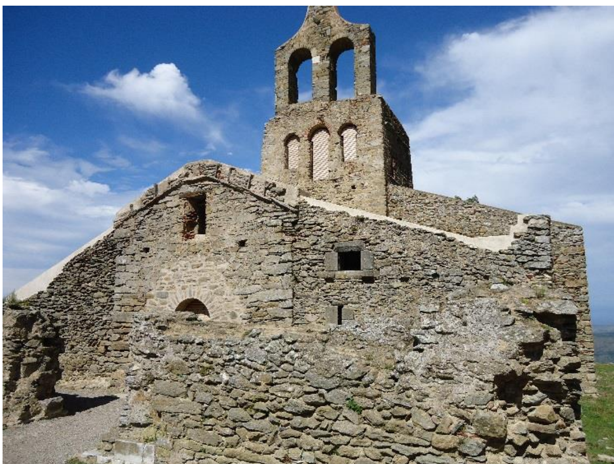
Figure 324 Vue de la façade occidentale
