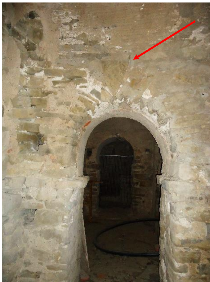
Figure 310 Revers de l'ouverture du bras nord du transept avec sa clé volumineuse
