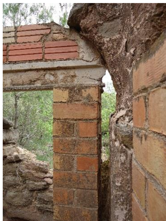
Figure 77 Détail de l'arc latéral est
