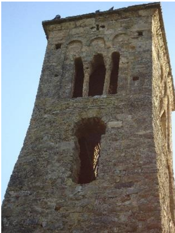
Figure 269 Parois est du clocher-tour
