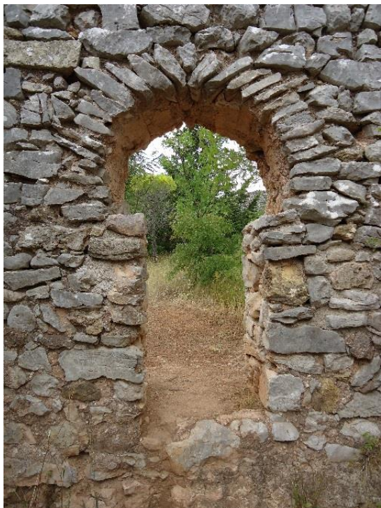
Figure 182 Porte occidentale, vue intérieure
