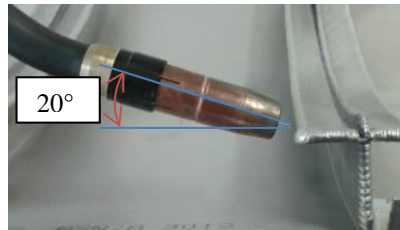
Figure 41 : Position de la torche pour la fabrication de murs horizontaux
