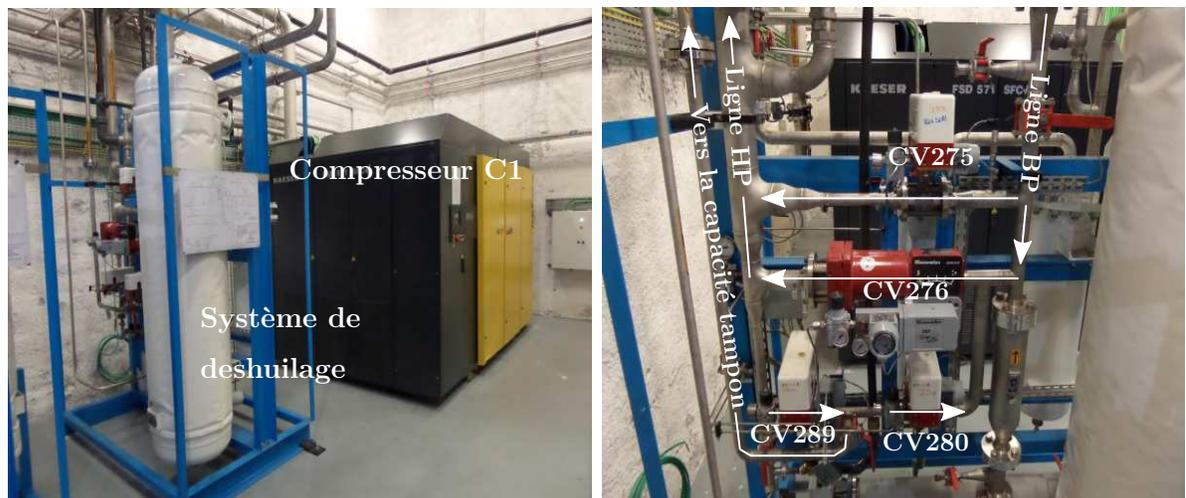
FIGURE 3.8 – À gauche, photo du compresseur C1 et de son système de déshuilage. À droite, photo des vannes de la zone chaude.
