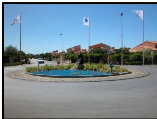
Figure 2.2 : Giratoire intermédiaire (Port Barcarès, France) Photographie : Michèle St-Jacques
