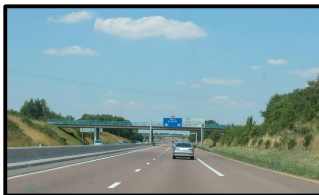
Figure 6.5 : Enrobé coloré (Autoroute A6, France)
