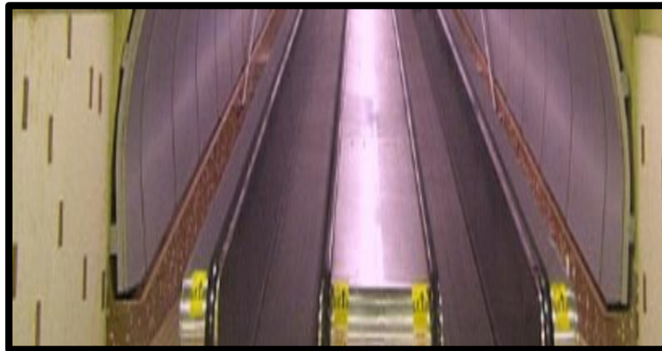
Figure 10.7 : Tapis roulant Métro Beaudry (Montréal) Source : http://www.emdx.org/photos/20080308_Metro/
