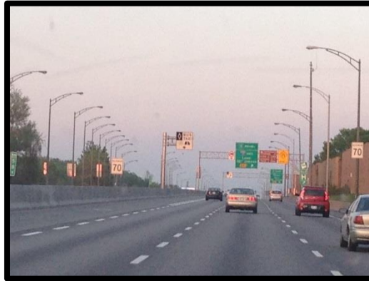
Figure 10.20 : Voie réservée sur autoroute (A20, Montréal)
