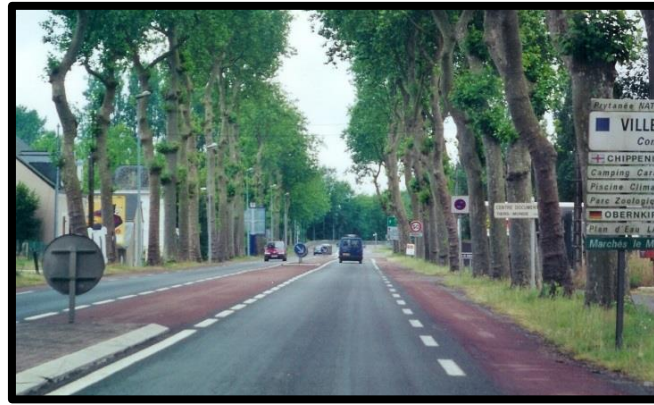
Figure 6.17 : Accotements en revêtements bitumineux colorés (La Flèche, France)
