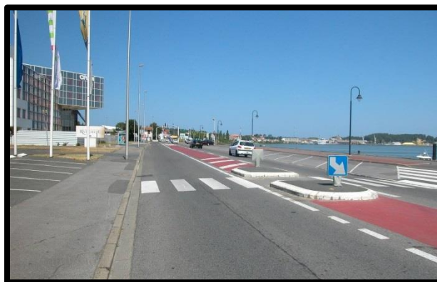
Figure 6.16 : Terre-plein en revêtement bitumineux coloré (Bayonne, France)
