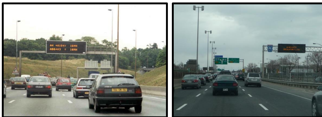
Figure 3.11 : Panneaux à messages variables (France et Québec)
