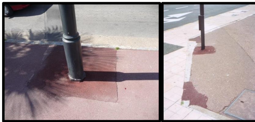
Figure 6.26 : Réparations sur revêtement bitumineux coloré Photographies : Michèle St-Jacques
