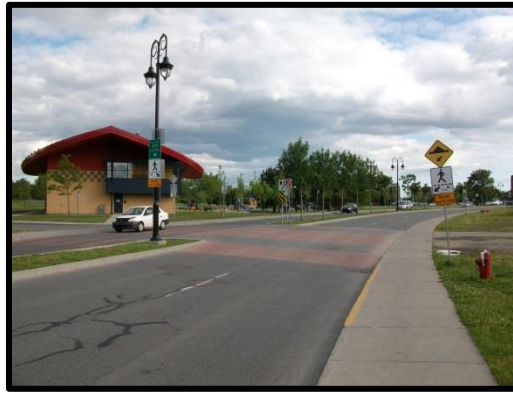
Figure 5.10 : Passage pour piétons surélevé (Verdun, Québec)
