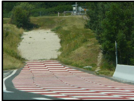
Figure 3.6 : Voie de secours (Annecy, France)
