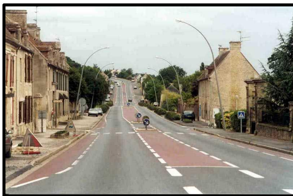
Figure 5.4 : Réduction de la largeur des voies de circulation (Moulins, France)
