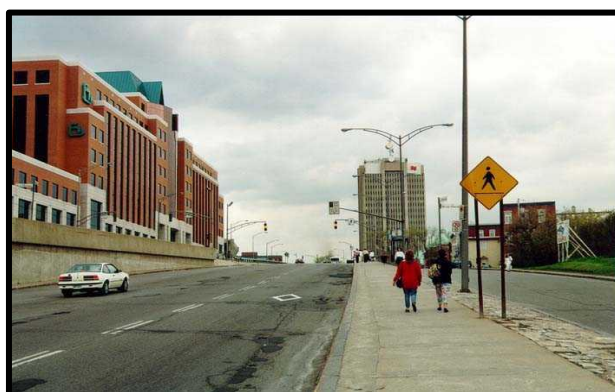
Figure 5.19: Boulevard René-Lévesque Est à l'origine (Québec, Québec)
