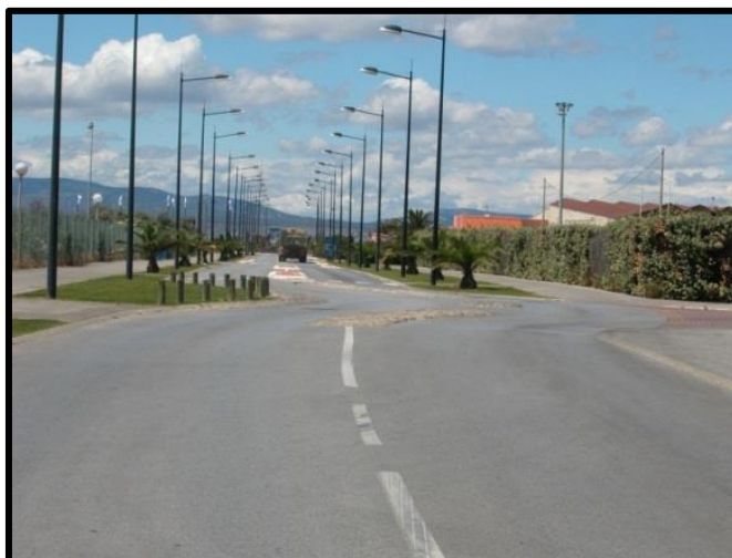
Figure 5.7 : Déviation de l'axe de la route (Barcarès, France)
