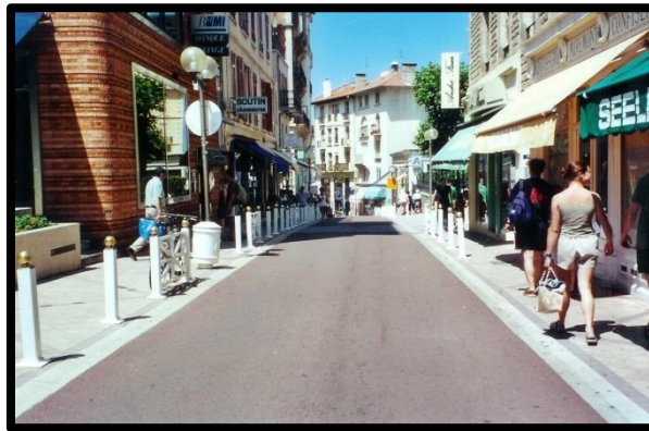
Figure 6.15 : Chaussée entière en revêtement bitumineux coloré (Biarritz, France)
