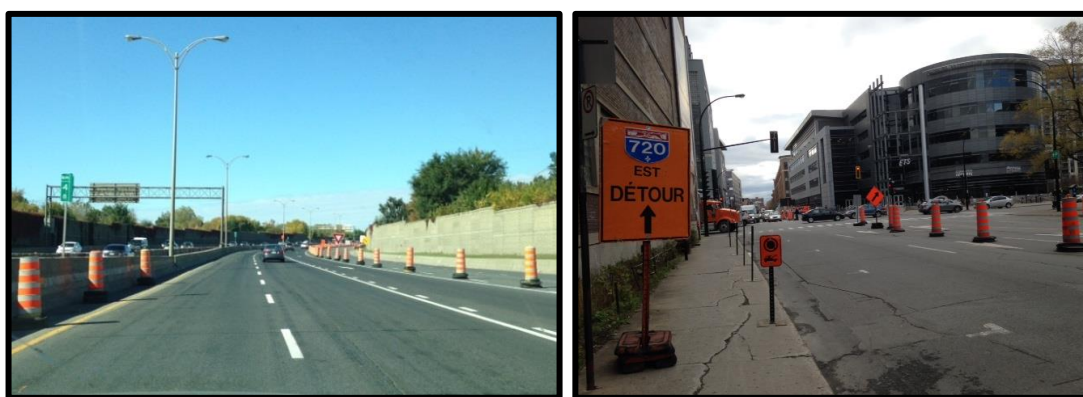
Figure 3.27 : Travaux routiers dans la région de Montréal
