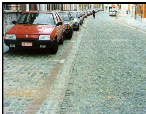
Figure 4.6 : Stationnement surélevé sur rue (Belgique)
