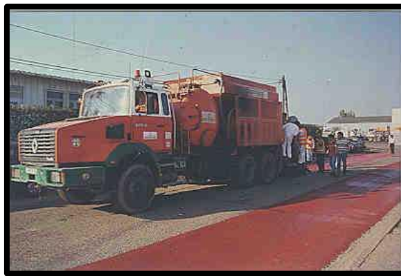
Figure 6.2 : Enrobé coulé à froid de couleur rouge (France)
