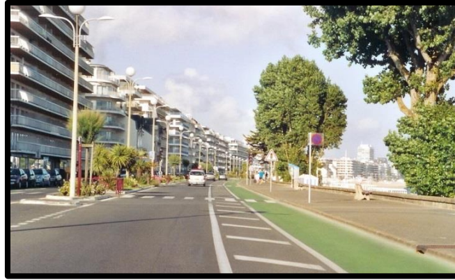
Figure 6.21 : Piste cyclable en revêtement bitumineux coloré (La Baule, France)
