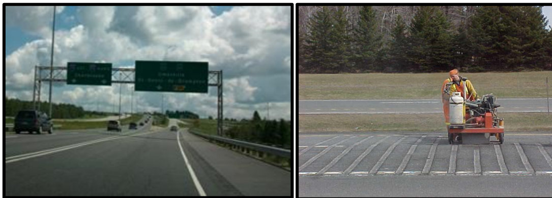
Figure 3.8 : Bandes rugueuses en bordure d'autoroute (Québec)
