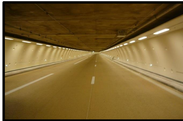
Figure 6.22 : Tunnel en revêtement bitumineux coloré (Duplex A86, France)
