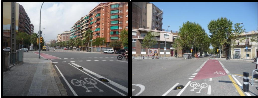
Figure 9.23 : Prolongement de voie cyclable dans le carrefour (Barcelone, Espagne)
