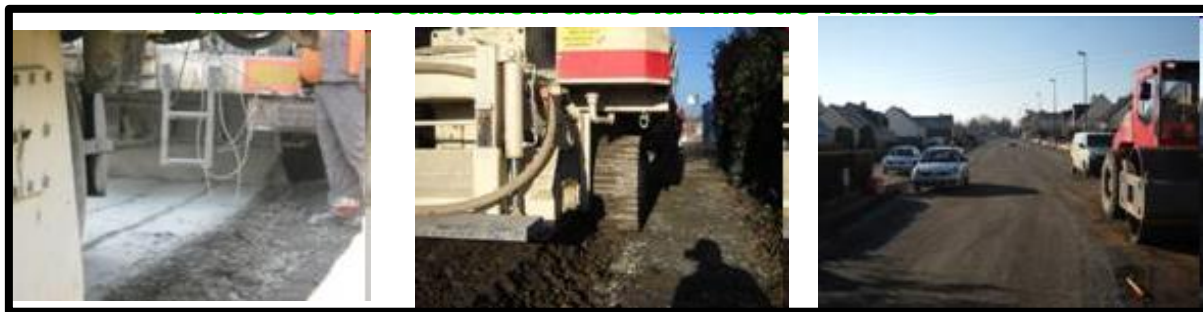
Figure 7.4 : Recyclage en place à froid (Nantes, France)
