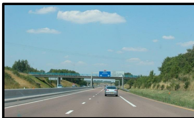
Figure 6.5 : Enrobé coloré (Autoroute A6, France)
