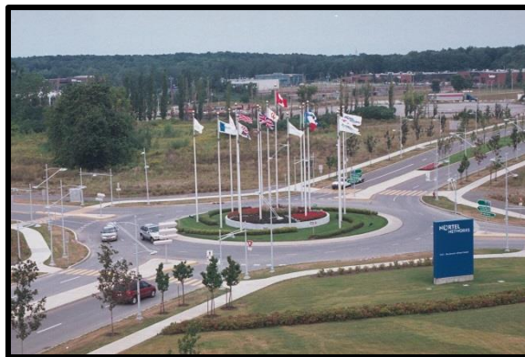
Figure 2.9 : Premier carrefour giratoire du Québec (Ville St-Laurent)
