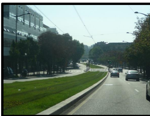
Figure 10.13 : Ligne de tramway à Paris (France)
