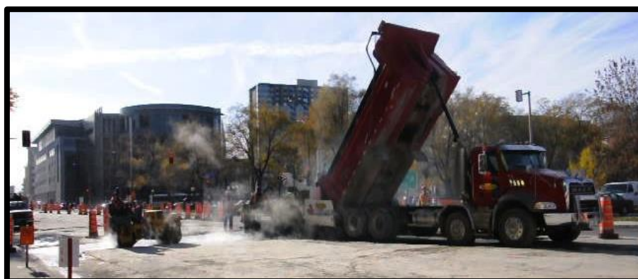
Figure 8.1 : Fumée provenant d'un enrobé à chaud traditionnel
