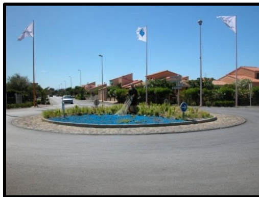
Figure 2.2 : Giratoire intermédiaire (Port Barcarès, France) Photographie : Michèle St-Jacques
