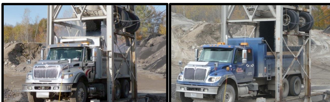
Chargement d'un camion en enrobé chaud à 160°C
