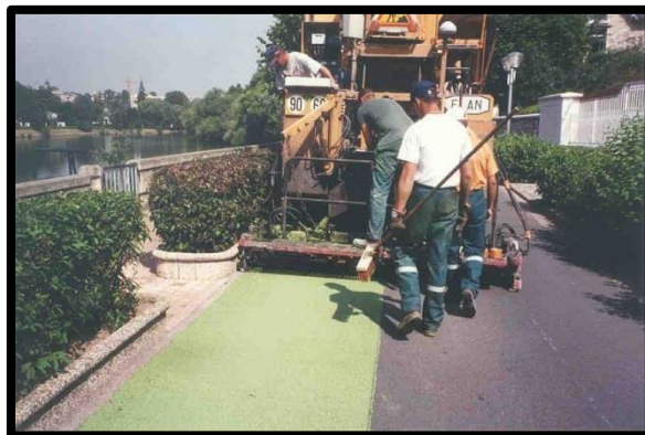
Figure 6.3 : Enrobé coulé à froid de couleur verte (France)
