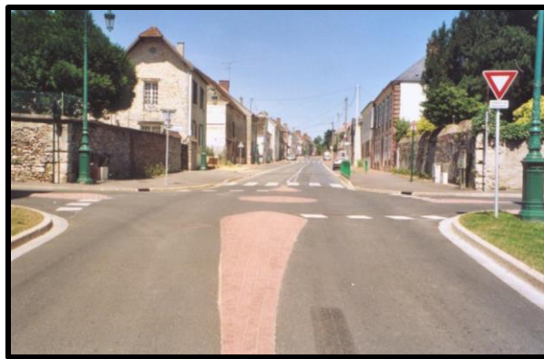
Figure 5.12: Insertion d'îlots (Villeneuve Les Sablons, France)
