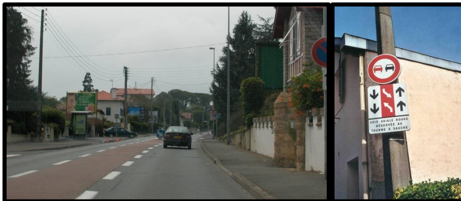
Figure 6.18 : Voie de tag en revêtement bitumineux coloré (Anglet, France)
