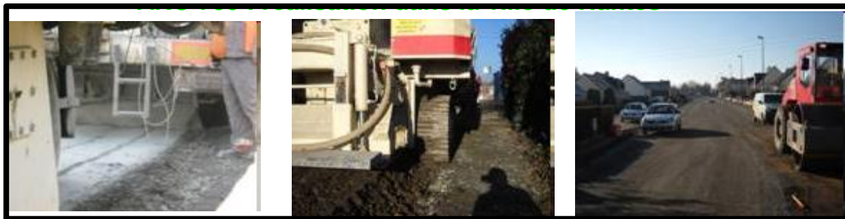
Figure 7.4 : Recyclage en place à froid (Nantes, France)
