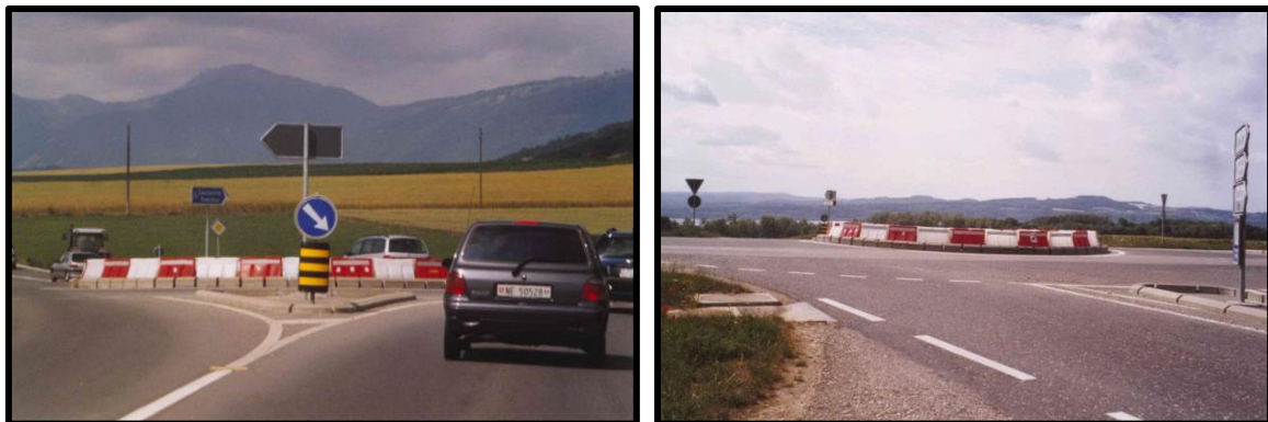
Figure 2.11 : Aménagements provisoires de carrefour giratoire (Route principale 5, Suisse)
