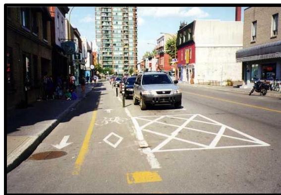
Figure 4.5 : Stationnement à proximité d'une piste cyclable (Montréal)
