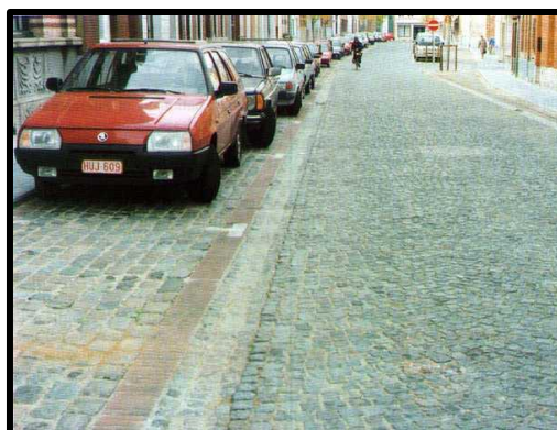
Figure 4.6 : Stationnement surélevé sur rue (Belgique)
