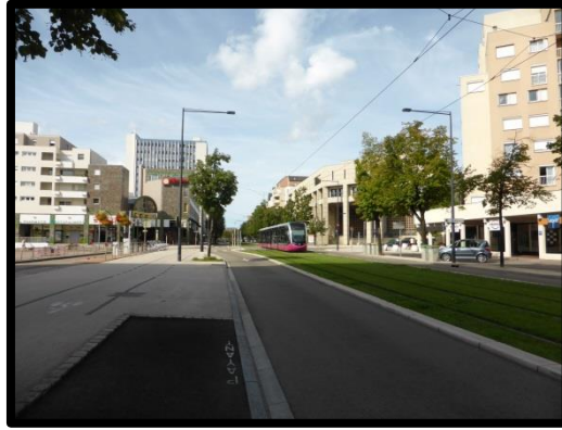
Figure 10.14 : Ligne de tramway à Dijon (France)
