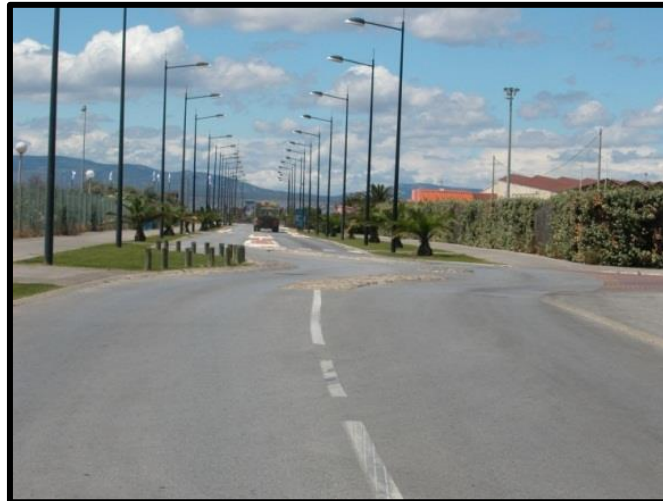
Figure 5.7 : Déviation de l'axe de la route (Barcarès, France)
