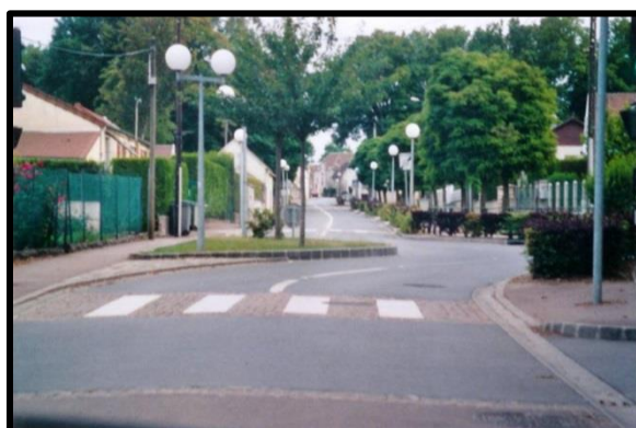
Figure 5.11 : Avancée de végétation (Survilliers, France)
