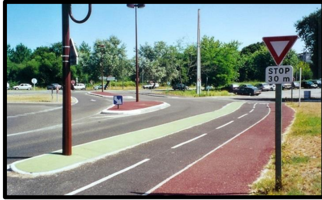
Figure 6.19 : Délimitation des voies en revêtements bitumineux colorés (Arcachon, France)
