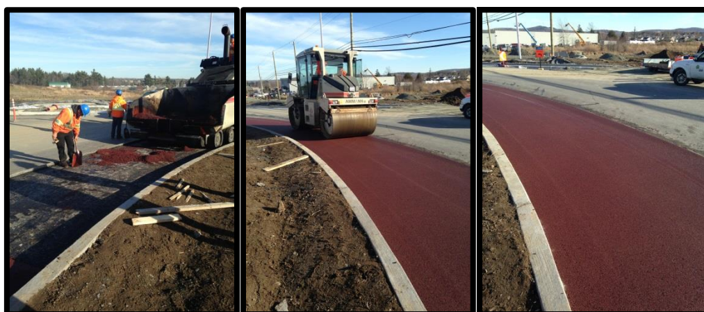
Figure 6.14 : Mise en place de l'enrobé coloré à Sherbrooke (Québec) Photographies : Julie-Michelle Fortin
