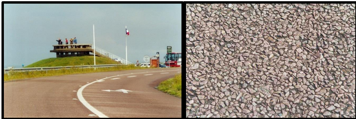
Figure 6.1 : Enduit superficiel d'usure (Arromanches, France)
