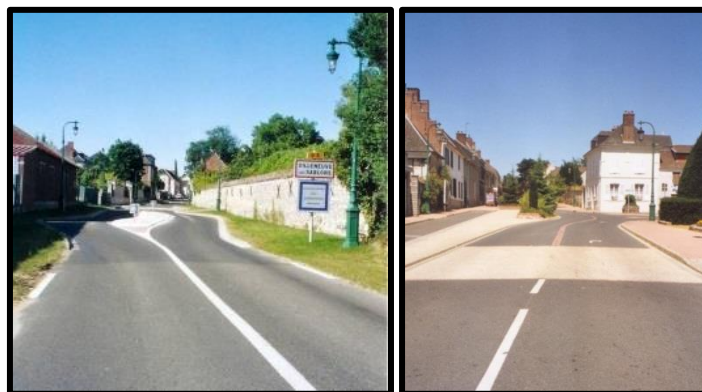
Figure 5.13: Décalage latéral de la chaussée (Villeneuve Les Sablons, France)
