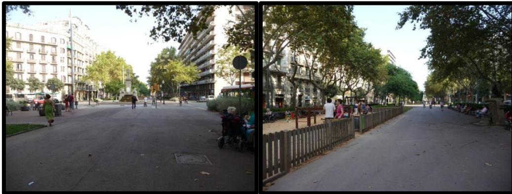
Figure 9.5 : Voie piétonne au centre de la chaussée à Barcelone (Espagne)
