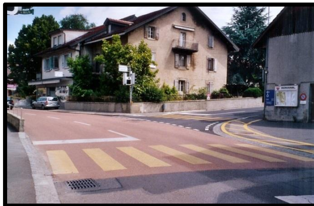
Figure 6.20 : Ralentisseur de trafic en revêtement bitumineux coloré (Lausanne, Suisse)
