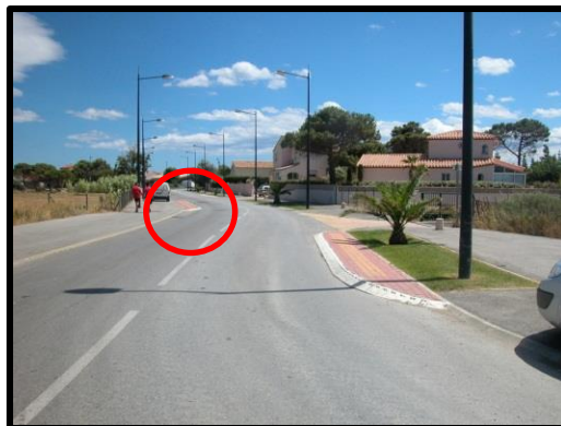
Figure 5.3 : Avancée de trottoir (Barcarès, France)
