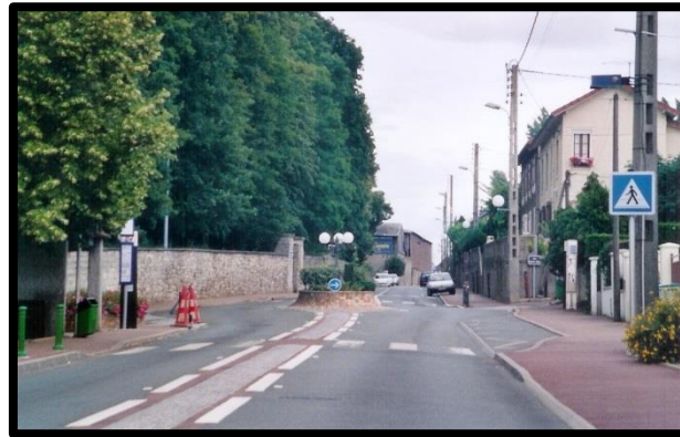
Figure 6.4 : Asphalté coloré (Surveilliers, France)
