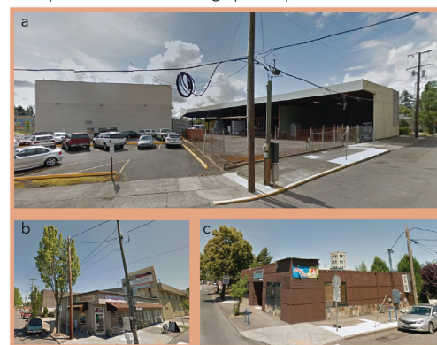
Bâti que l'architecte n'envisage pas de préserver
