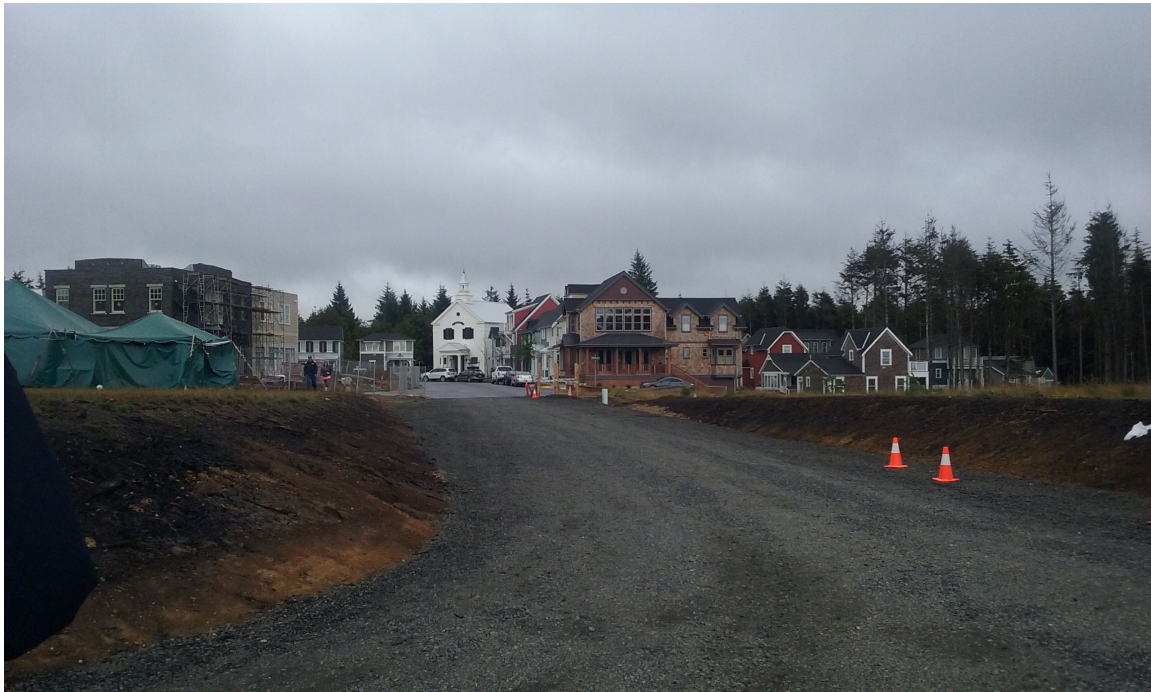
Figure 1. La ville de Seabrook. Vue sur le chantier et l'église. Source : R. Mullon
