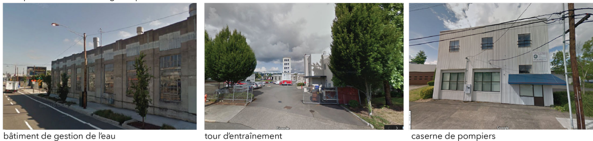
Bâti que l'architecte envisage de préserver dans les scénarios 3 et 4.
