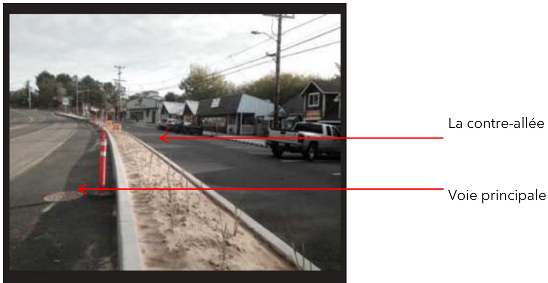
Figure 41. La contre allée. Source : photographie extraite de la présentation Powerpoint. Cas de Lincoln City. 1 er Octobre 2015. Flèches explicatives : R. Mullon.
