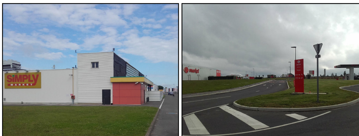
Figure 73 | Supermarché SimplyMarket situé en périphérie de Nesle (80) à gauche et Supermarché Carrefour Market situé en périphérie de Bonneval (28) à droite Photos : Damien Delaville
