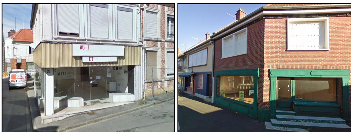
Figure 76 | Commerces fermés dans la rue principale de Nesle (80) Photos : Damien Delaville
