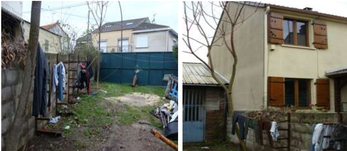
« Le refuge des Sorins vue du côté jardin, Montreuil, France » (Gadras, 2015)
