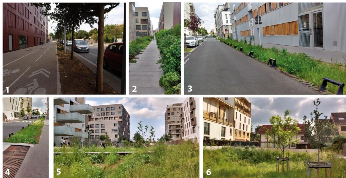
Figure 7.18 Photographies des noues et du bassin de retenue de l'écoquartier Hoche
