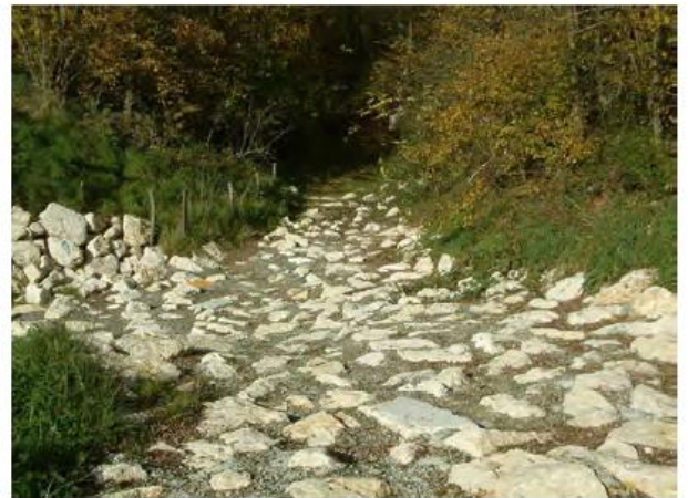
Photo 7 - Pavage du fond et berges de ravin limitant l'érosion (Cete Lyon)
