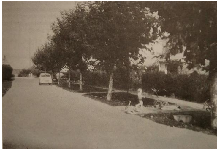
Figure 3 Photographie d'une chaussée équipée de fossés de récupération (IAURIF, 1982 : 21)
