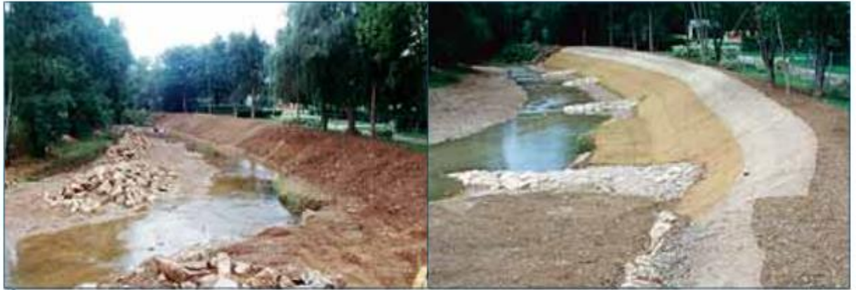
↑ Figure 11 : Travaux de démontage des empièvements existants (30.08.01) puis de réutilisation des blocs dans le cadre de la mise en place d'épis déflecteurs (18.09.01). ≡
