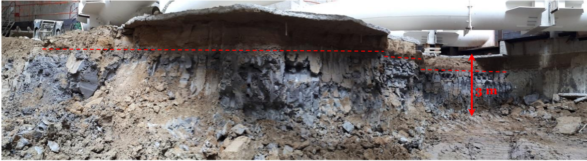
Figure 3-20 : Transition entre le Calcaire Grossier dégradé et les Argiles Plastiques pendant la phase de terrassement P4 54 m NGF
