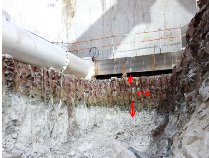
Figure 3-26 : Transition entre l'Argile Plastique et les Marnes de Meudon
