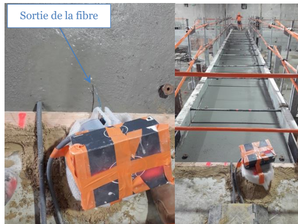
Fin du bétonnage
