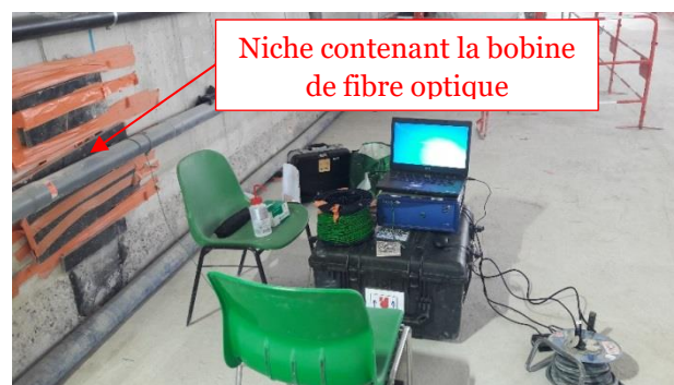
Figure 3-44 : Illustration du dispositif de mesure installé à côté de la niche contenant la bobine de fibre optique
