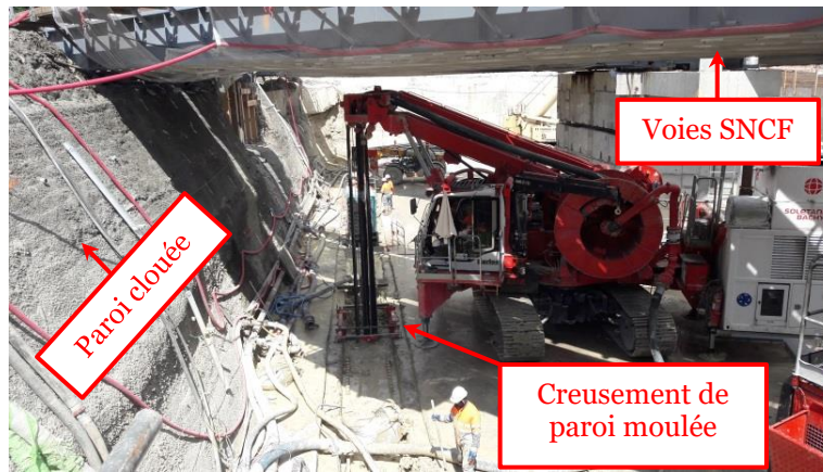
Figure 3-6 : Creusement des parois moulées de la zone centrale
