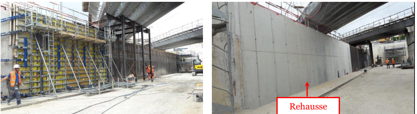
Figure 3-7 : Réalisation des rehausses dans la zone centrale
