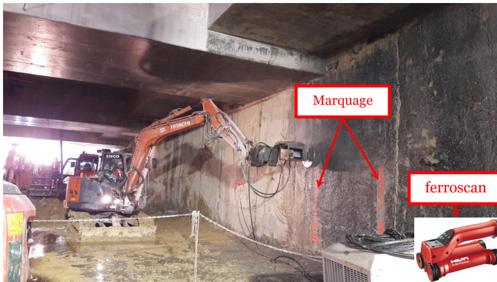
Figure 3-53 : Illustration du rabotage du panneau de paroi instrumenté et le marquage des barres instrumentées
