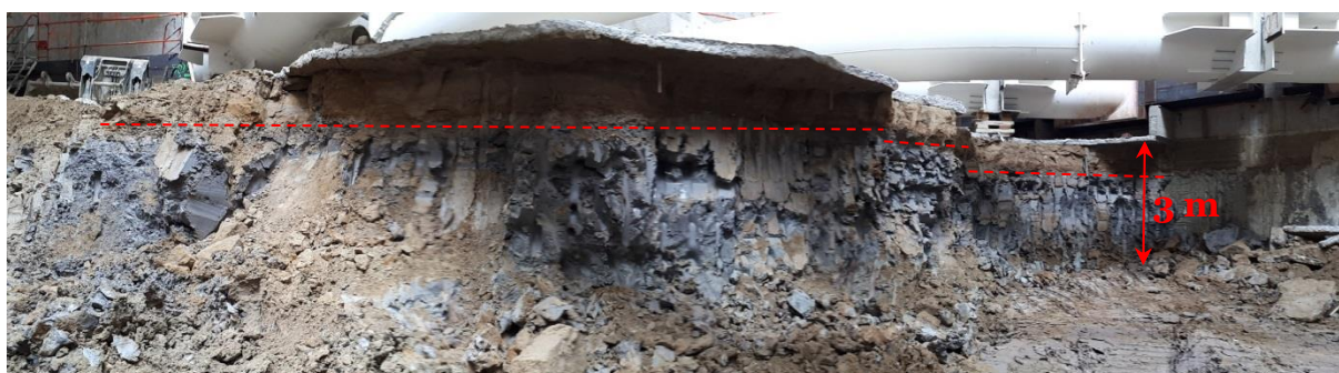
Figure 4-26 : Interface de transition entre le Calcaire Grossier et l'Argile Plastique parfaitement horizontale (marquée en trait pointillé rouge)
