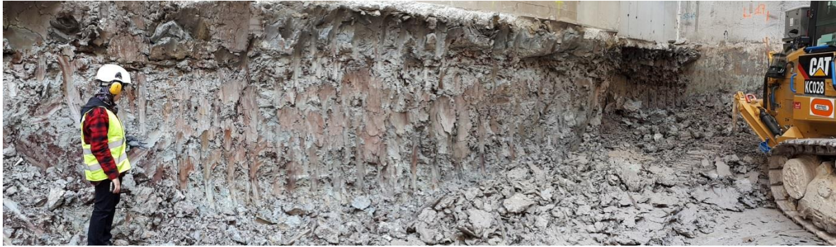
Figure 3-23 : Un front d'Argile Plastique entre 54 m NGF et 52 m NGF
