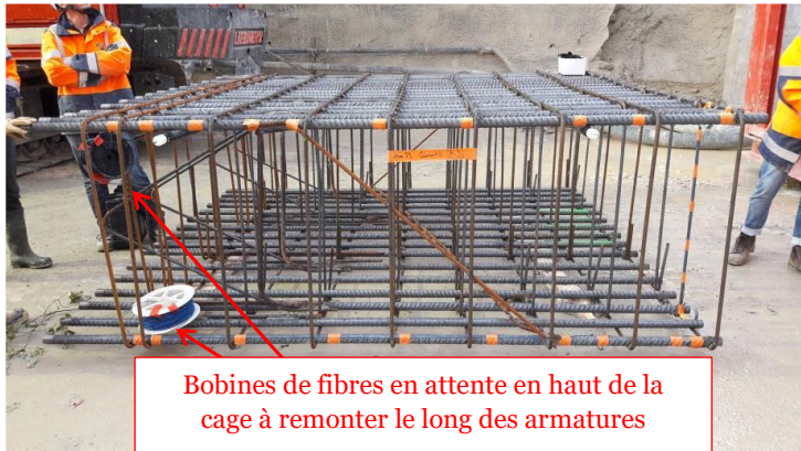
Figure 3-43 : Cheminement de la fibre optique à l'aide de deux bobines
