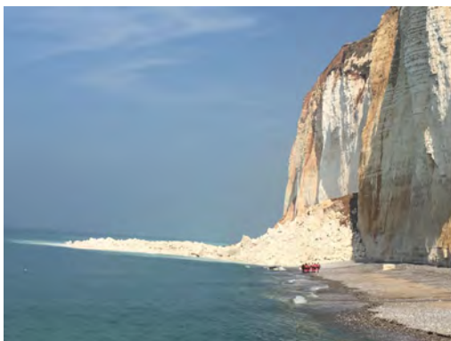
FIGURE 1.14 – Effondrement de la falaise des petites dalles (Saint-Martin-aux-Buneaux, Seine Maritime). La falaise est protégée de l'action des vagues pas les débris issus de l'écroulement
