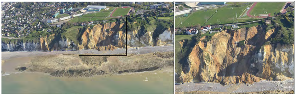
FIGURE 1.7 – Glissement de terrain à Dieppe (Normandie) menaçant la route et les habitations. Crédit T.Dewez
