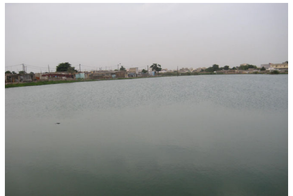
Photo 14 : Un des bassins de rétention de Djeddah Thiaroye Kao
