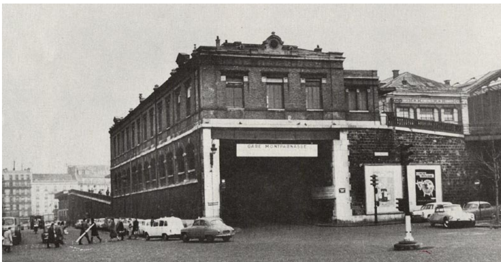
fig. 22 – Accès aux rampes, façade sud aux abords du Viaduc du Maine. Source : N/A
