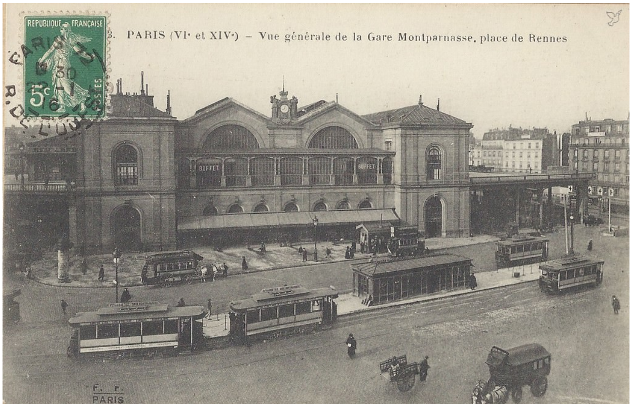
fig. 20 – Façade principale de la gare Montparnasse en 1900. Source : N/A
