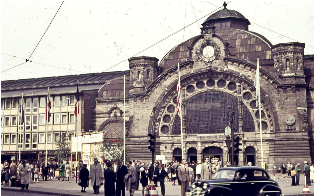
fig. 106 Photo de la façade de Cologne en 1950 – à Gauche, aile nord-est reconstruite - bilderbuch-koeln.de
