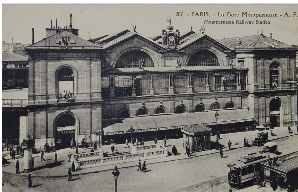
fig. 23 – Façade principale de la gare et accès à l'escalier du métropolitain. Source : SNCF Sardo
