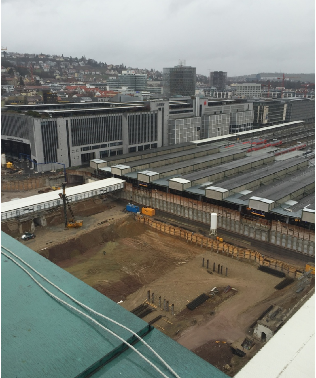
fig. 184 : Chantier de la Stuttgart HBF, le 25 mars 2016 - NLB
