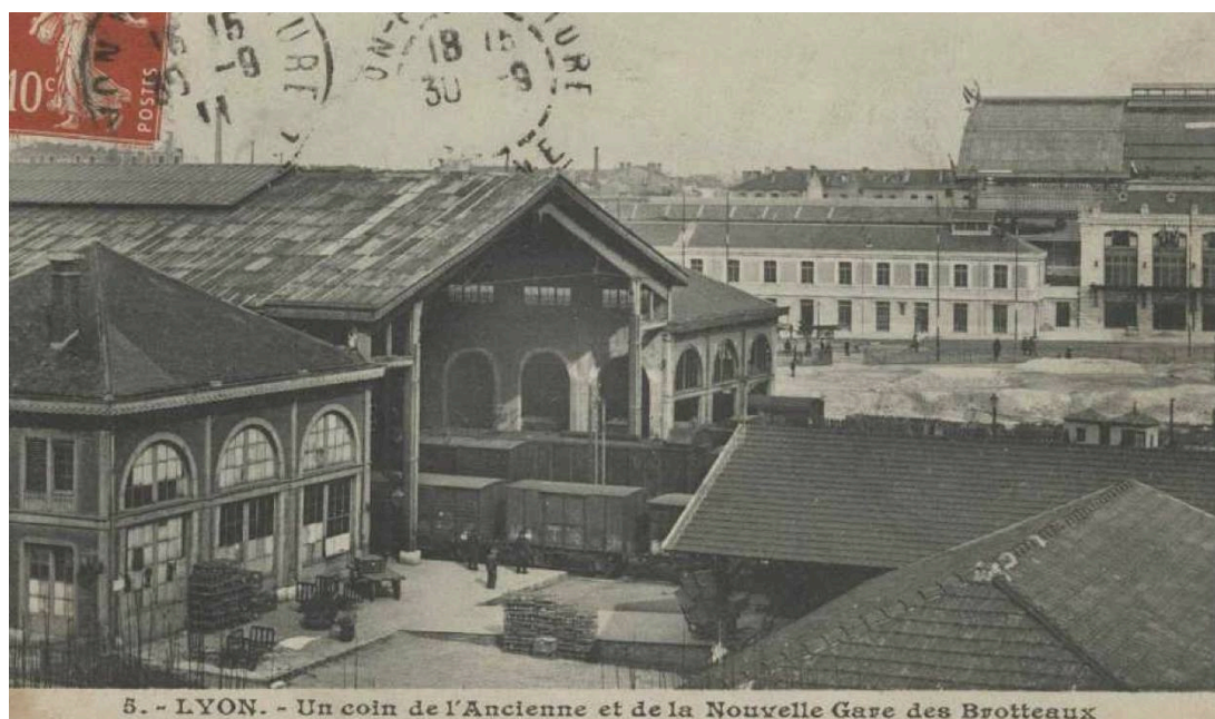
fig. 72 Vue de la façade sud de la première gare des Brotteaux – Archives NLB
