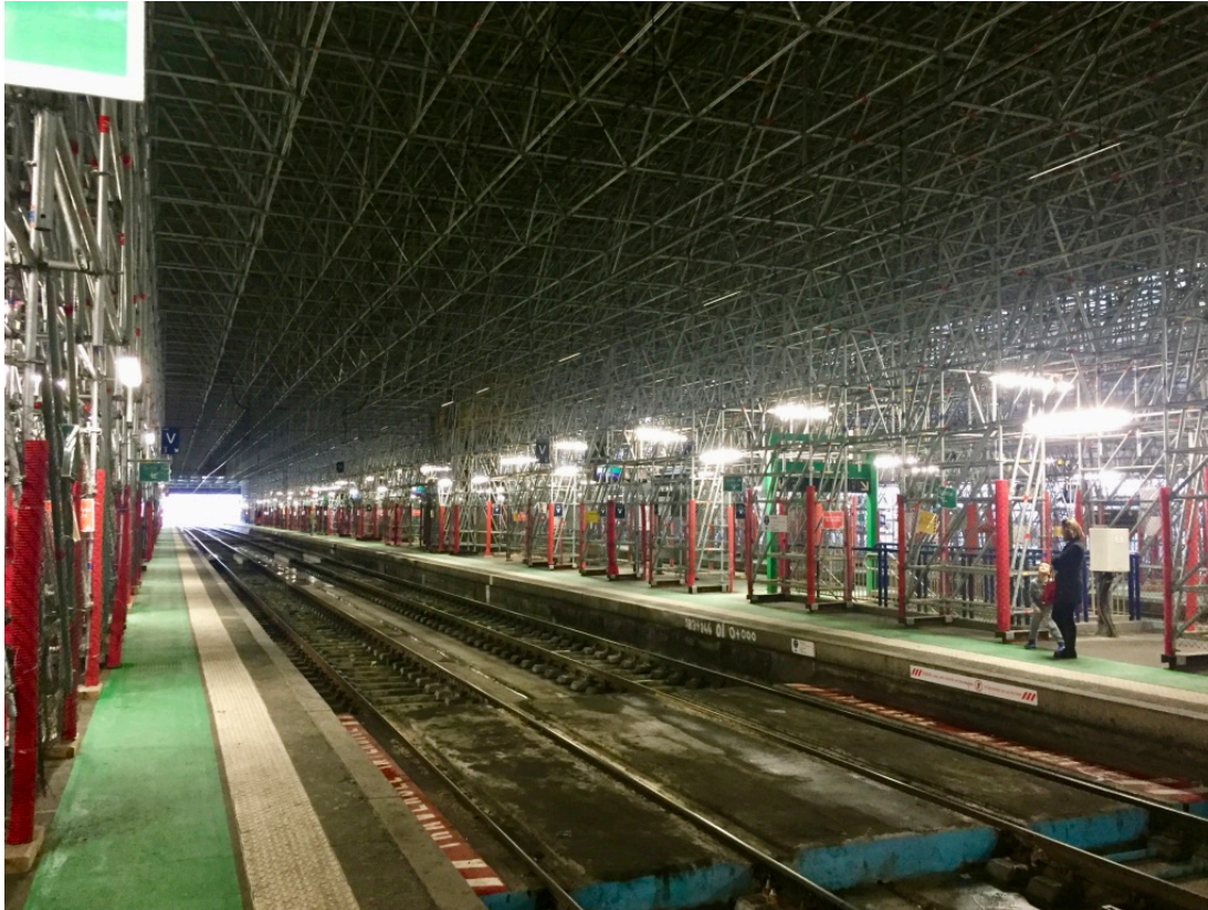
fig. 183 : Échaffaudage pour la rénovation de la halle voyageur de Bordeaux St-Jean, le 23 janvier 2016 - NLB
