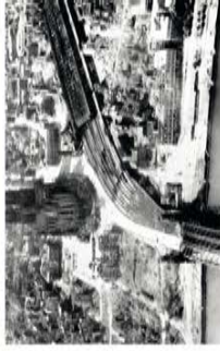
Gare détruite après 1945
