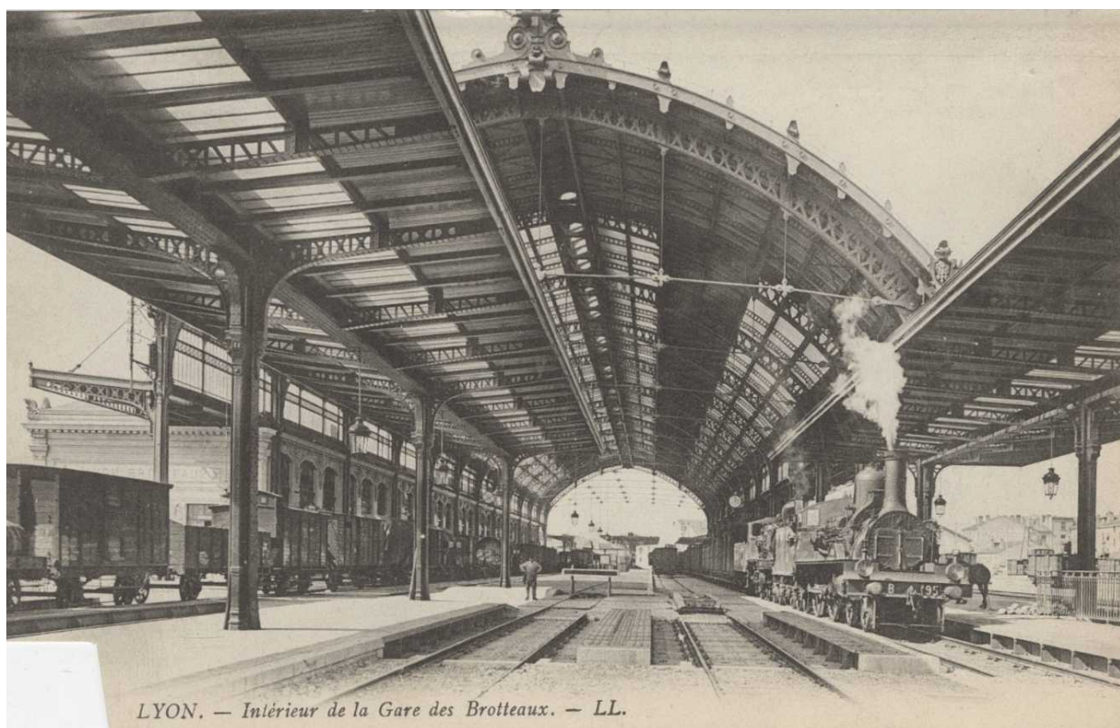
fig. 80 Carte postale des voie, quais et halle ferroviaire de la nouvelle gare des Brotteaux de 1910 – Archives de la ville de Lyon
