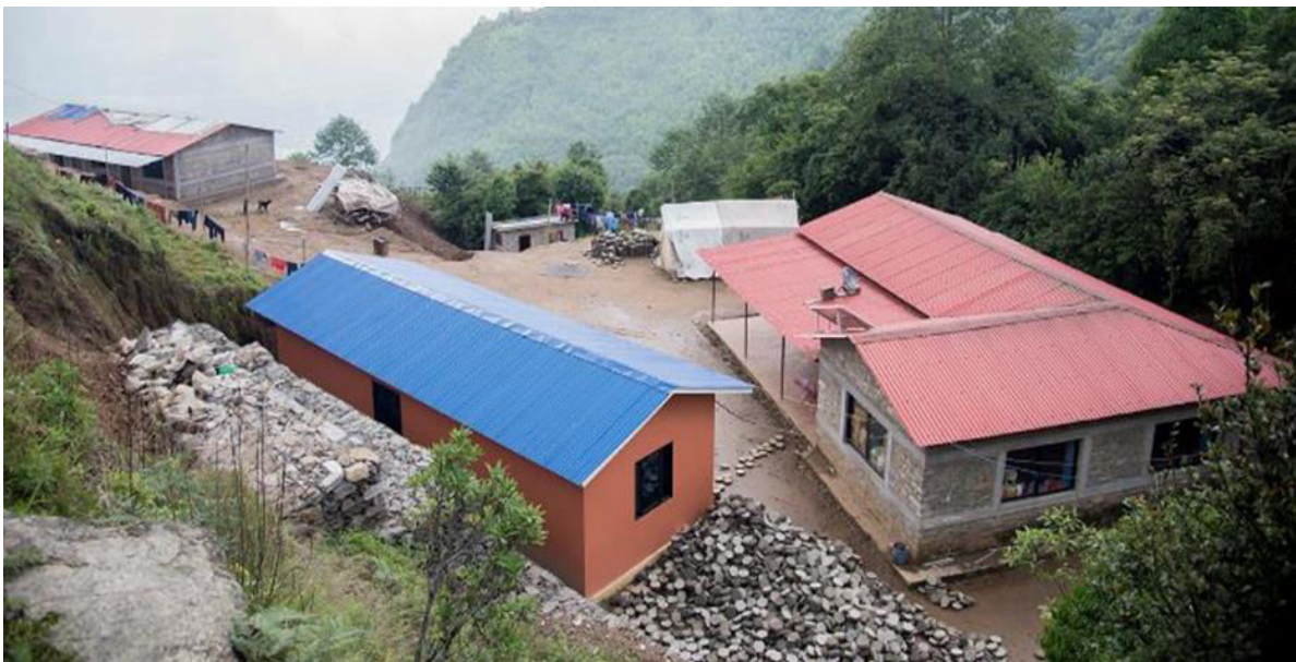
Photo 89 – Le centre de réhabilitation de Dolakha – avril 2017 © CPCS
