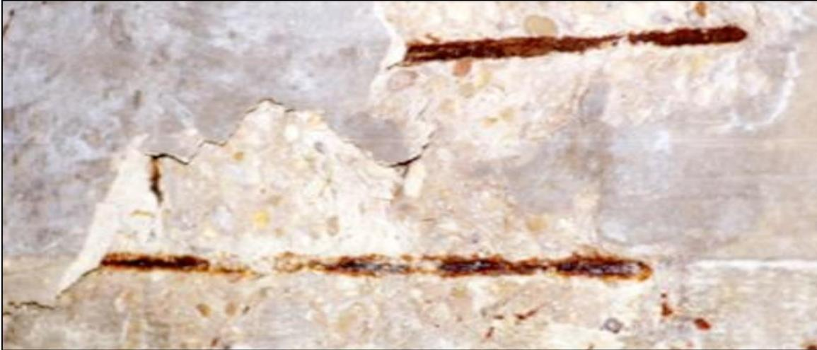
**Figure II. 1** : Délamination et éclatement du béton [5]
