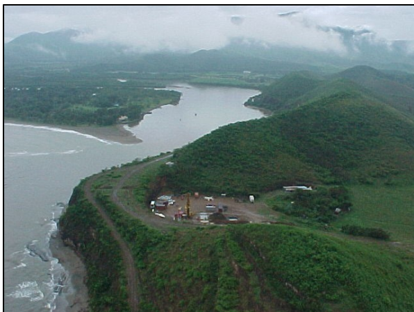
Figure II-1 : Photo aérienne du site de forage CADART-1 au niveau de l'embouchure de la rivière Nera - (France, 2000)
