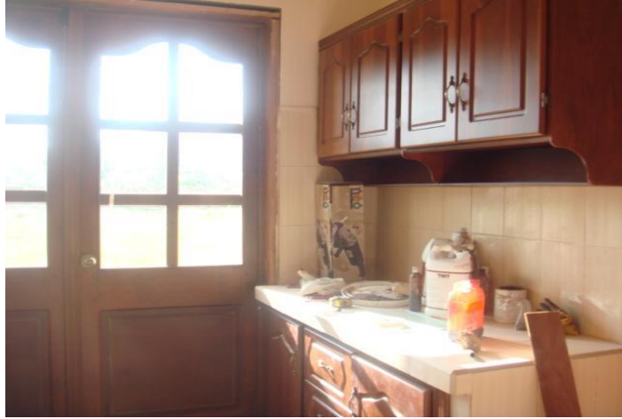
Photo 5 : L'Hôpital San Luis de Otavalo, Maison des accouchements en construction, cuisine commune, 2009. Source : María Fernanda Acosta A.
