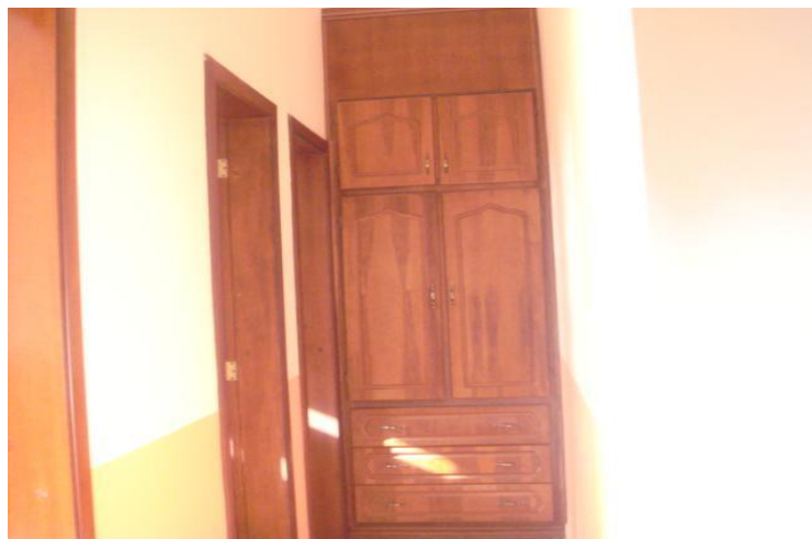
Photo 4 : L'Hôpital San Luis de Otavalo, Maison des accouchements en construction, couloir et portes des chambres, 2009. Source : María Fernanda Acosta A.
