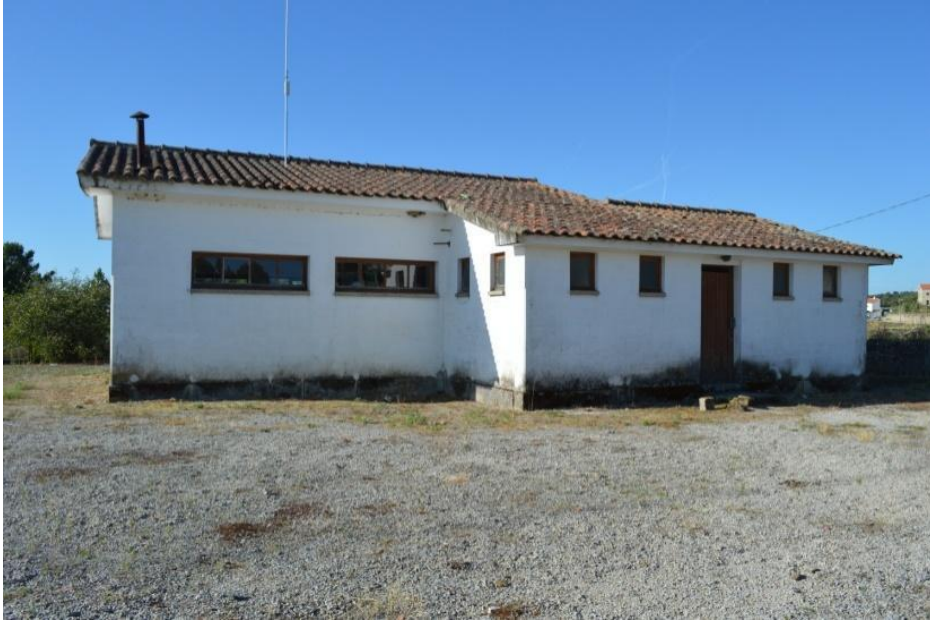
Photo 97 : École fermée, vue de l'extérieur
