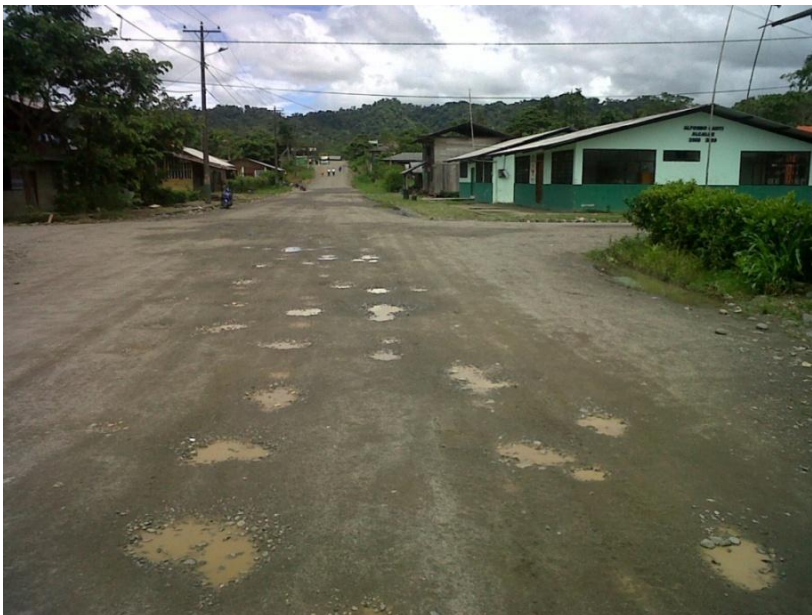
Photo 9 : Agglomération d'Arajuno, rue transversale à l'autoroute.
