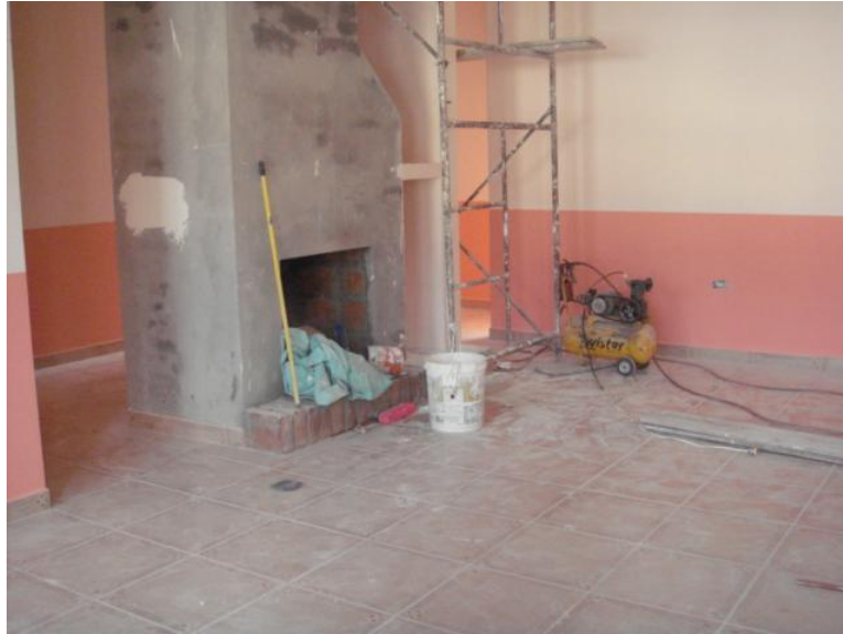
Photo 3 : L'Hôpital San Luis de Otavalo, Maison des accouchements en construction, salon, 2009.
