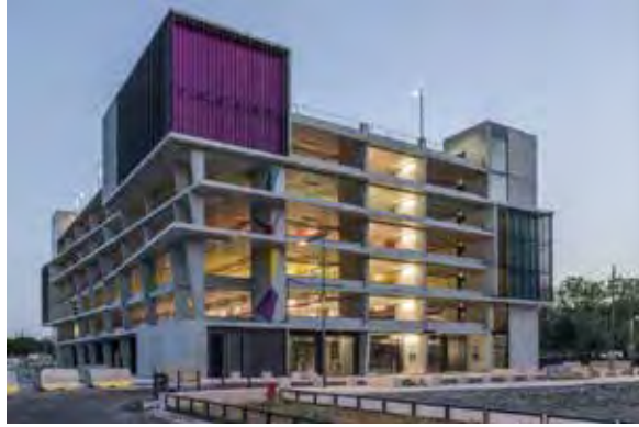
Figure 30 Un parking silo dans le quartier de la Cartoucherie à Toulouse (Source : Sequences.fr)
