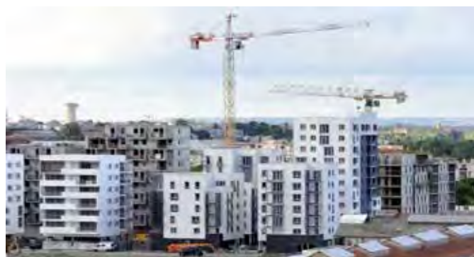
Figure 38 La Cartoucherie construite à partir de 2012 (Source : Ladepeche.fr)
