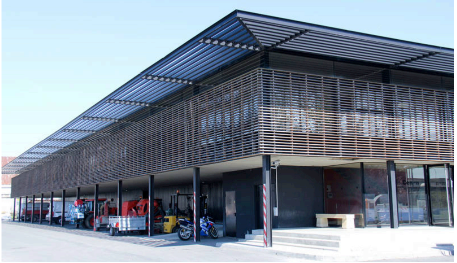
Figure 87. Le centre technique de la ville de Cenon a été réalisé par les architectes Marjan Hessamfar & Joe Vérons en 2008. Source : Marjan Hessamfar & Joe Vérons.
