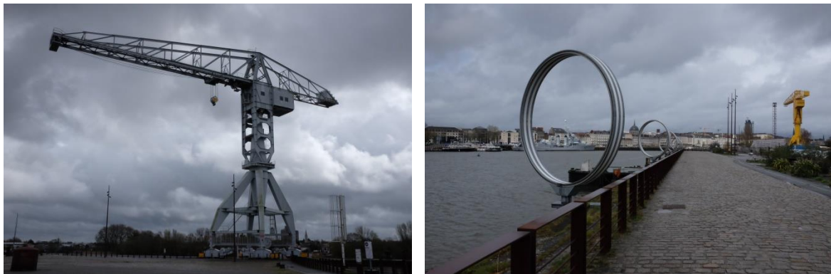
Photographies 14. L'île de Nantes. A gauche : la grue de déchargement. A droite : les anneaux de Buren et la grue de levage (clichés : Le Lay Y.-F., 2018)
