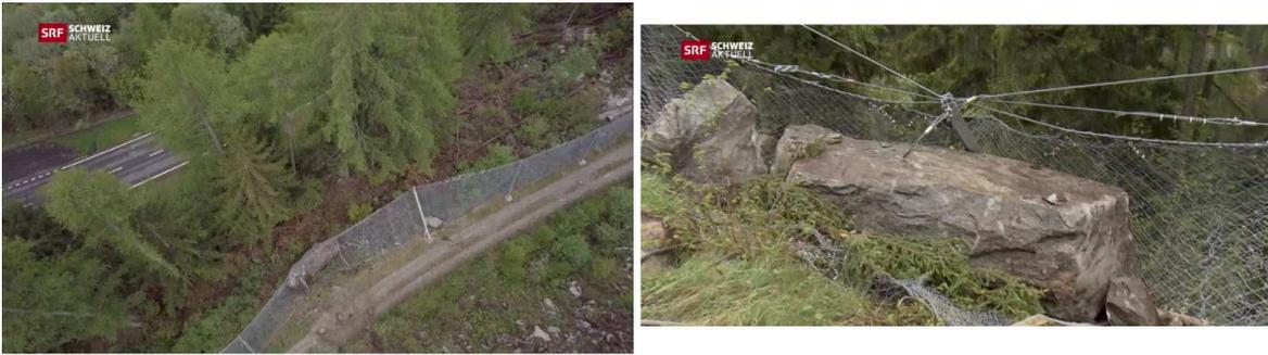
FIGURE 1.28 – Filet de protection flexible après éboulement rocheux dans le Val d'Hérens, près d'Evolène (Suisse). La zone est suivie depuis très longtemps, et présentait récemment des mouvements excessifs. Grâce à un système d'alerte, la population a reçu l'alerte suite à l'évènement en détectant la rétention par l'ouvrage d'un bloc d'environ 20 mètres cubes.
