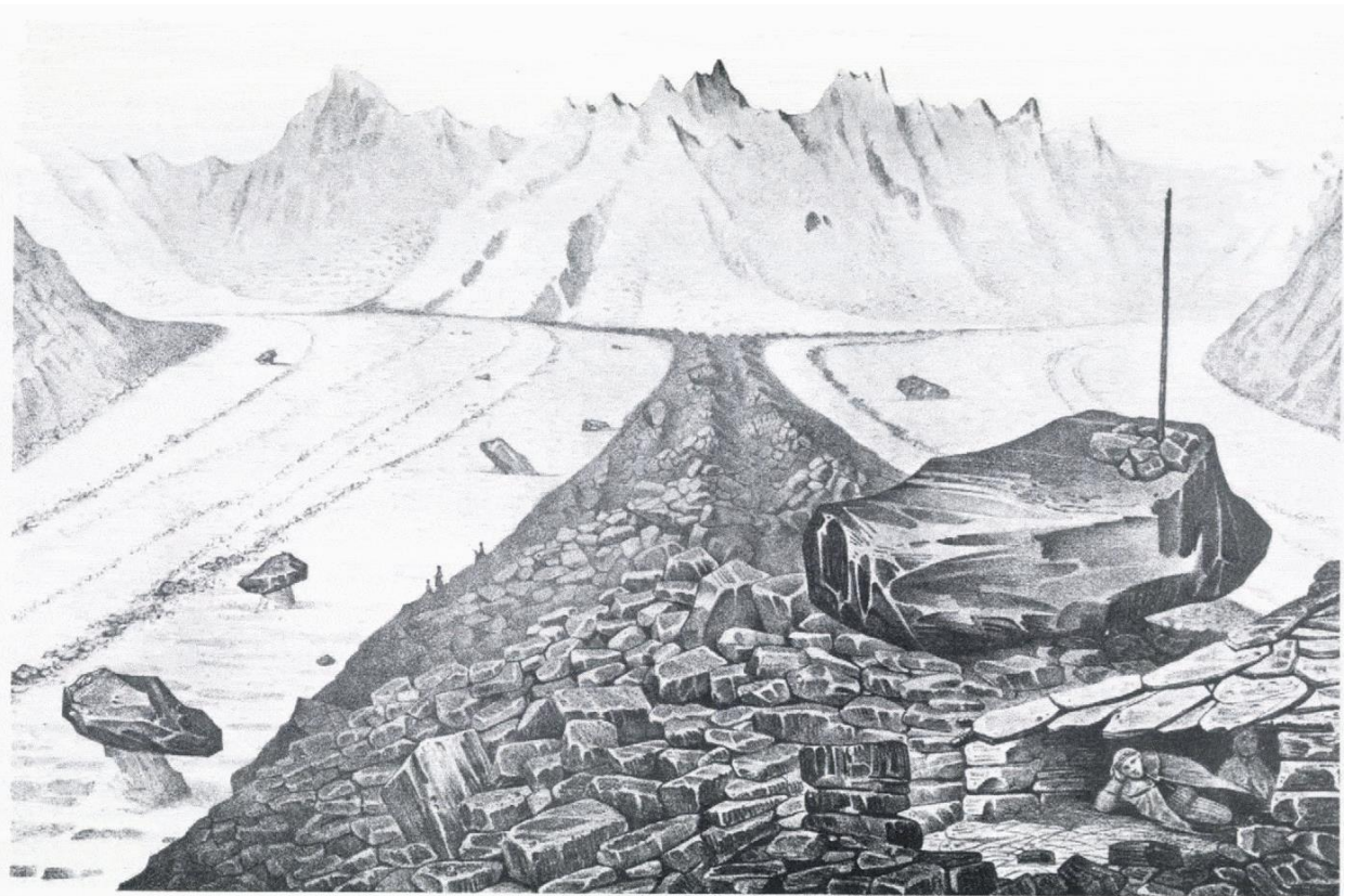
Figure 1 : Figure et légende traduites et extraites de Walker and Waddington, (1988). "Abri construit par Hugi en 1842 sur la moraine médiane de l'Unteraar, sous la confluence du Lauteraar (à gauche) et du Finsteraar (à droite). Cet abri, construit à la base de l'éperon rocheux au centre de l'image a atteint l'endroit représenté en 13 années. Cette moraine a été l'endroit où Agassiz installa l'Hôtel des Neuchâtelois pendant ses recherches en 1840."
