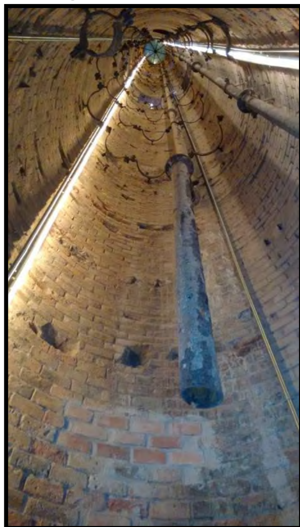
Image 11. L'intérieur de la tour
