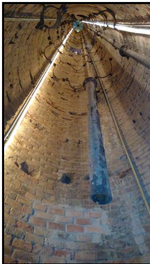
Image 11. L'intérieur de la tour
