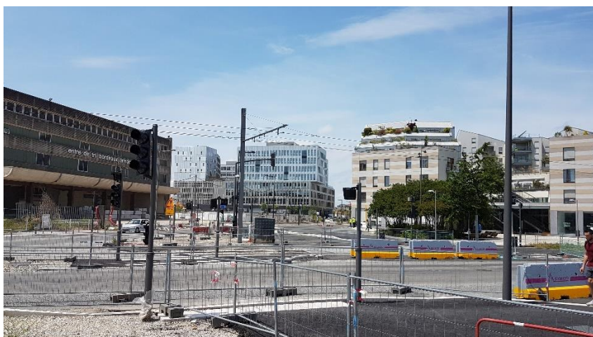
Figure 47 - Carrefour Beck en chantier, mai 2019, secteur Armagnac. Source : photographie prise par l'auteure
