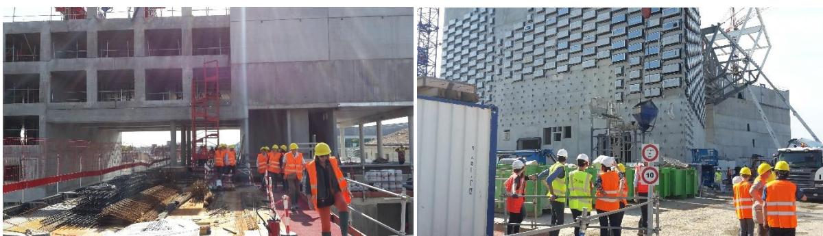
Figure 55 - Visite de chantier du quai de Paludate organisée dans le cadre de la Biennale Agora 2017. Source : photographies prises par l'auteur
