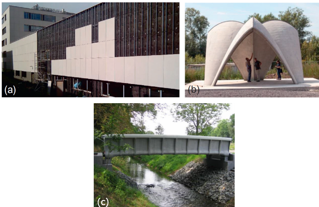
Figure 0.1 – Exemples d'application des TRC préfabriqués : (a) panneaux de façade, (b) éléments de coque légers et (c) passerelle pour piétons [2]
