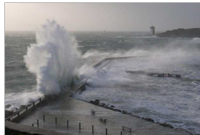
Figure 173 – Le port du Conquet, à l'entrée de la ria, est mal protégé des fortes houles en cas de tempête.
