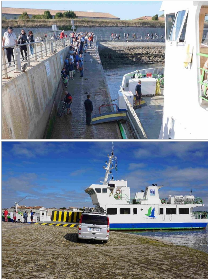
Figure 220 – Embarquement de passagers à la jetée Barbotin et embarquement de véhicules à la cale Napoléon à Aix La jetée Barbotin est trop étroite pour l'embarquement de véhicules (haut) contrairement à la cale Napoléon (bas) (Crédit MG 2016)
