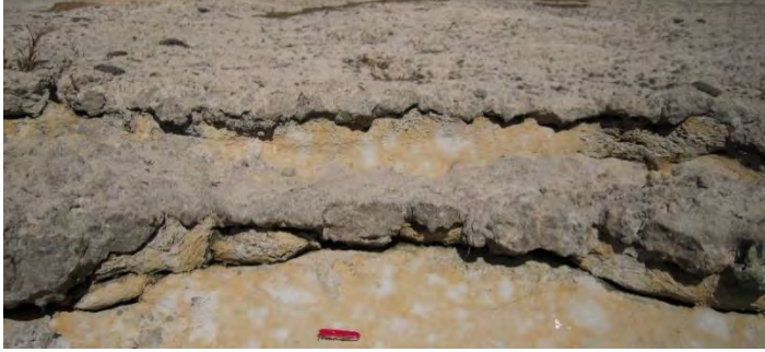
Figure 3.3 : Alternance de niveaux indurés marno-calcaire en gris et tendres marno-sableux en ocre dans la molasse stampienne. La photo présente la bordure de seuil en rive gauche le long du chenal central (Fig. 3.2).
