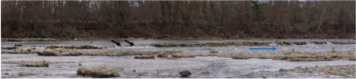
Figure 3.70 : Photographie du seuil de Portet-sur-Garonne en période de hautes eaux. La flèche bleue représente le chenal et le sens de l'écoulement et les flèches noires représentent l'écoulement oblique par rapport au chenal lors de la mise en eau du seuil pendant une crue (Photo personnelle).
