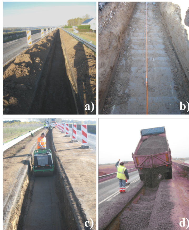
FIGURE V.4 – a) Réalisation de la tranchée côté val, b) mise en place des électrodes, c) compactage du remblai et d) mise en place de la couche de forme (photo côté Loire). Modifié d’après Hupin and Hervé (2009).
