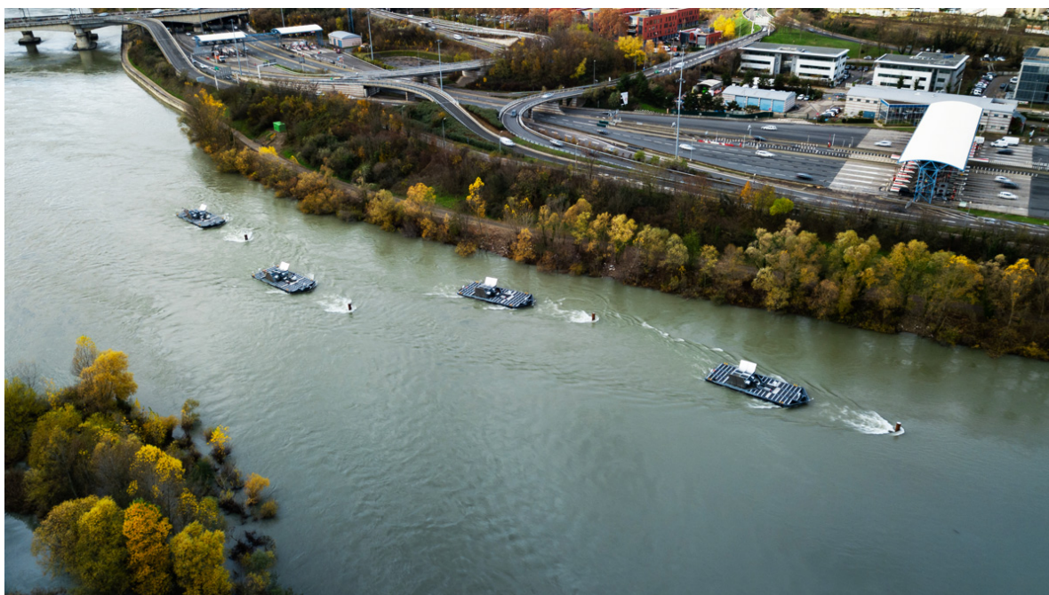
Figure 1.5 Photographie des quatre hydroliennes fluviales disposées sous leurs barges flottantes, installées par Hydroquest à Calluire-et-Cuire en décembre 2018 ©Hydroquest
