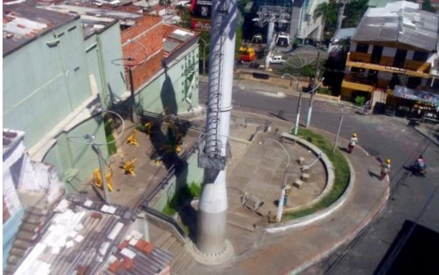
Photo n°49 : Exemple de requalification des rues et d'aménagements sous les pylônes, ici des équipements sportifs © D. Giney
