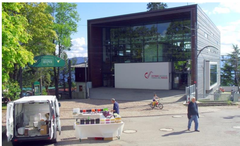
Photo n°40 : Gare amont à SopraBolzano, sur le plateau du Renon. © D. Giney, 2016
