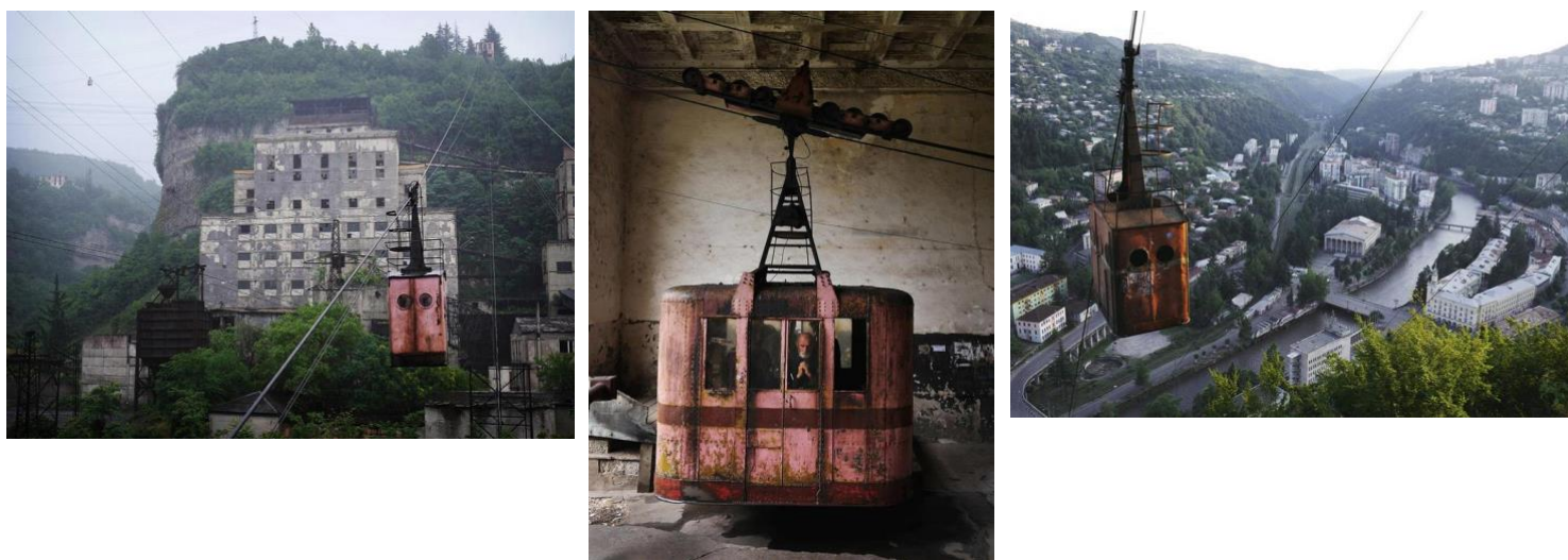
Photos n° 22 : Téléphériques de Tchiatura, en Géorgie, une ville construite autour du câble ©Amos Chapple
