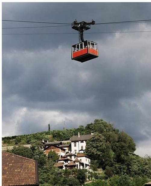
Photo n°37 : L'ancien téléphérique va-et-vient en service de 1966 à 2007. Source : Herbert Ortner
