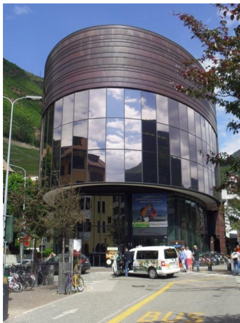
Photo n°39 : Gare aval de Bolzano. © D. Giney, 2016
