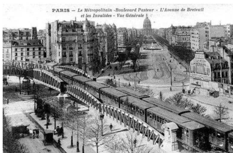
Photo n° 2 : Métro aérien dans les années 1900. Ici sur le boulevard Pasteur, Paris 15e © lartnouveau
