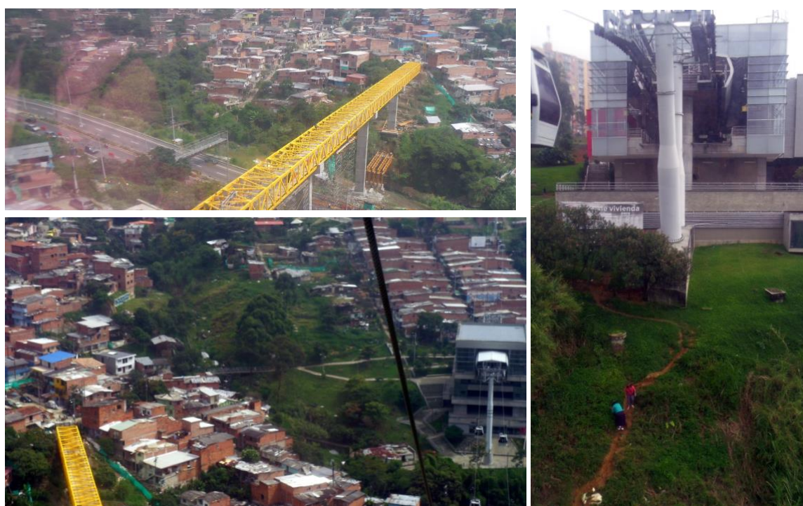
Photos n° 12 : Exemples de passages aménagés (photos de gauche, passerelles et cheminements piétons) et non aménagés (photo de droite) à Medellín (ligne J, Colombie). © D. Giney, 2016
