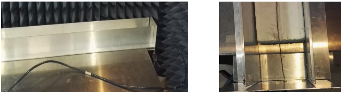
Figure 4-34 : Un conducteur à l'intérieur d'une goulotte avec des panneaux aux extrémités
