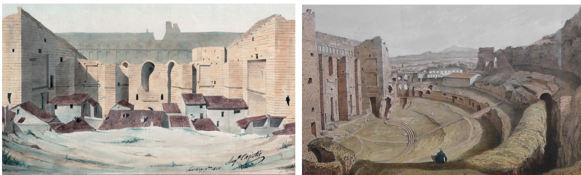
(a) Vue de la scène avant le déblaiement par A. Caristie 9 . (b) Vue intérieure du théâtre par Asselineau 10 .
