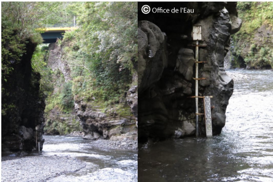
Figure 26. Dispositif de mesure de hauteur d'eau déployé par l'Office de l'Eau sous le Pont de l'Escalier (Crédit photo : Office de l'Eau).
