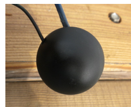
Figure 3.2 – Cliché d'un globe noir en toiture.
