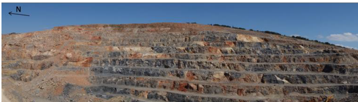
Figure 6 : Front Est de la carrière GSM, les surfaces claires correspondent aux failles normales décamétriques étudiées. Elles sont fréquemment réutilisées par la karstification tardive. Les gradins mesurent 7 m de haut.
